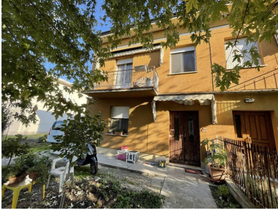
Esterno 1 (fronte SUD)
