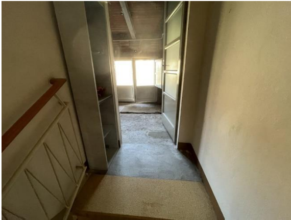
Interno 9-10 (Piano 2 soffitta)
