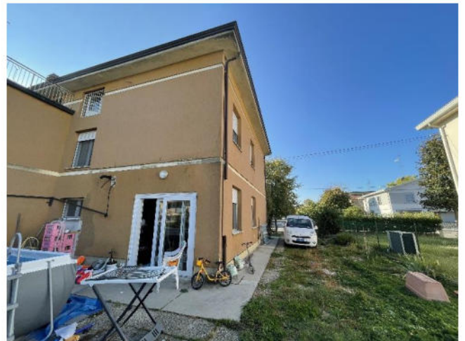
Esterno 3 (fronte NORD)
