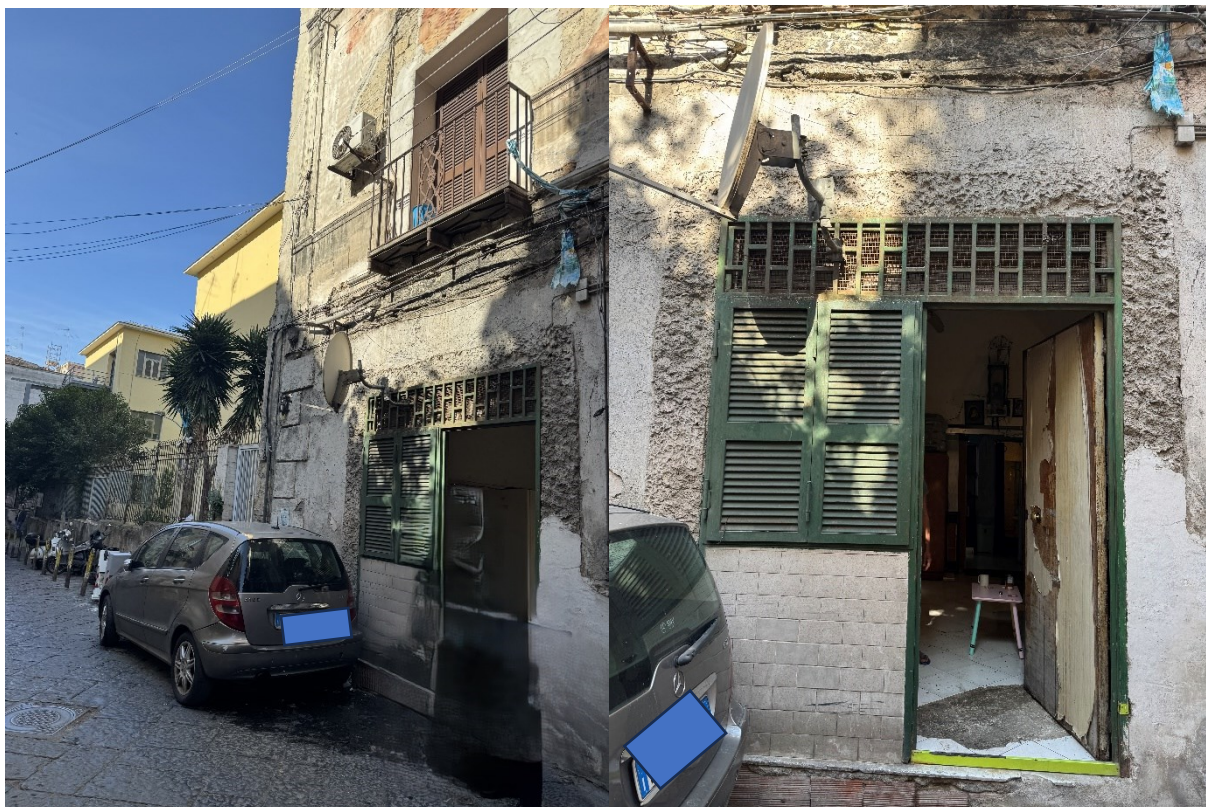
FIGURA 7-8: ESTERNI INGRESSO AL BENE
