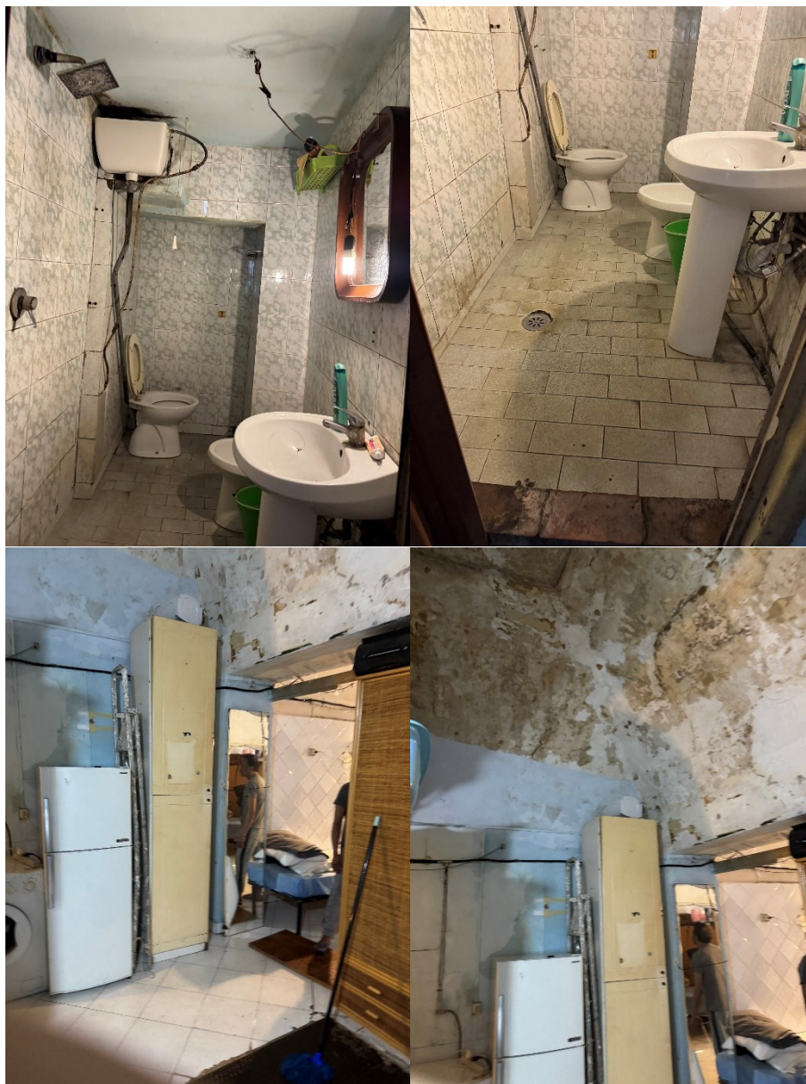
FIGURA 21/24: BAGNO E ANTIBAGNO
