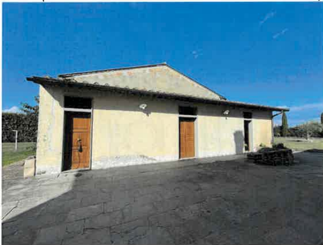
FOTO 31 (vista esterna da resede a comune locale accessorio – LOTTO 4)
