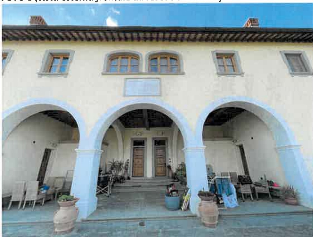
FOTO 6 (vista esterna frontale da resede a comune)
