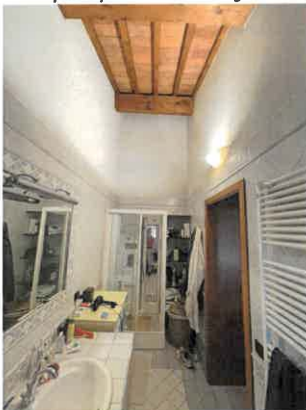
FOTO 22 (vista interna piano primo su servizio igienico – LOTTO 4)
