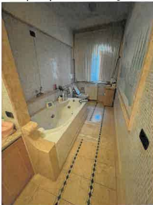
FOTO 18 (vista interna piano primo su servizio igienico – LOTTO 4)
