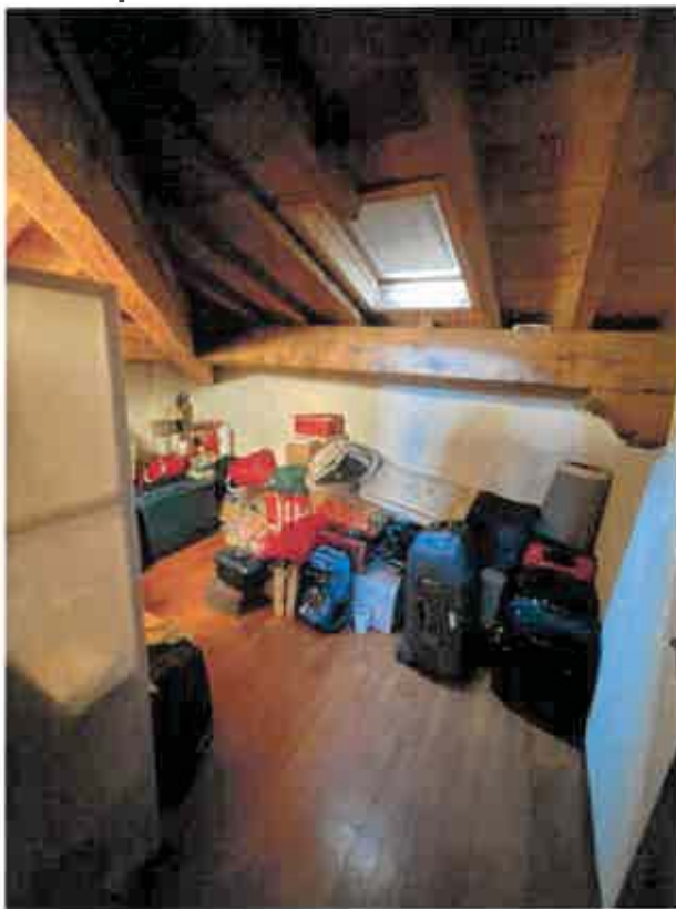
FOTO 30 (vista interna piano secondo su sottotetto – LOTTO 4)
