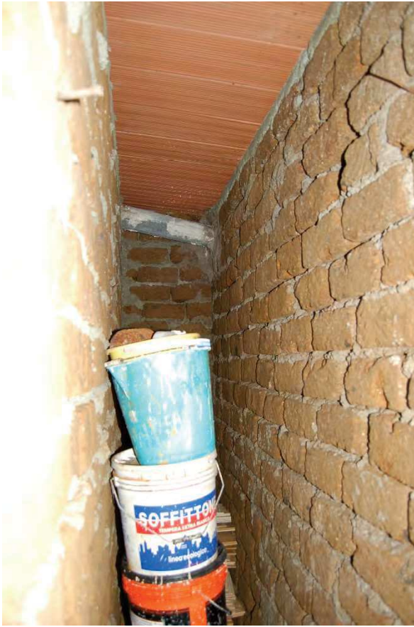
Foto 65 – Vista dell'intercapedine controterra e della feritoia d'areazione
