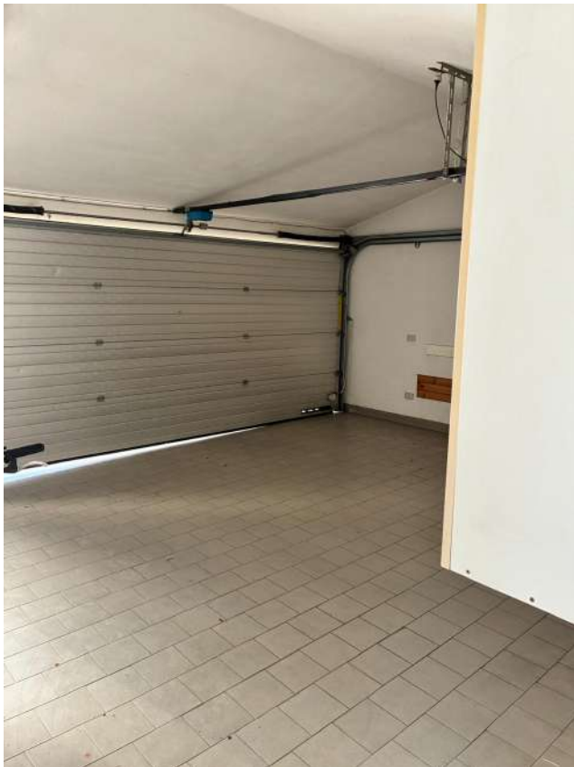
Vista interna autorimessa
