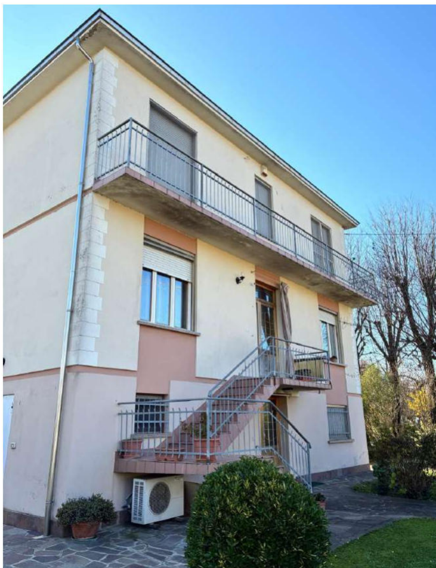
Vista esterna nord/est
