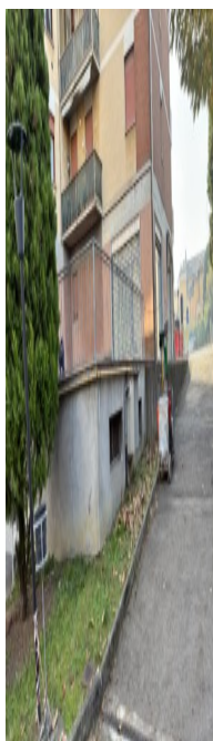
Vista esterna contesto condominiale
