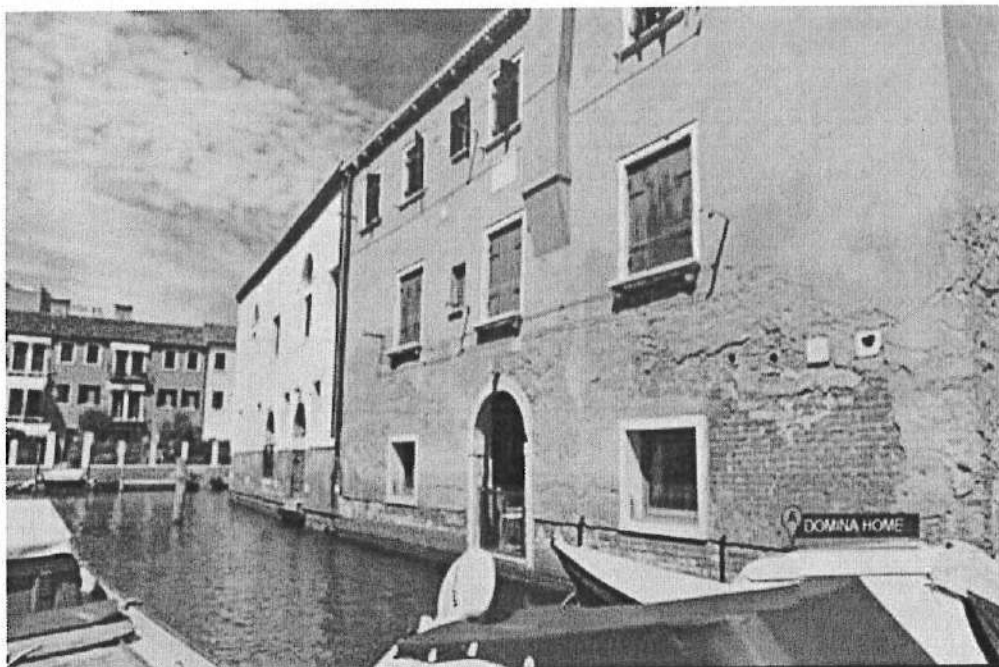
Foto n.5 – Vista laterale del fabbricato dal Rio della Palada
