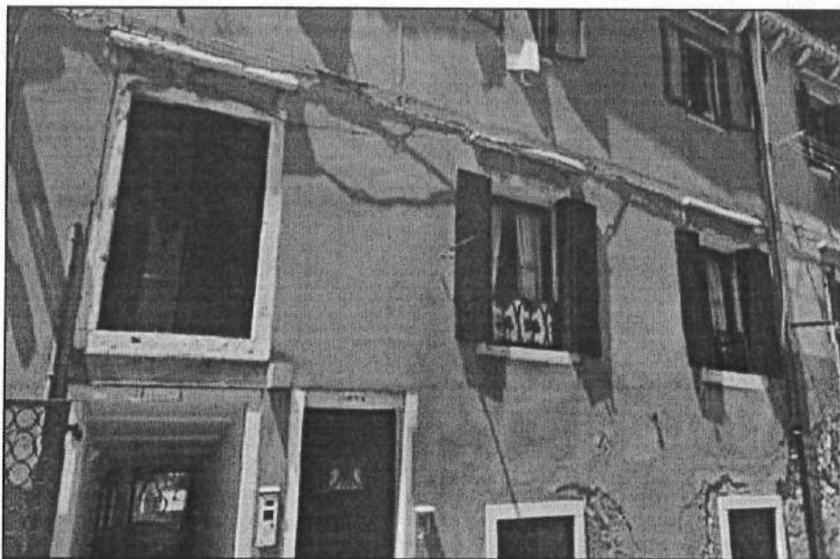
Foto n.9 – Vista entrata del fabbricato da Corte Ferrando
