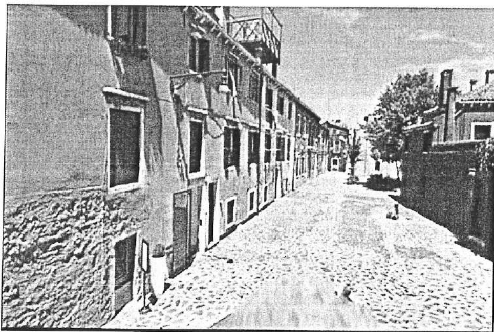
Foto n.11 – Vista della strada di accesso al fabbricato – Corte Ferrando
