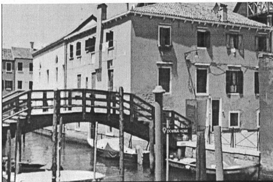
Foto n.6 – Vista angolare del fabbricato da Rio della Palada
