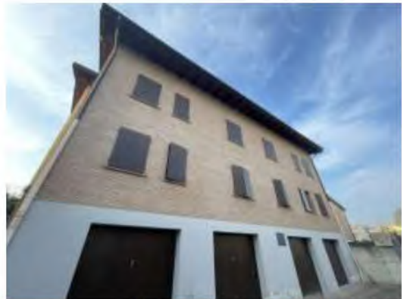
Esterno 4 – Prospetto Nord –
