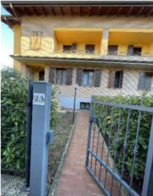
Esterno 1 - Prospetto Sud
