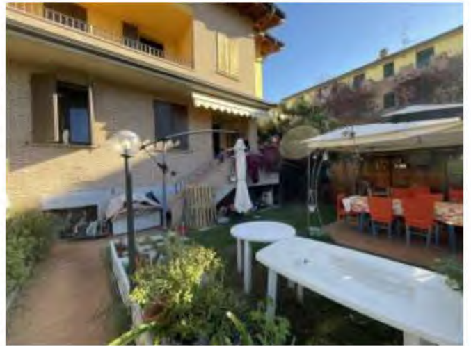
Esterno 2 – Vista dal cortile
