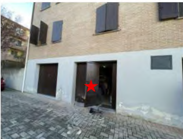
Esterno 5 – Prospetto Nord accesso garage.
