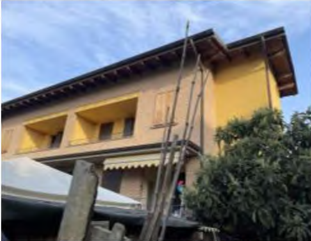
Esterno 1 - Prospetto Sud/ Sud-Est
