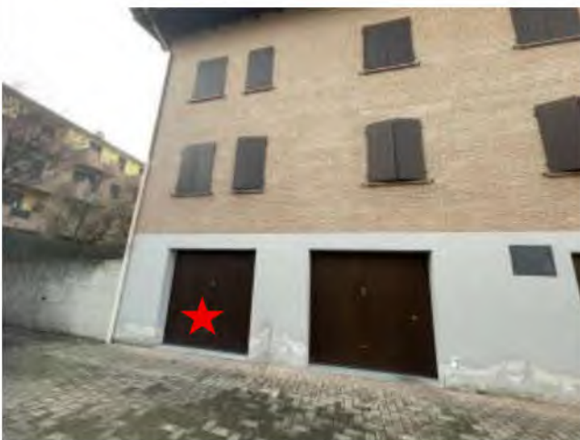
Esterno 5 – Prospetto Nord
