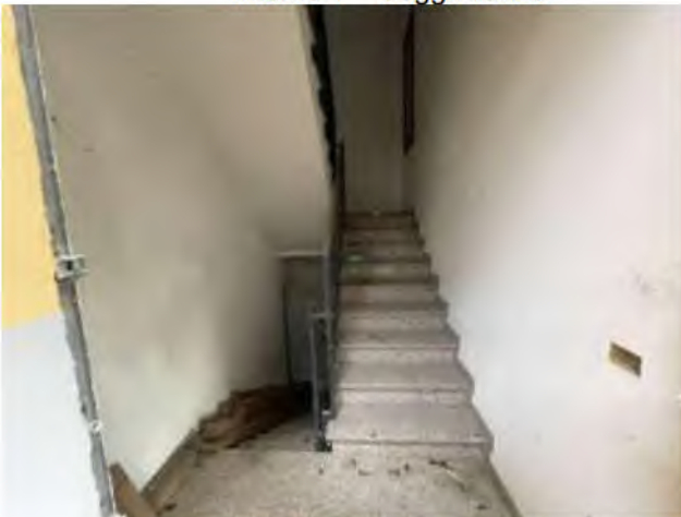
Interno 3 – vano scala
