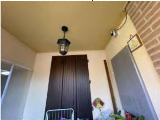
Esterno 3 – Portico di accesso
