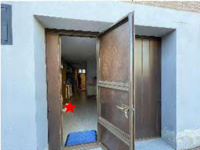
Esterno 5 – Prospetto Nord- autorimessa
