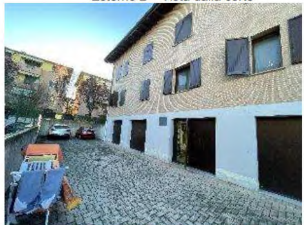
Esterno 4 – Prospetto Nord
