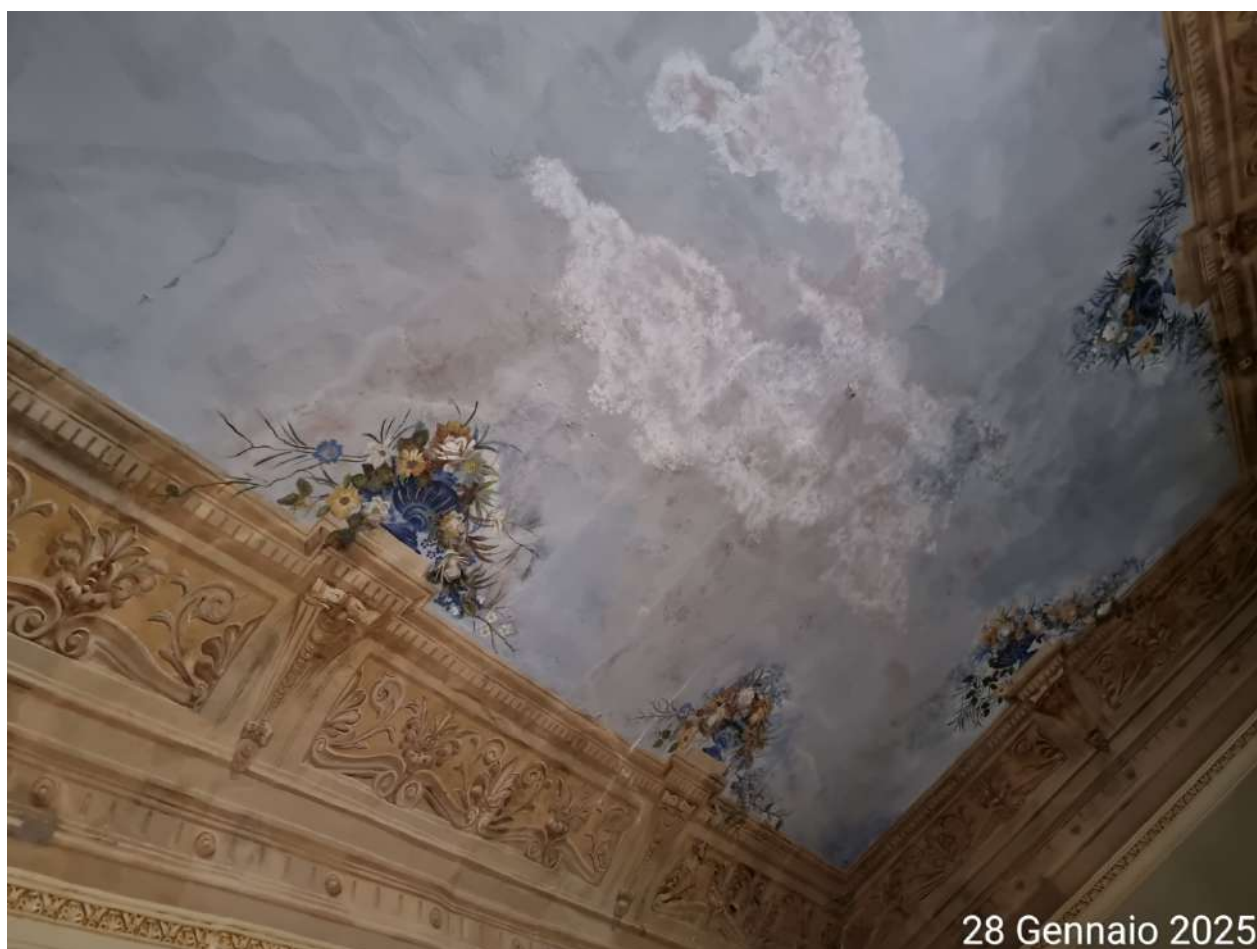
Complesso immobiliare, Piano Primo (particolare affresco soffitto)
