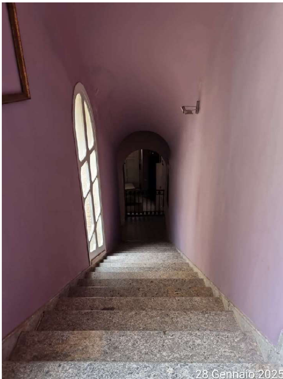
Complesso immobiliare, rampa scala al Piano Primo
