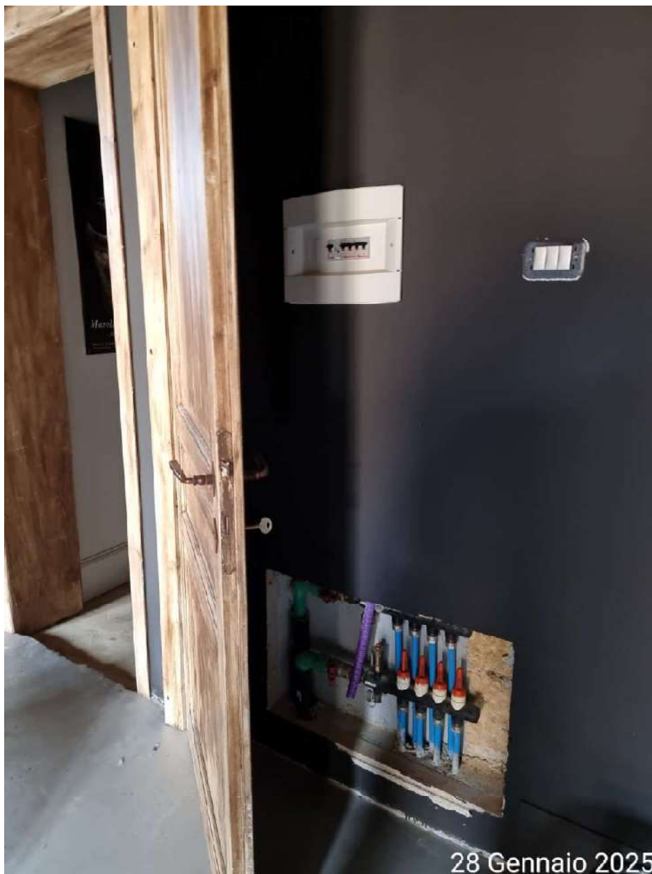
Complesso immobiliare, Piano Secondo (zona ufficio)
