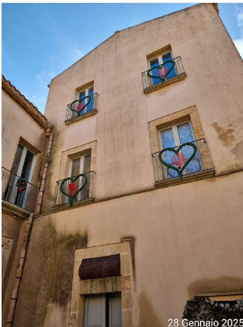
Complesso immobiliare (una delle facciate interne)
