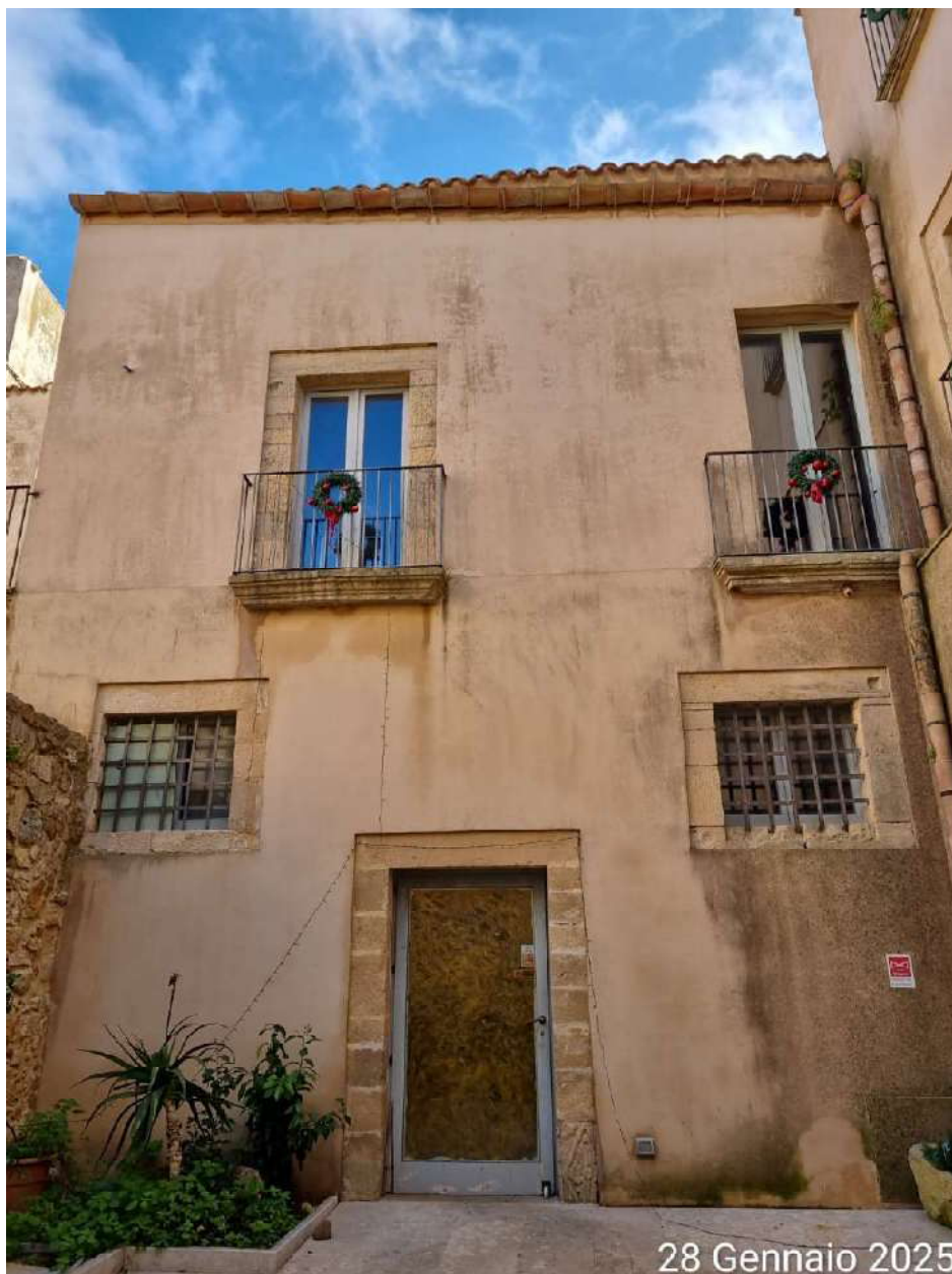
Complesso immobiliare (una delle facciate interne)
