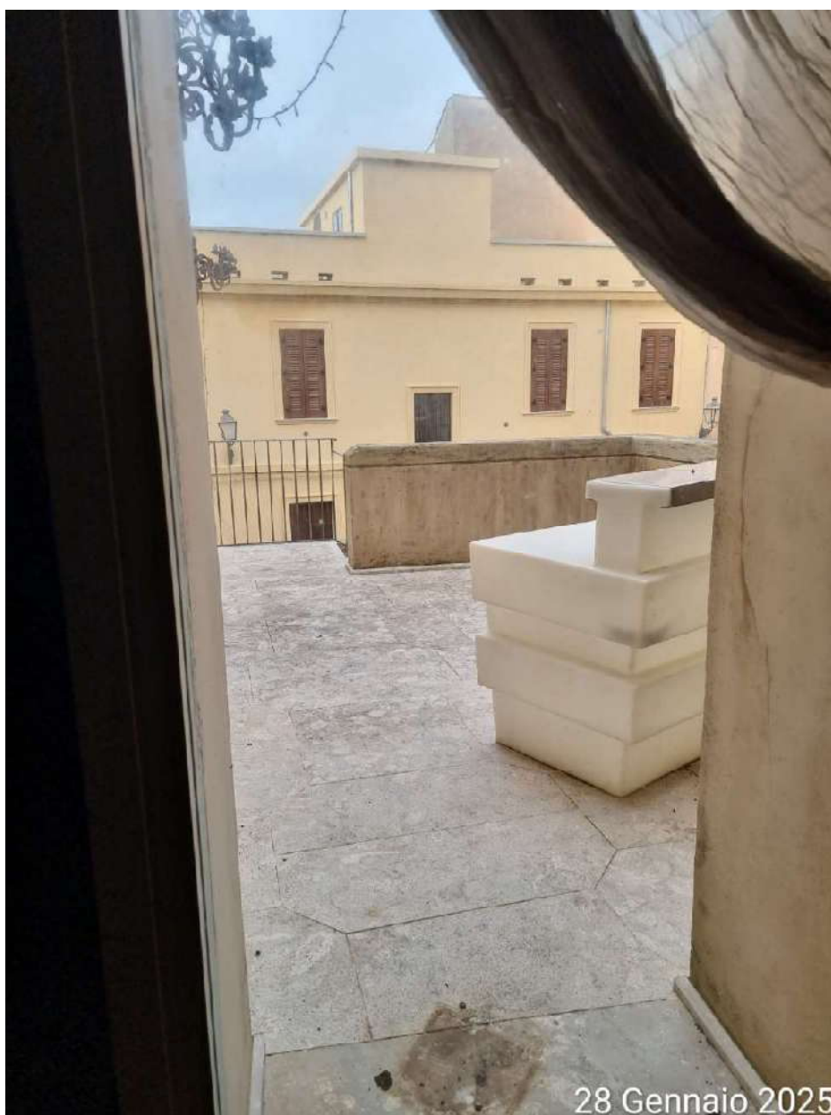
Complesso immobiliare, Piano Primo (vista ballatoio)
