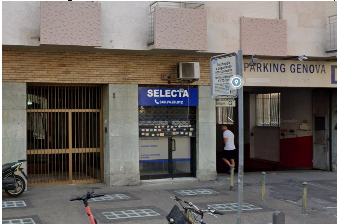
LOTTO 1 - Fotogramma 2: ulteriore vista esterna del fabbricato.
