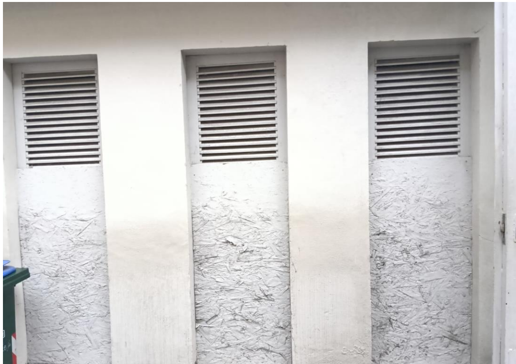
LOTTO 1 - Fotogramma 8: ulteriore vista dei ripostigli ex latrine.
