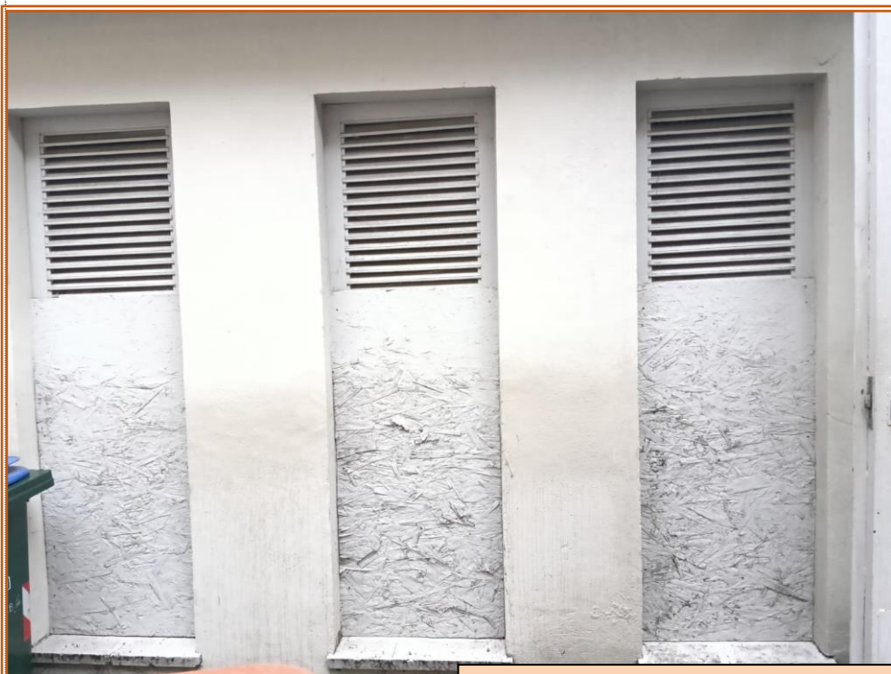
Vista dei ripostigli/ex latrine
