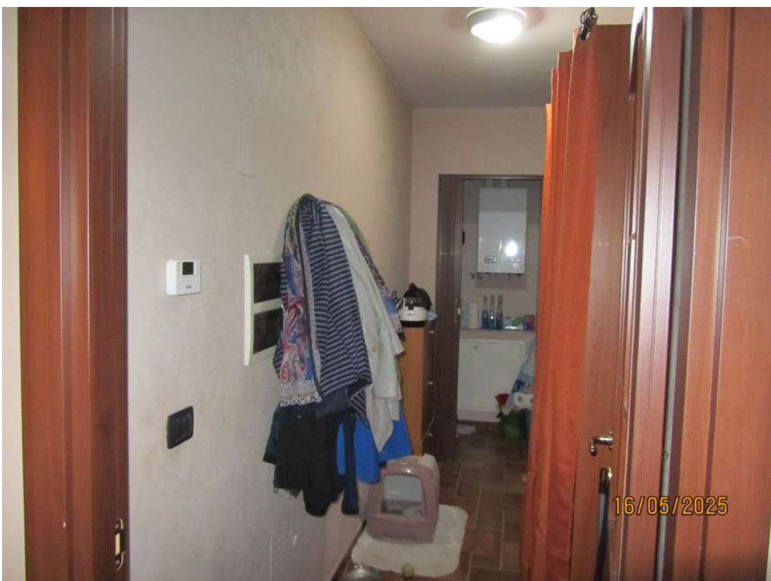
FOTO N.6 – VISTA DEL RIPOSTIGLIO. SULLO SFONDO IL VANO DI ALLOGGIO DELLA CALDAIA MURALE A GAS.
