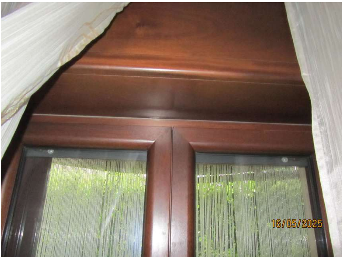
FOTO N.10 – PARTICOLARE SERRAMENTO ESTERNO CON VISTA CASSETTONE INTERNO.
