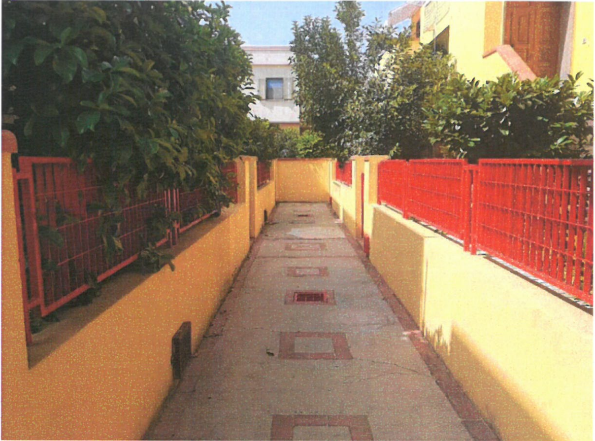
Corte condominiale di ingresso alle singole proprietà
