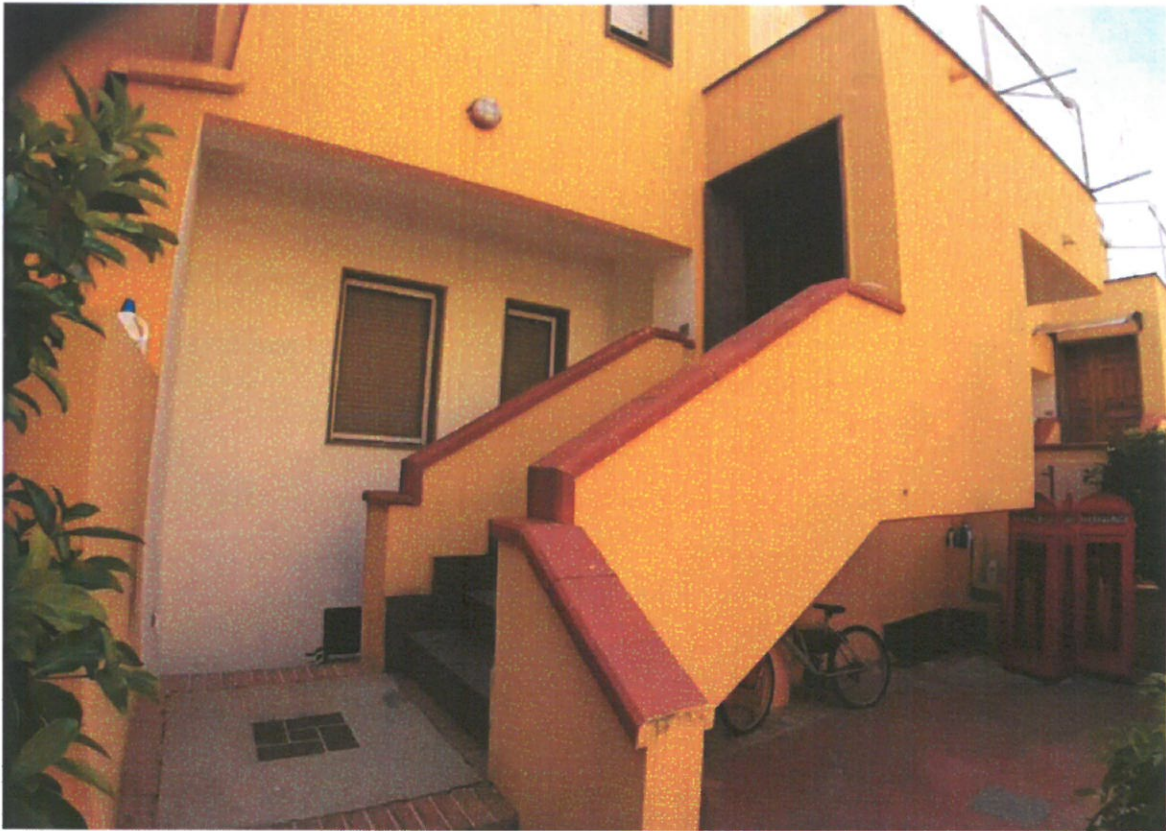
Fronte nord con scala di accesso all'appartamento visto dalla corte esclusiva antistante
