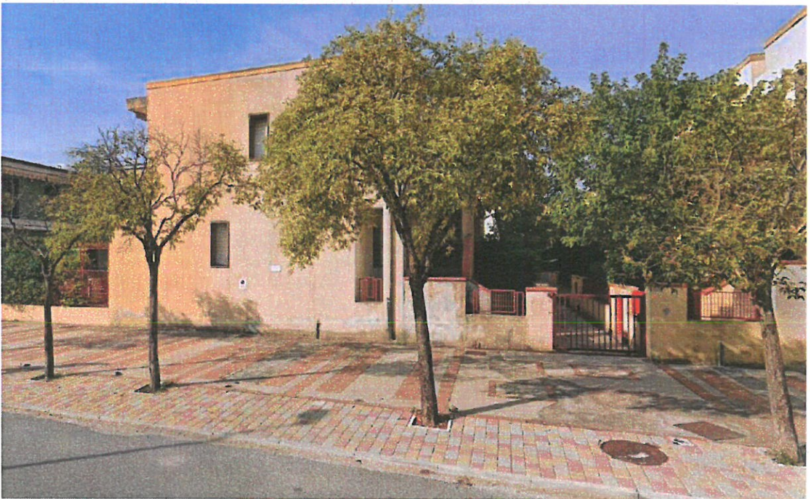
Fronte est (via V. Padula) con cancello di accesso alla corte condominiale e area di parcheggio
