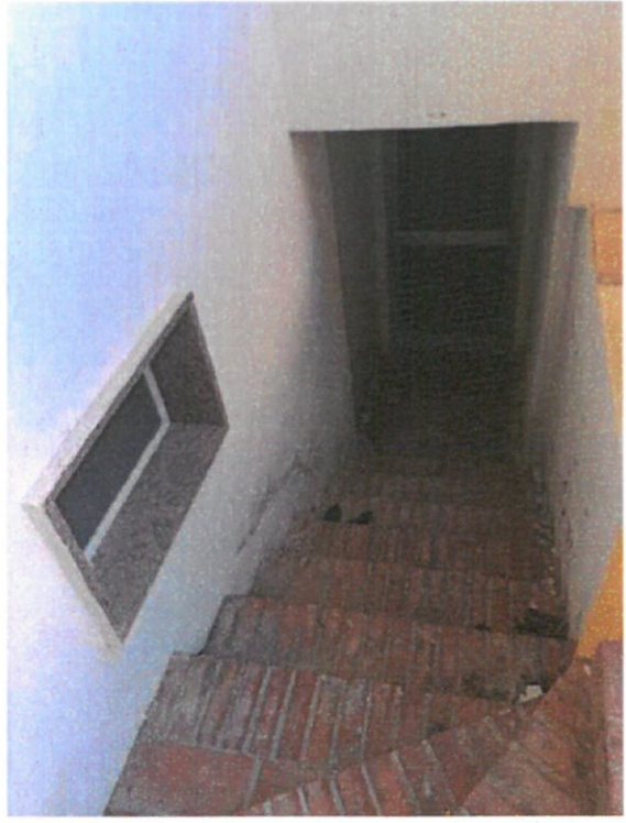
Gradini esterni di accesso cantinola seminterrata
