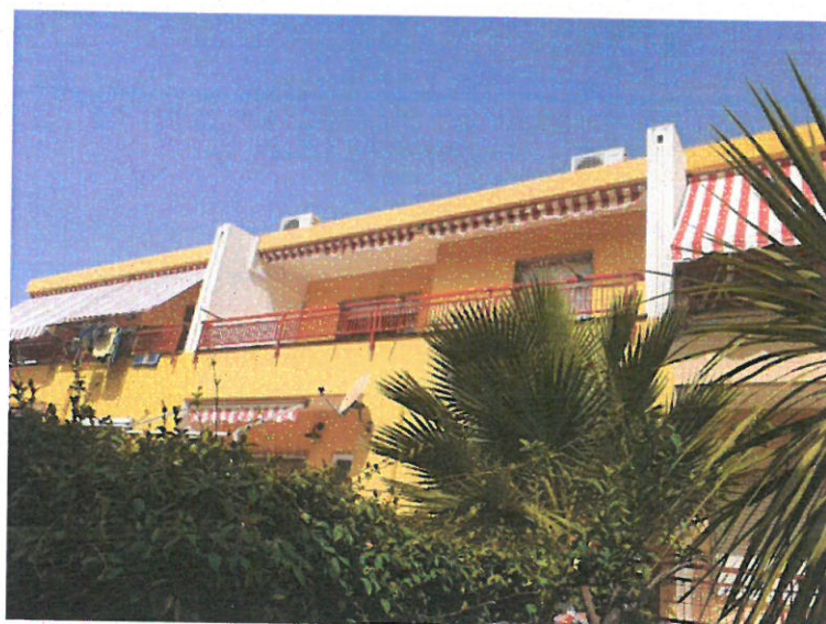
Foto 2 – Terrazzo fronte sud
