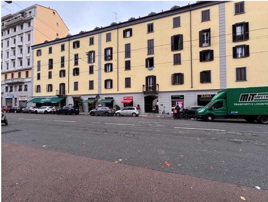
Immagine 0. Vista del fabbricato dalla strada.
