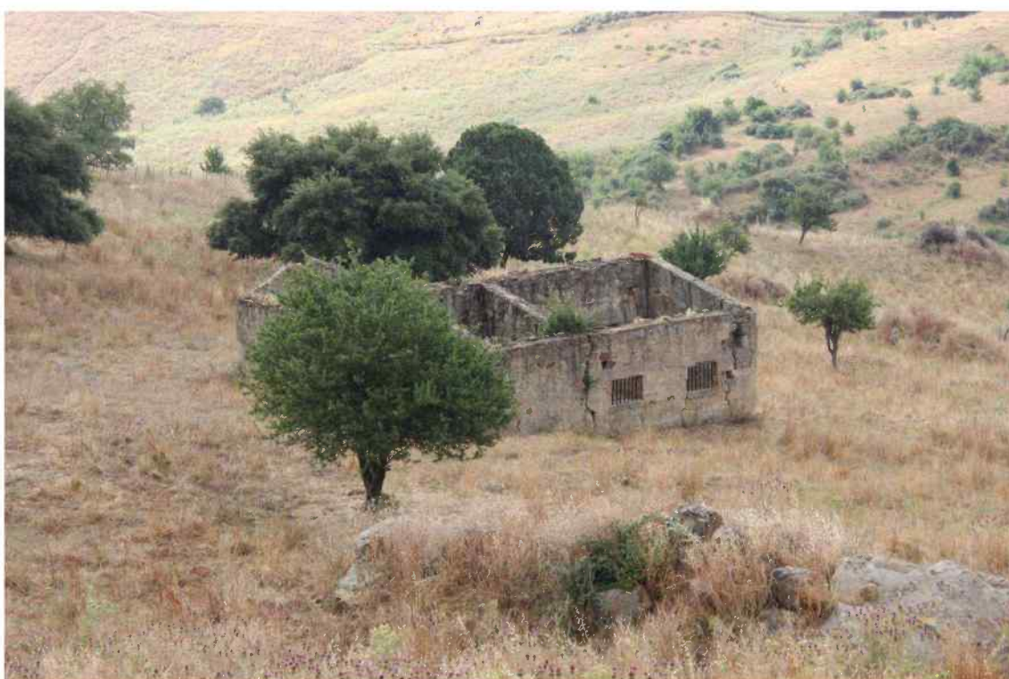
Foto 4 – Particella 387 – Fabbricato Rurale
