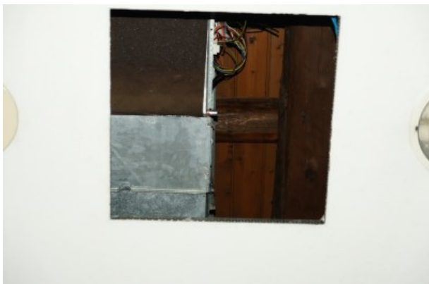
foto n.66 – particolare del controsoffitto e del soffitto del piano terra
