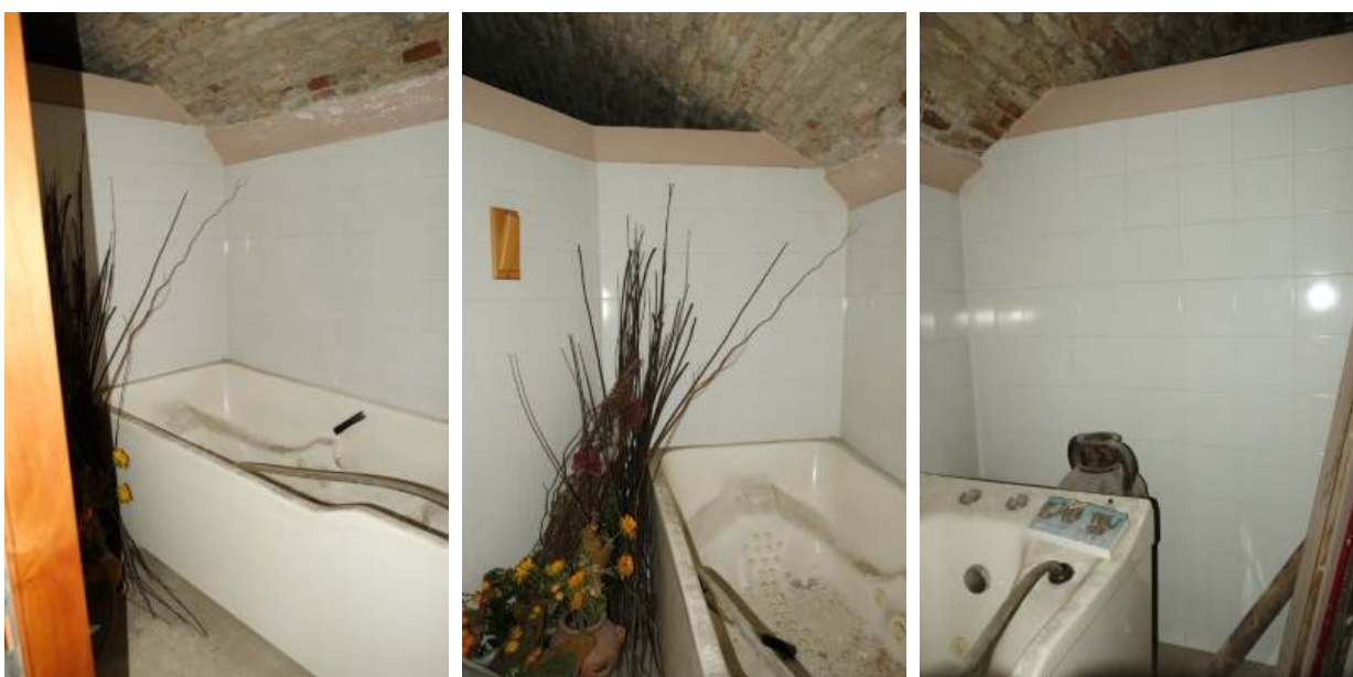
foto n.36-37-38 – vedute del vano con vasca idromassaggio
