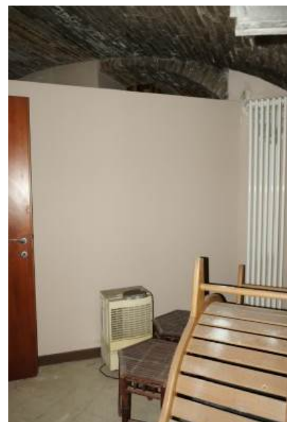
foto n.92 – veduta della tipologia dei corpi scaldanti installati al piano primo sottostrada. In alcuni ambienti sono stati riscontrati anche dei deumidificatori
