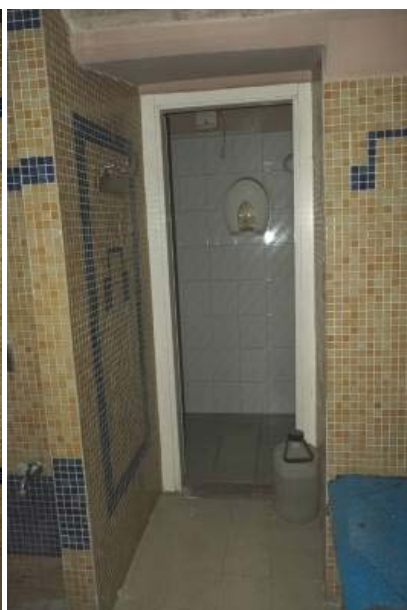
foto n.62-63 – vedute del corridoio zona docce e dell'accesso al bagno adiacente alle docce
