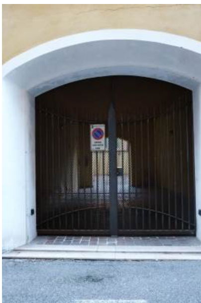
foto n.6 – veduta dell'accesso carrabile alle parti comuni del fabbricato ove è ubicata l'u.i. oggetto di procedura, da via Boccaquattro
