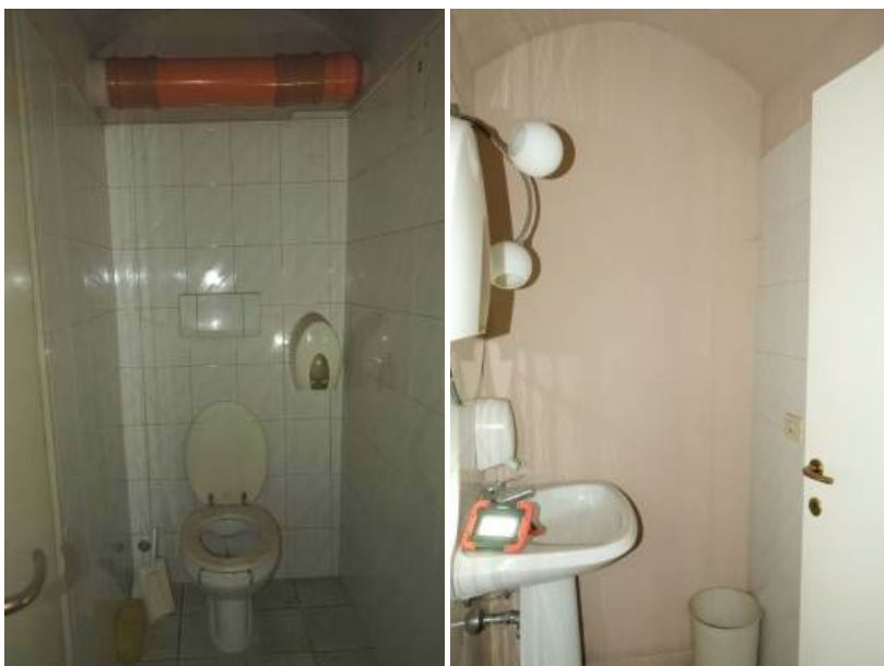
foto n.64-65 – vedute del bagno adiacente alla zona docce
