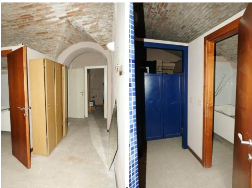
foto n.32-33-34-35 – vedute del percorso di accesso agli “ambienti benessere” realizzati, senza titolo, al piano primo sottostrada
