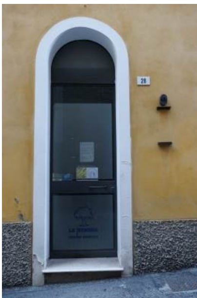
foto n.5 – particolare della porta di accesso all'u.i. oggetto di procedura, da via Boccaquattro
