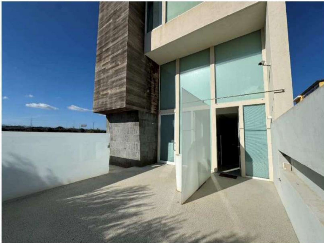
Prospetto sud – particolare infisso piani terra e primo
