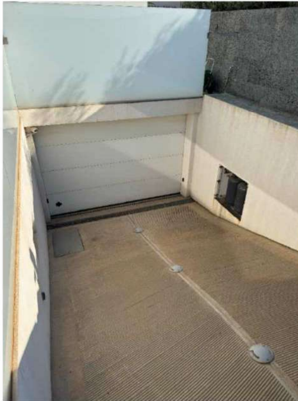
Rampa di accesso al piano interrato
