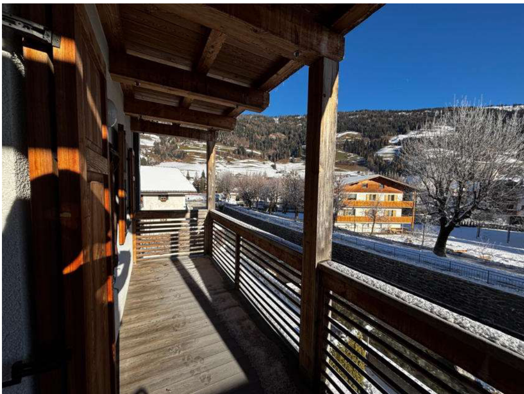
Balcone in direzione Nord P.ED. 772 P.M. 5
