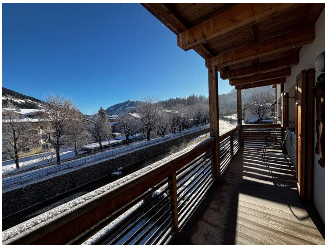
Balcone in direzione Nordovest P.ED. 772 P.M. 5
