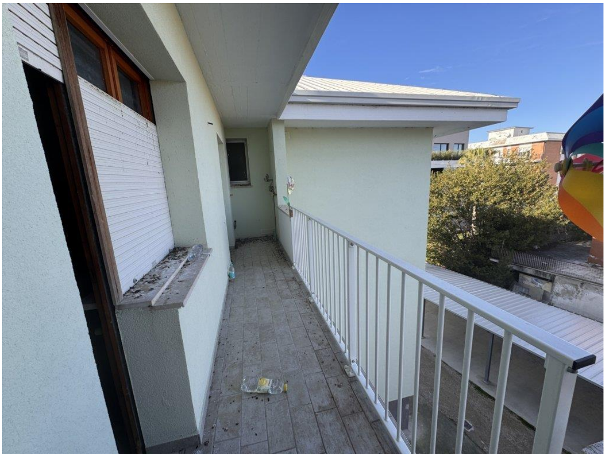
21. Vista del balcone sul lato nord dell'appartamento
