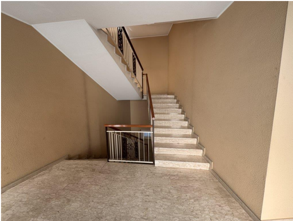
9. Vista del vano scala condominiale
