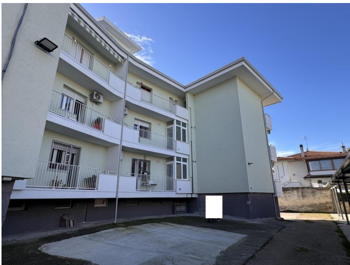
4. Vista lato nord del fabbricato
