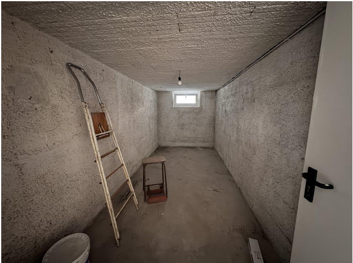
24. Vista interna del fondaco al piano terra
