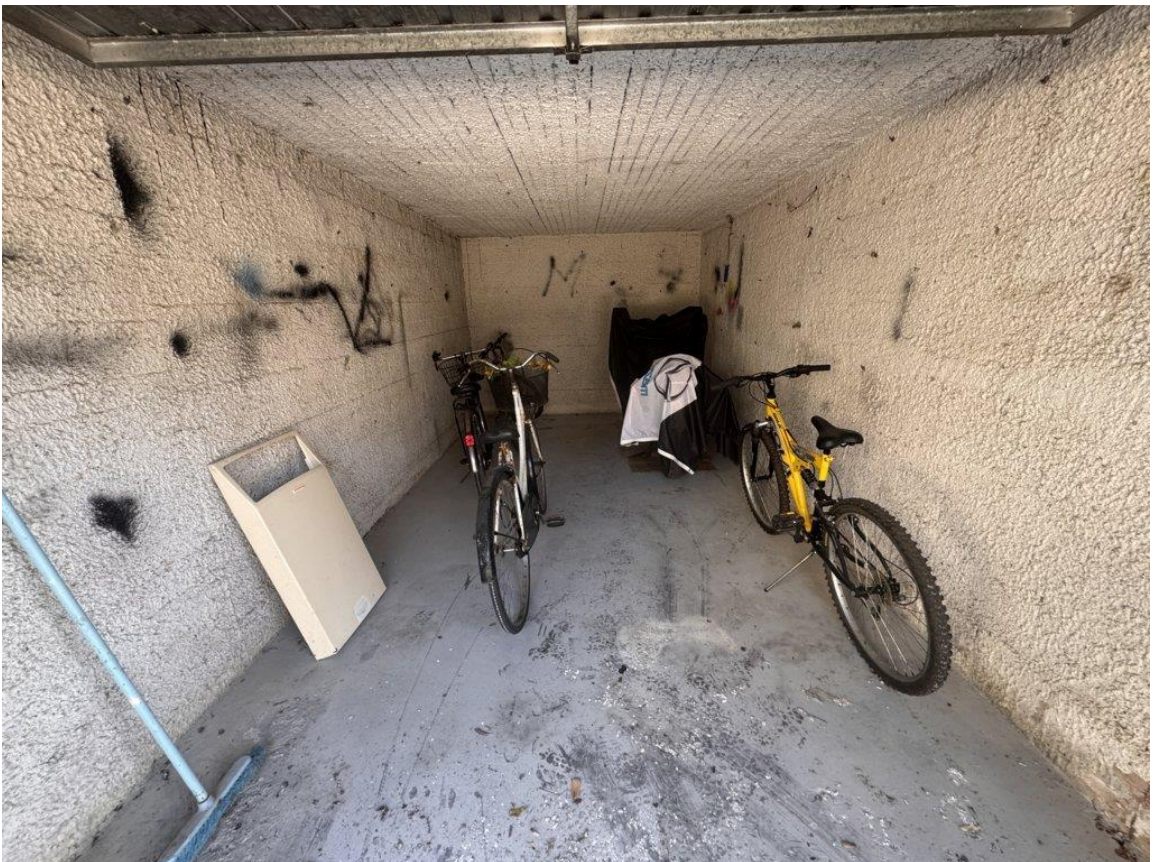
26. Vista interna del garage
