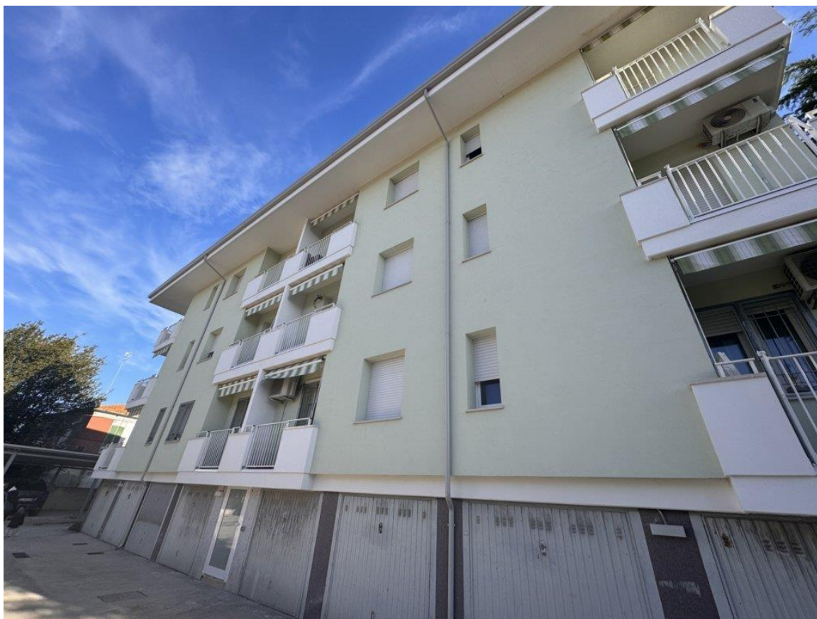
5. Vista lato ovest del fabbricato
