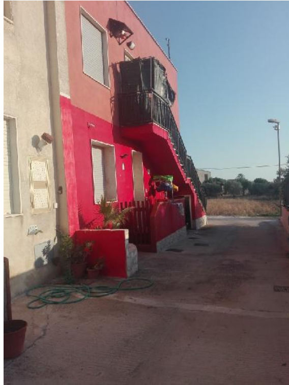
Vista n. 1 ACCESSO IMMOBILE
