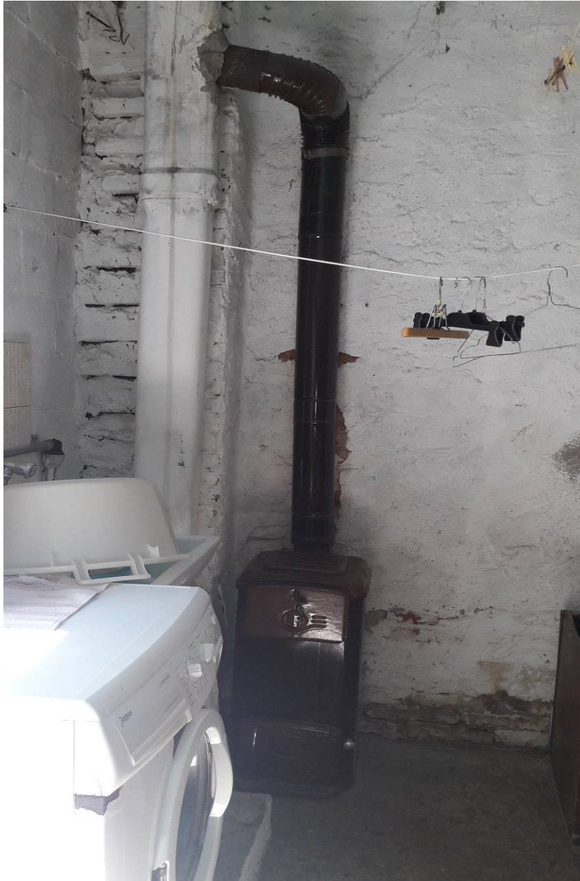
Interno locale accessorio
