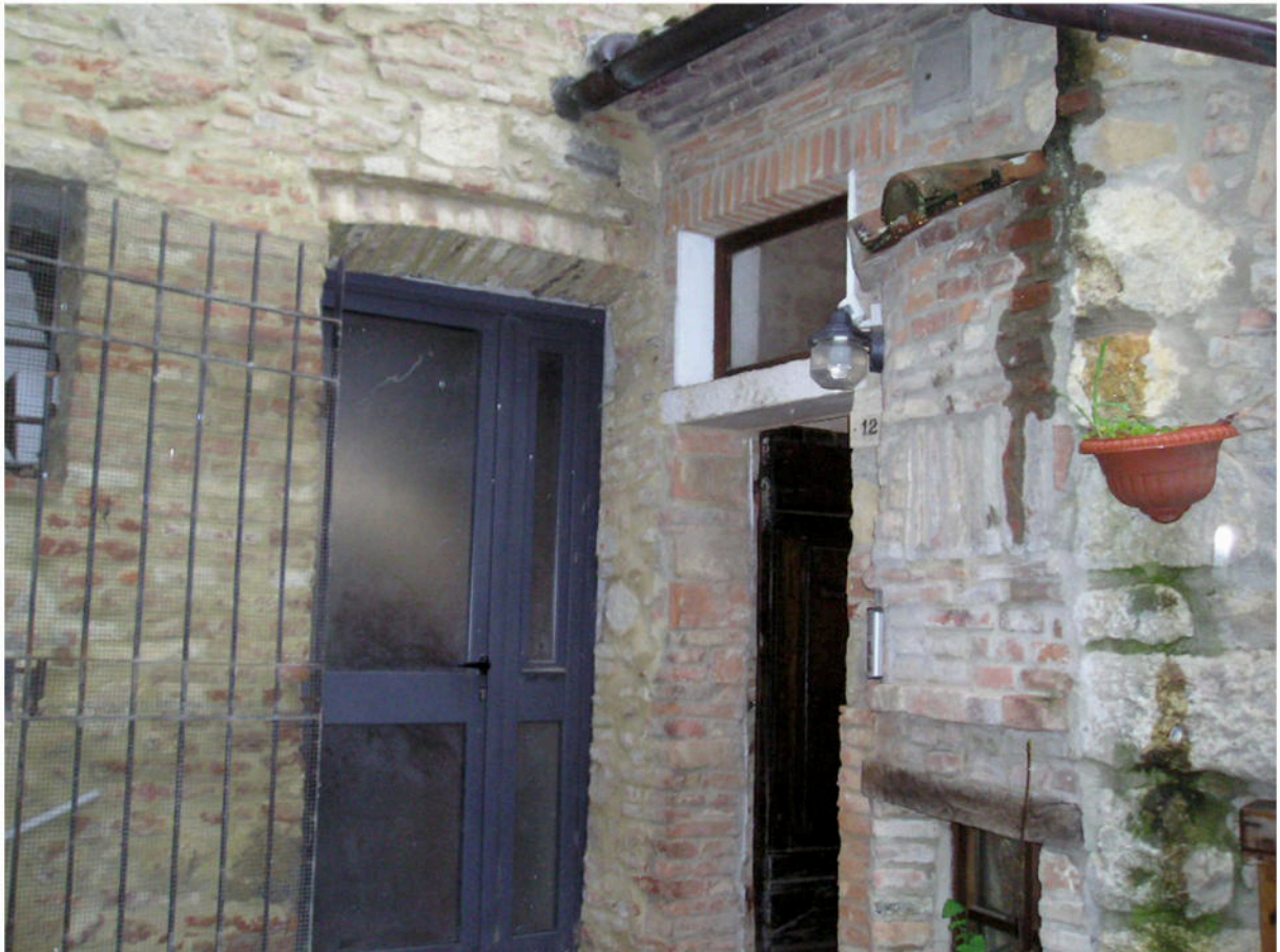
Fotografia 04 - Esterni Fabbricato / Ingresso Civico 12
