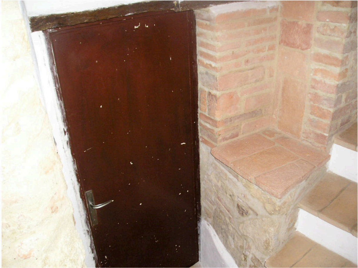
Fotografia 11 - Utilità Comuni / Ingresso Sub.39
