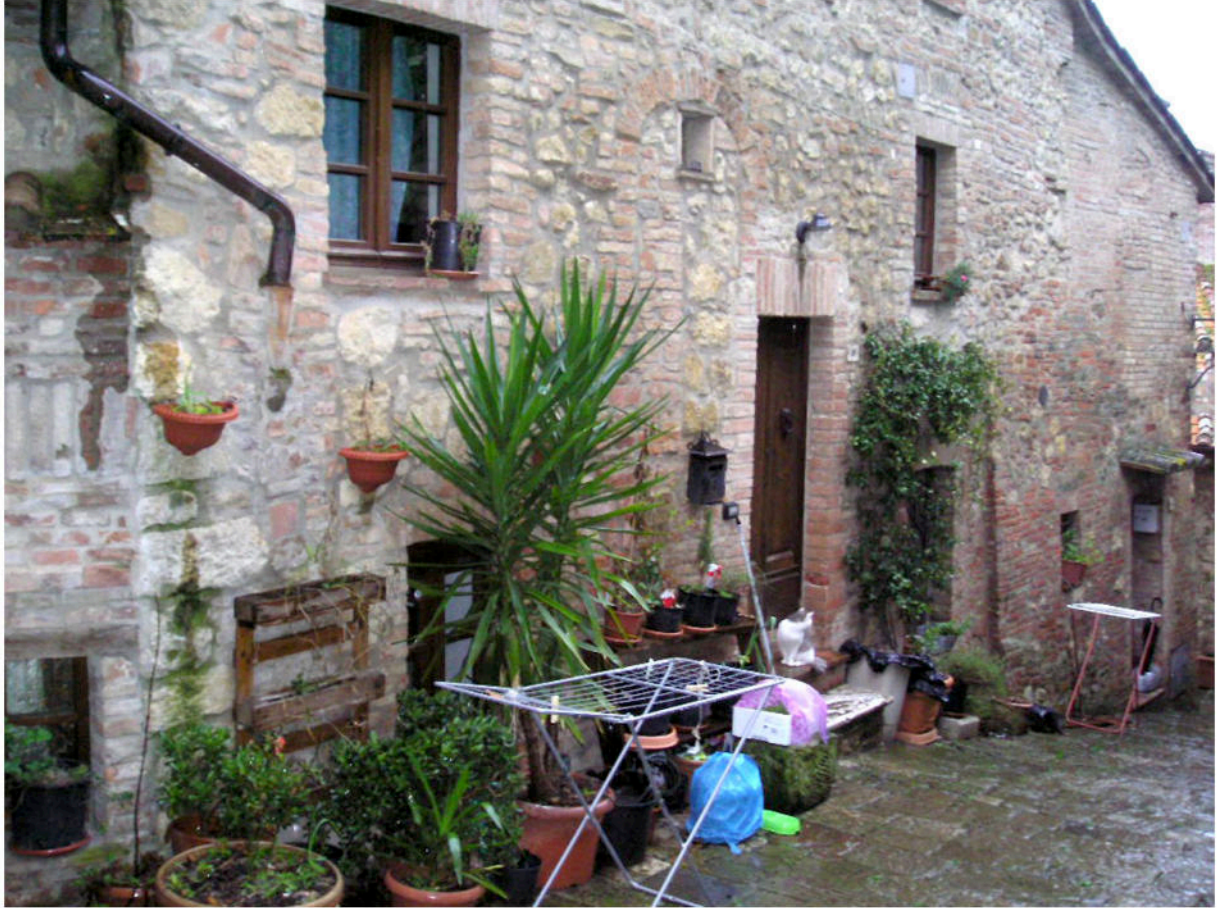
Fotografia 03 - Esterni Fabbricato / Ingresso Civico 10
