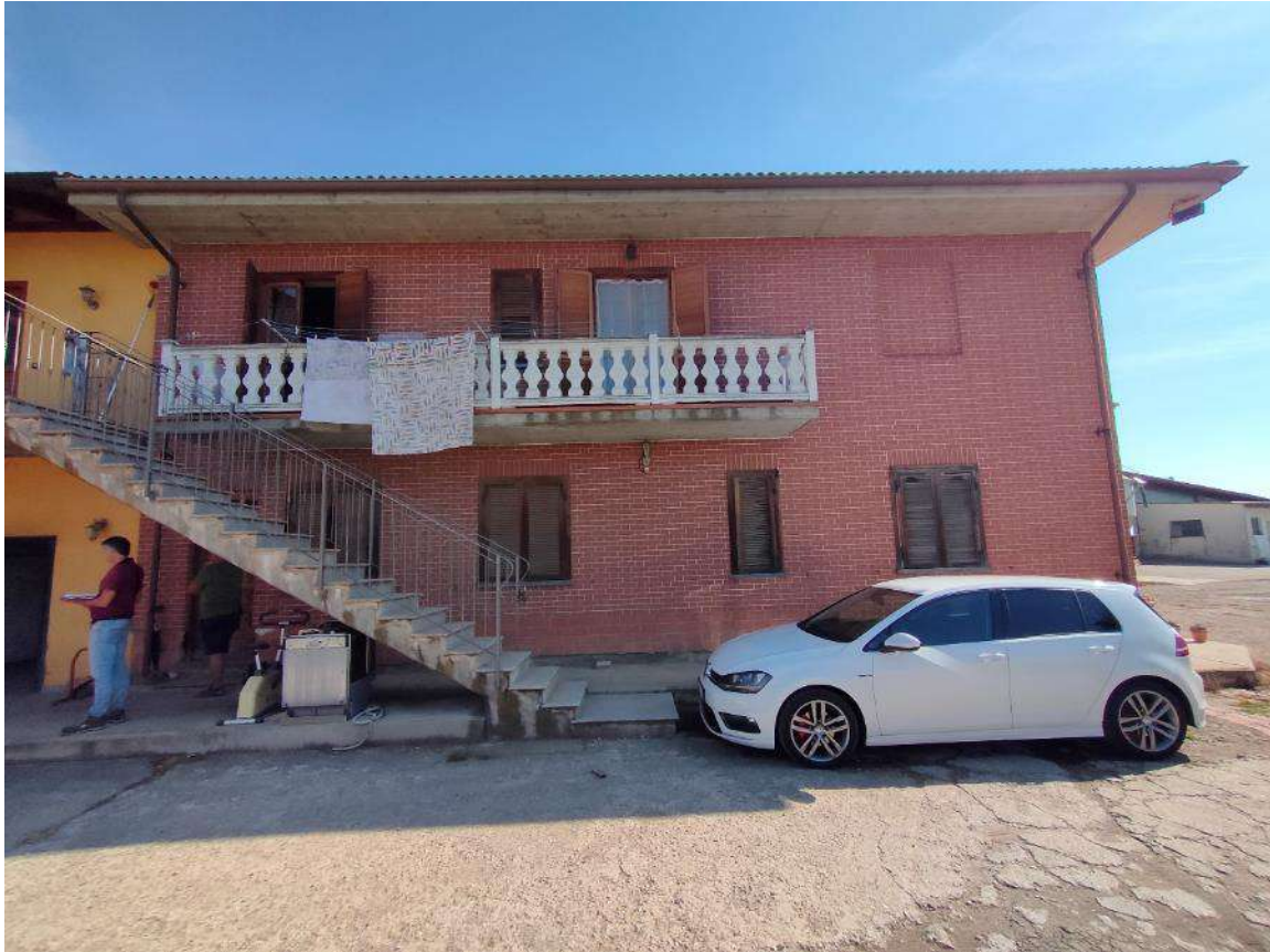
Fotografia 25 Veduta ESTERNA BENE 6
