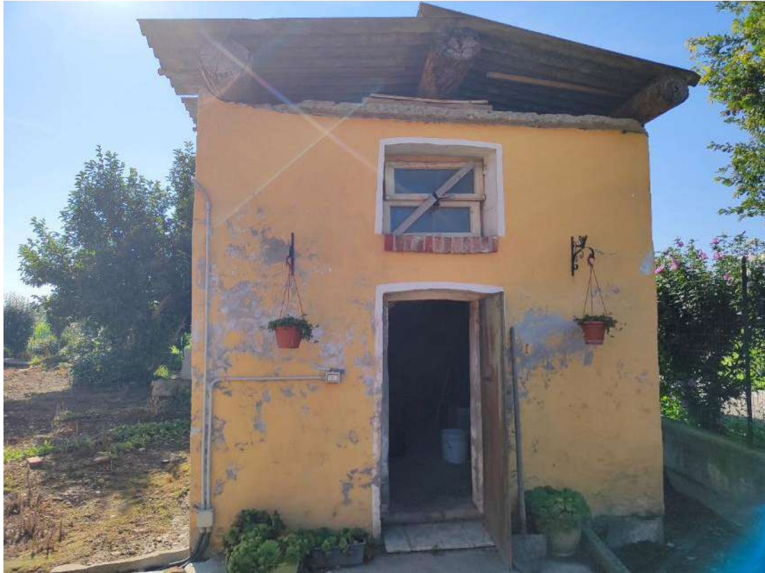
Fotografia 21 Veduta ESTERNA BENE 5
