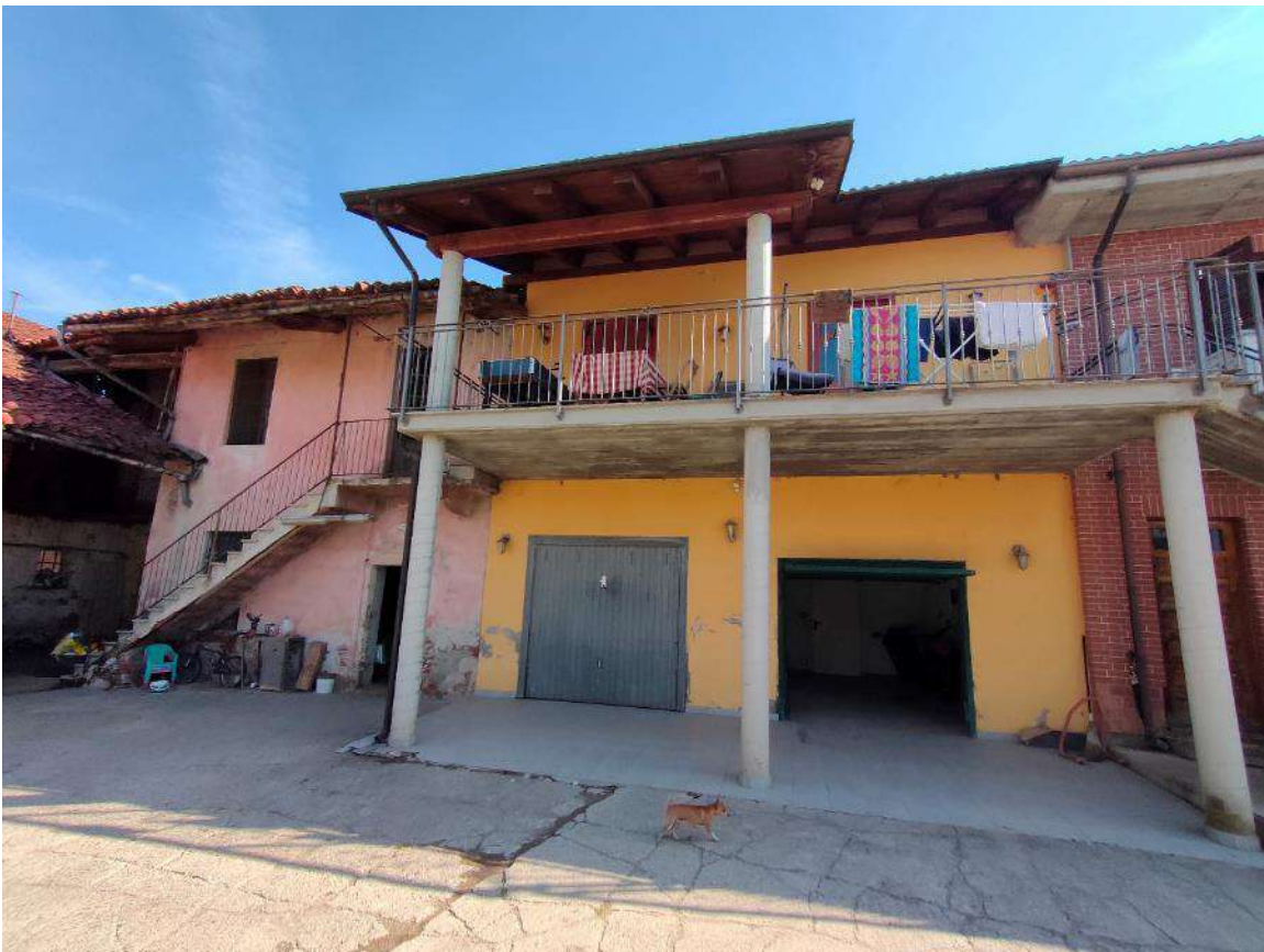
Fotografia 26 Veduta ESTERNA BENE 6
