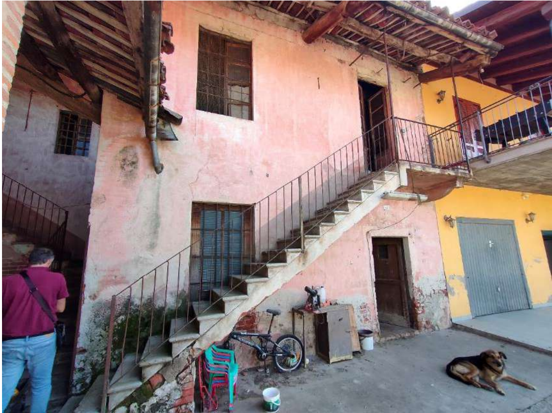
Fotografia 9 Veduta ESTERNA BENE 4
