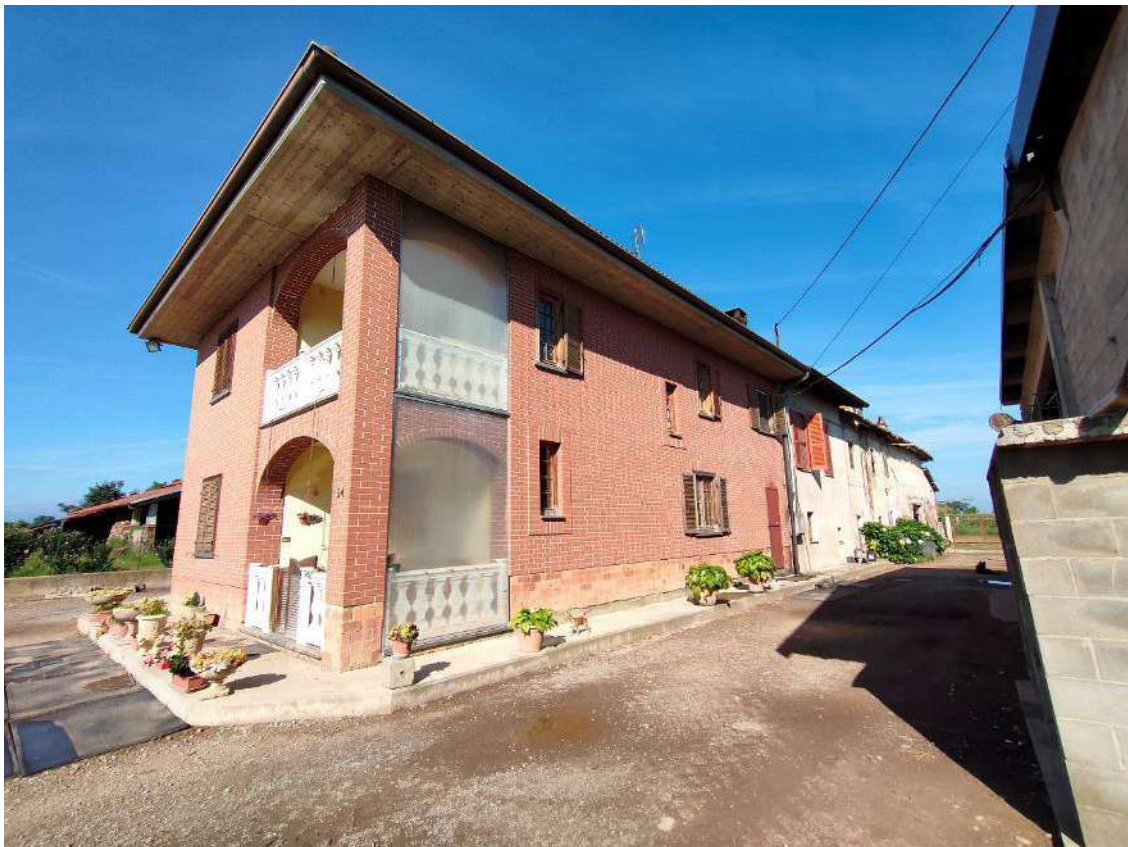
Fotografia 22 Veduta ESTERNA BENE 6
