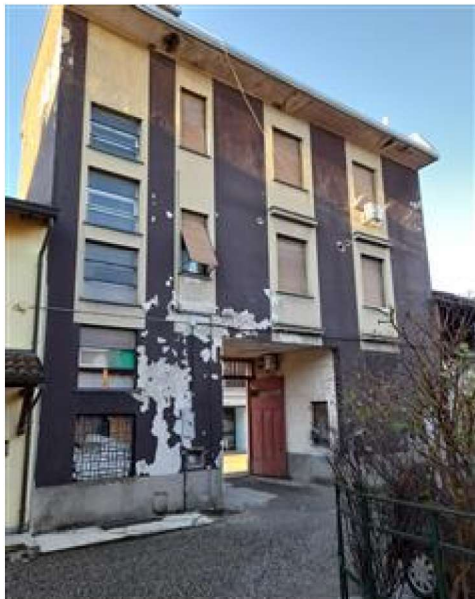
Prospetto da cortile interno
