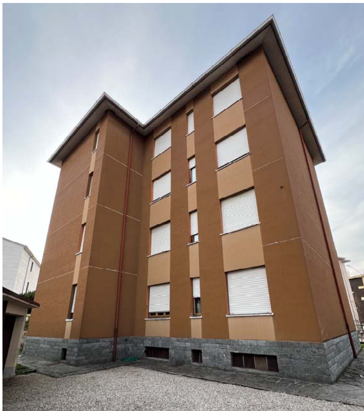
Fronte ovest- retro
