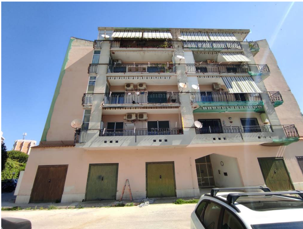
Foto 2 – Prospetto Sud edificio condominiale
