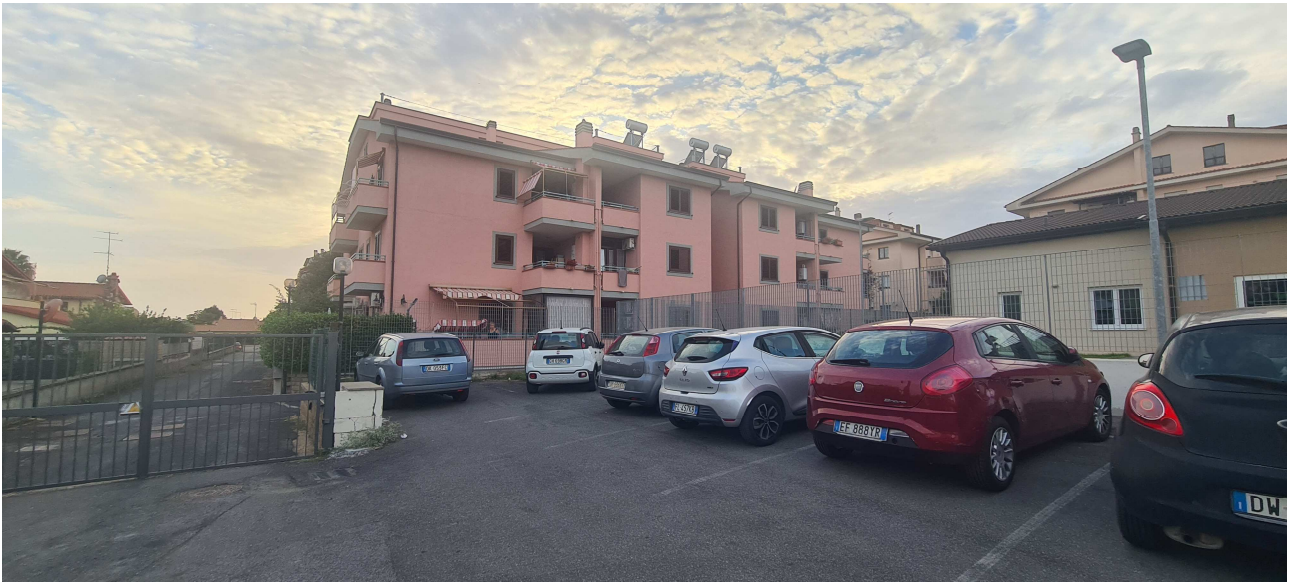
Vista dell'edificio di via Madonna dei Canneti n. 52/D Edificio F1 – scatto del 09/09/2025
