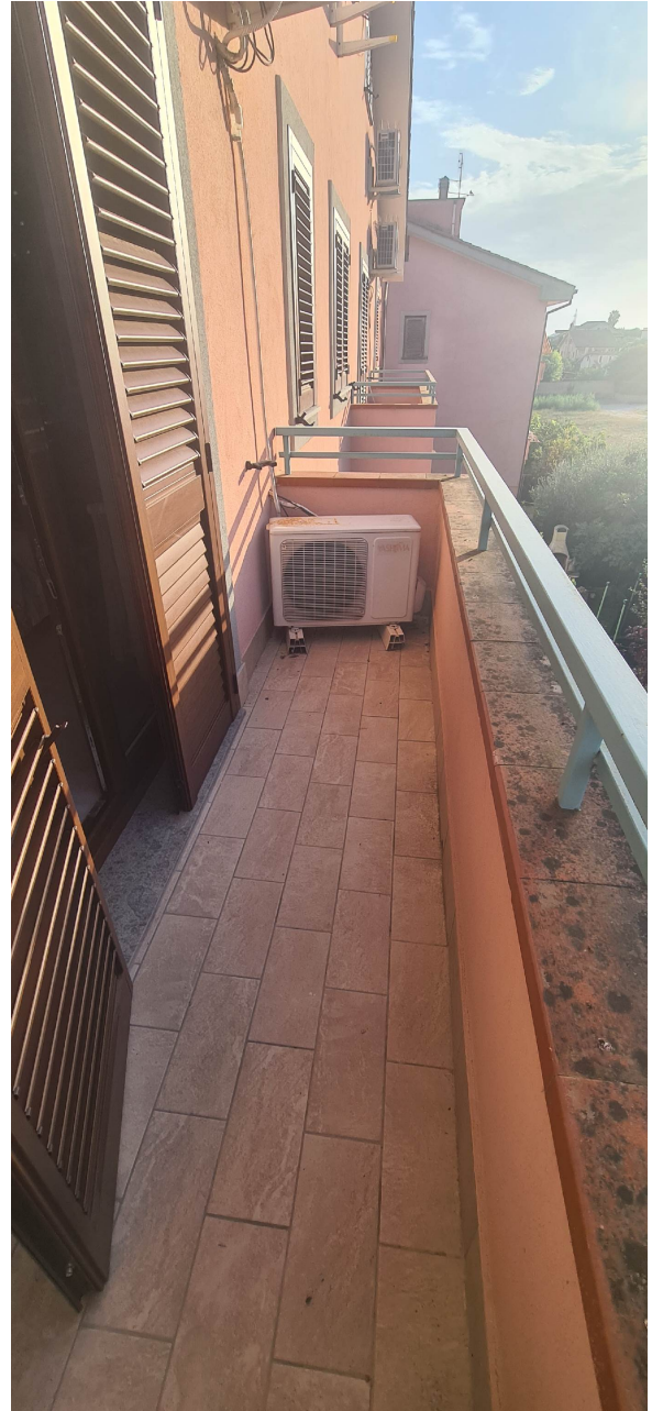
Foto 6 - scatto del 09/09/2025 (Appartamento Piano Secondo interno 14)
