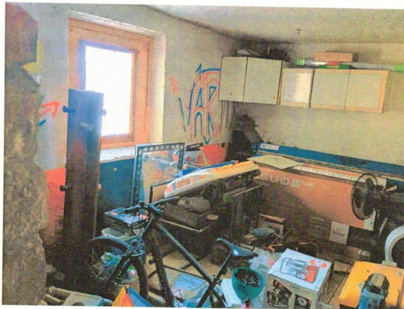
Foto n. 10: veduta cantina P.T.
