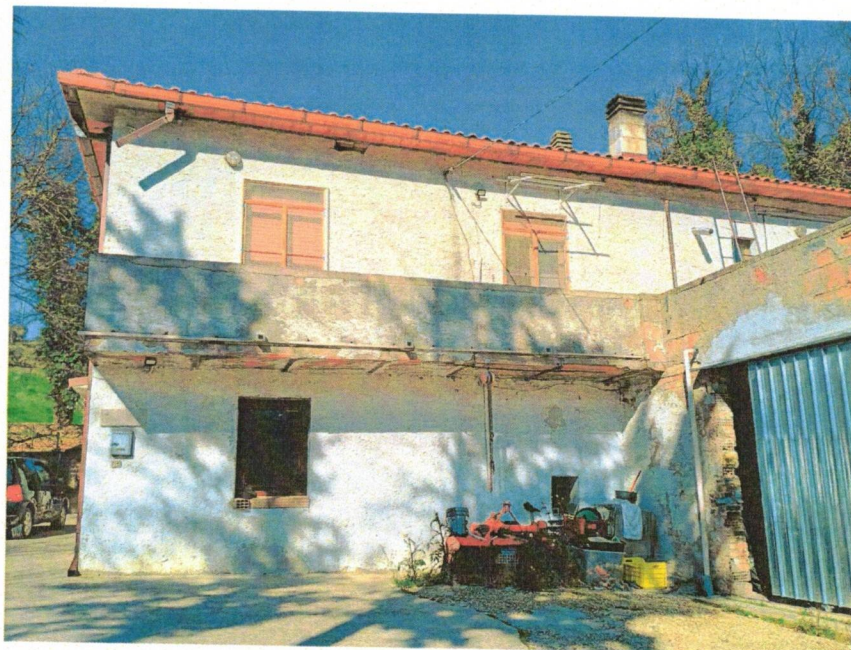
Foto n. 2: prospetto laterale fabbricato
