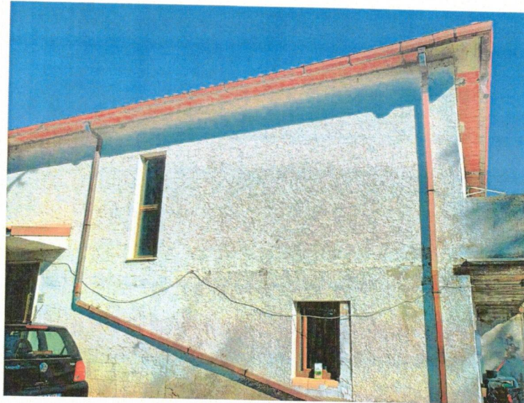
Foto n. 1: prospetto principale fabbricato
