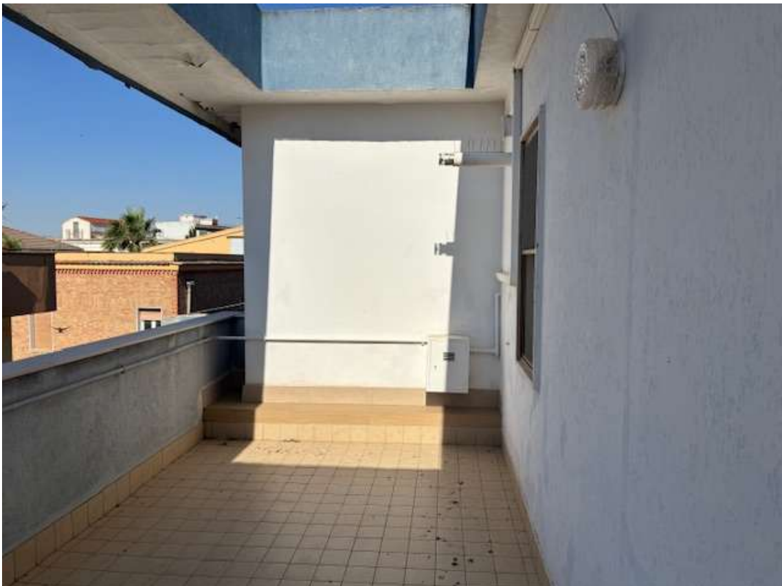
Foto n. 10 – Balcone su via Irpinia
