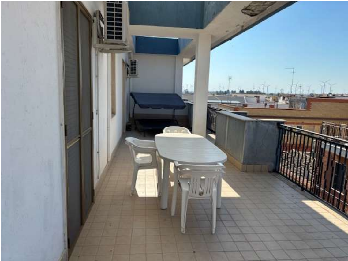
Foto n. 11 - Balcone su via Irpinia
