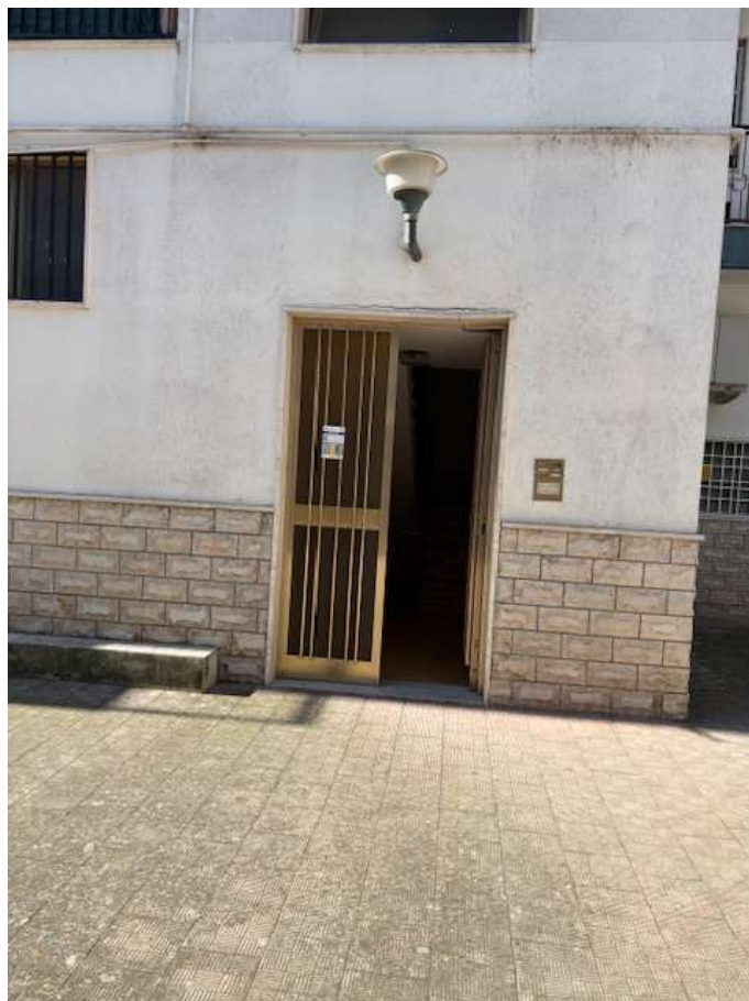
Foto n. 1 – Accesso da cortile interno alla scala condominiale
