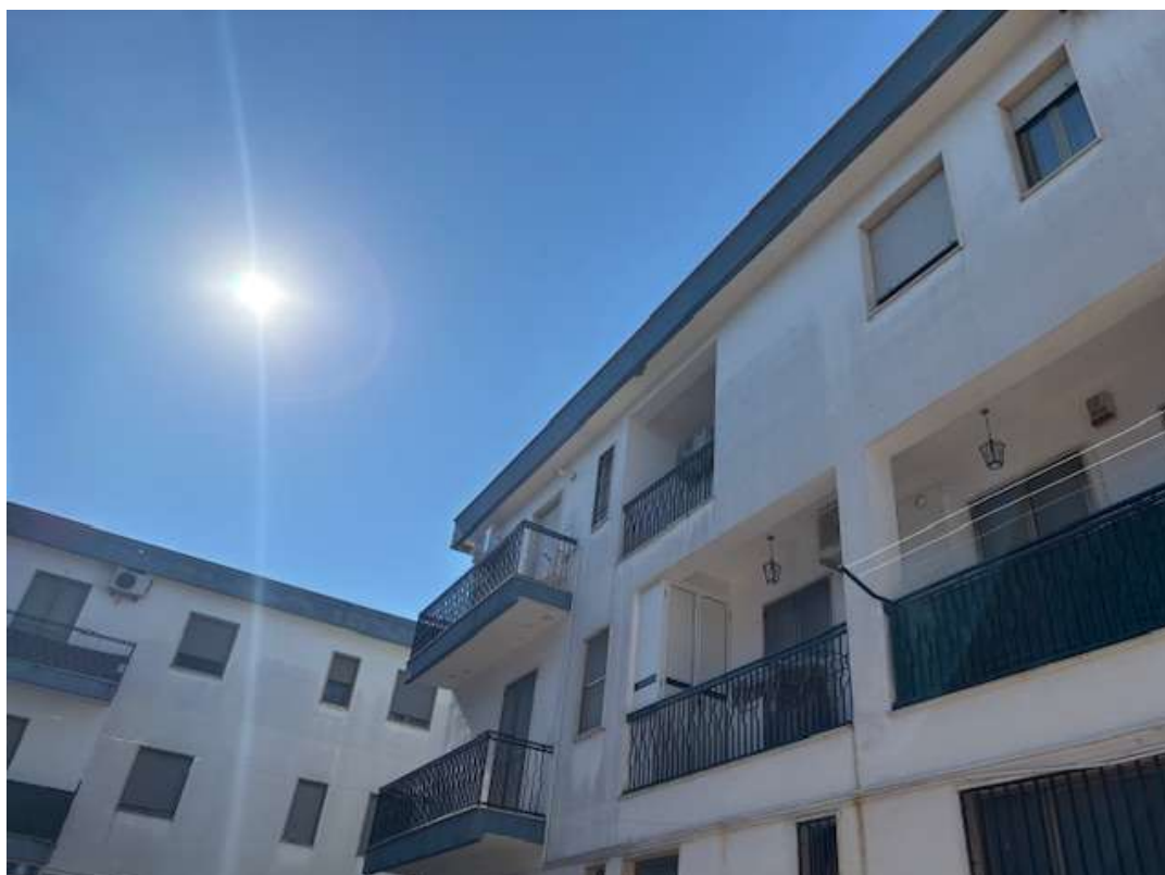
Foto n. 2 – Prospetto del fabbricato dal cortile interno
