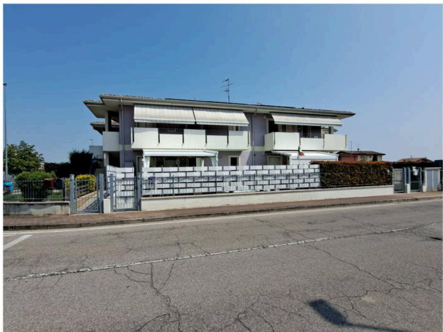
01 vista esterna del fabbricato fronte nord
