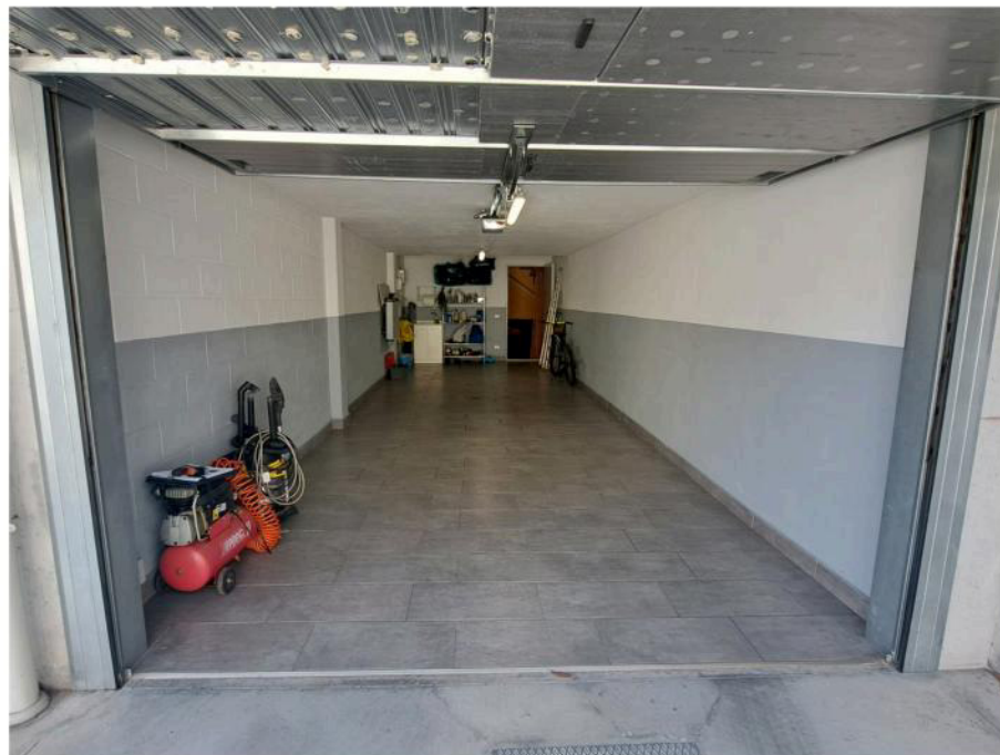
16 vista interna dell'autorimessa PS
