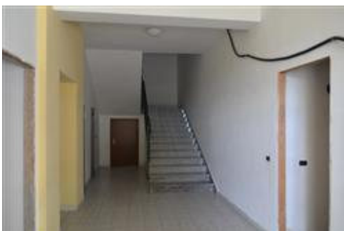
Ingresso principale interno
