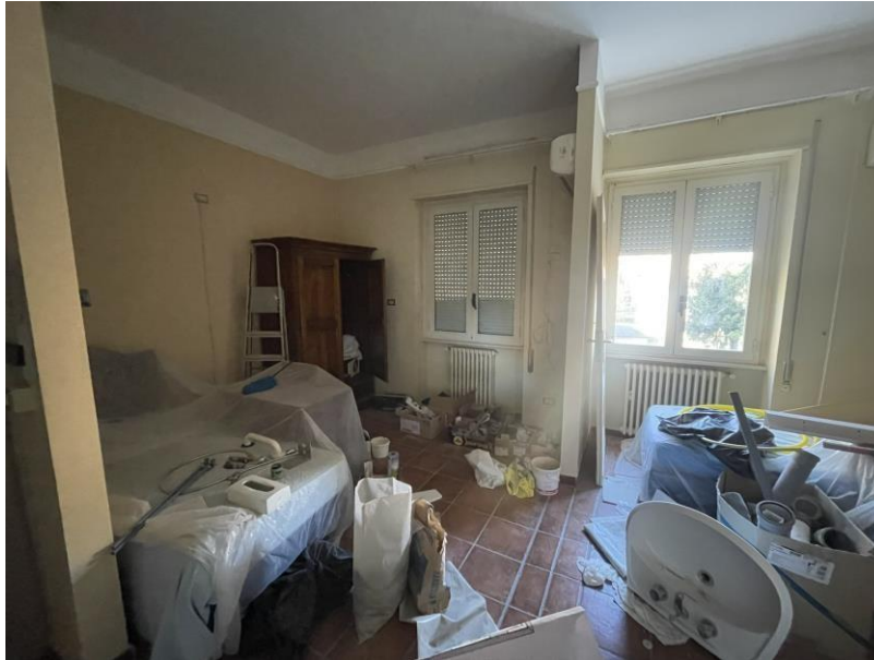
Fotografia n.22 – Piano Secondo – Camera n.202 – L'alloggio allo stato attuale interessato da lavori di manutenzione.
