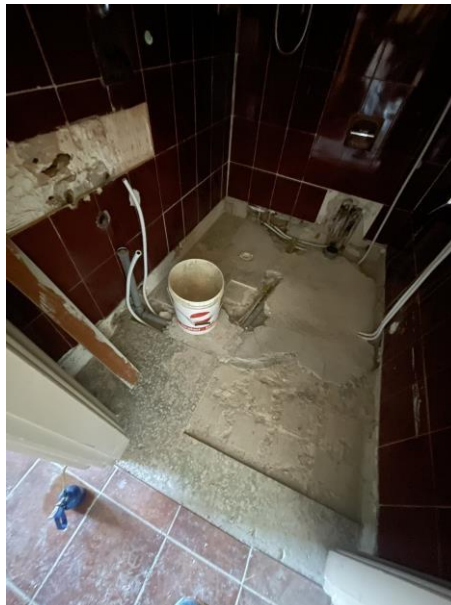
Fotografia n.23 – Piano Secondo – Camera n.202 – L'ambiente Bagno allo stato attuale interessato da lavori di manutenzione.
