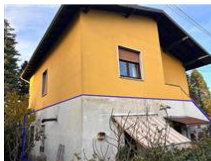
APPARTAMENTO IN ESECUZIONE IMMOBILIARE_ VISTA SUD-OVEST
