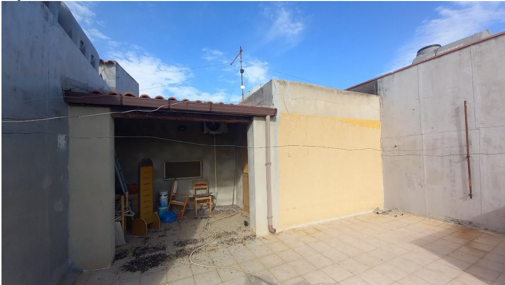
5 - Vista del piano terrazza e della tettoia in legno
