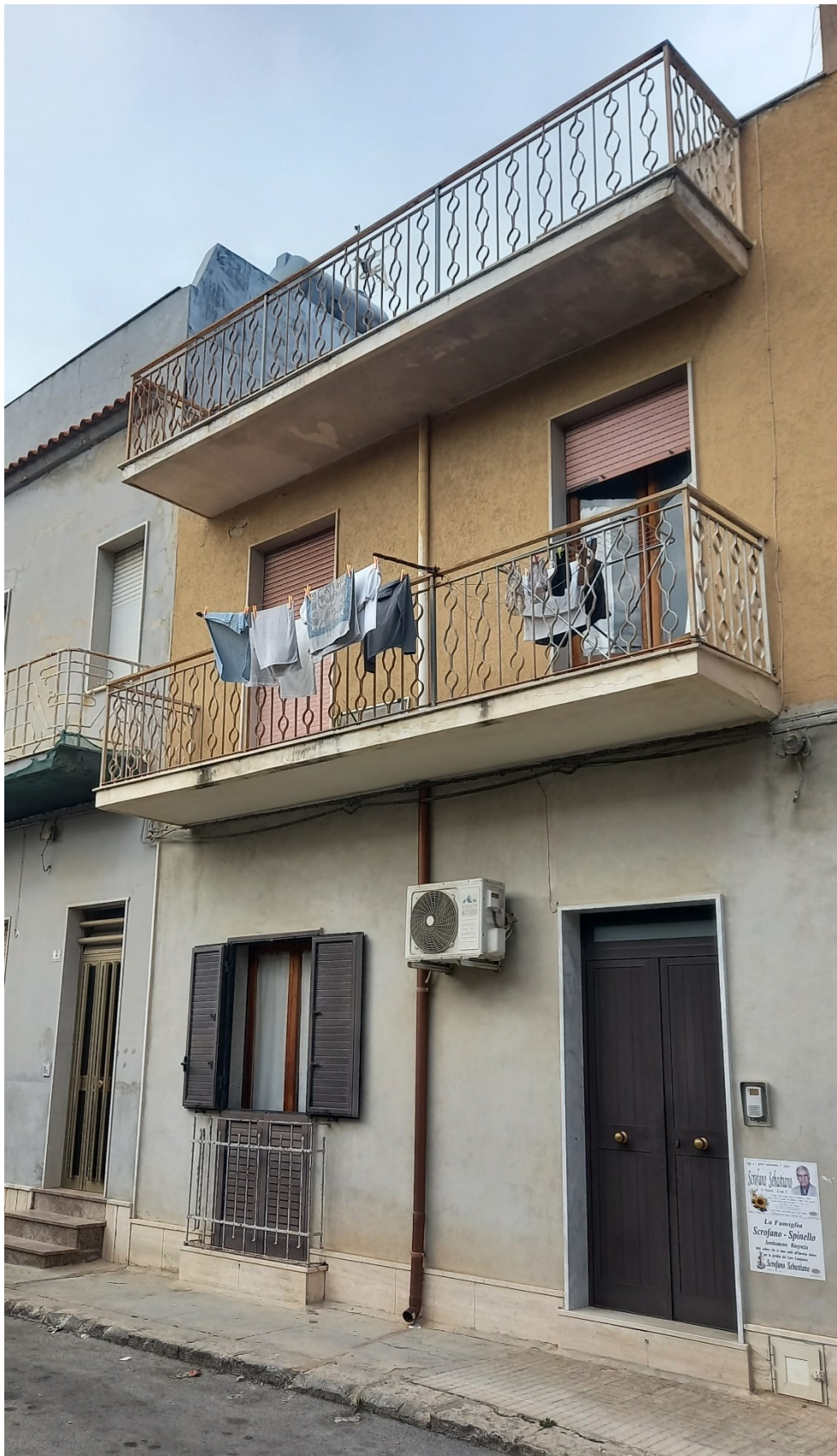
1 - Vista del fronte principale su via M. Coffa
