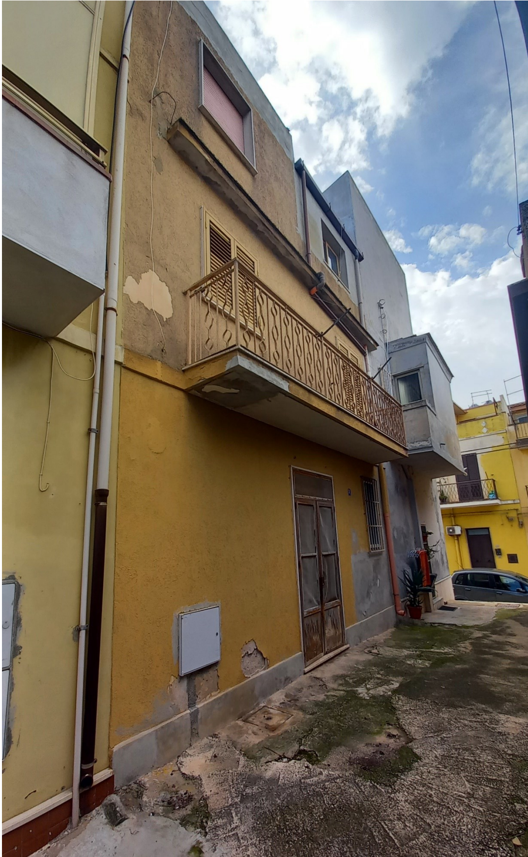
3 - Vista del fronte secondario su via U. Bassi
