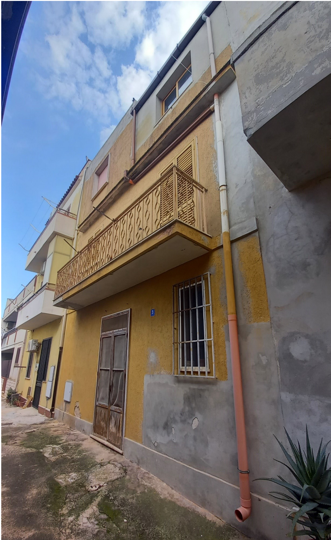
2 - Vista del fronte secondario su via U. Bassi
