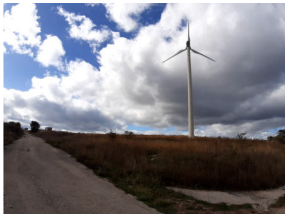
Vista esterna prospetti
