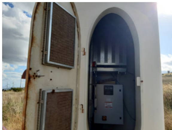
Vista esterna prospetti
