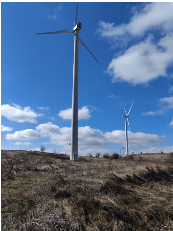
Foto n. 6 – Vista pala eolica
