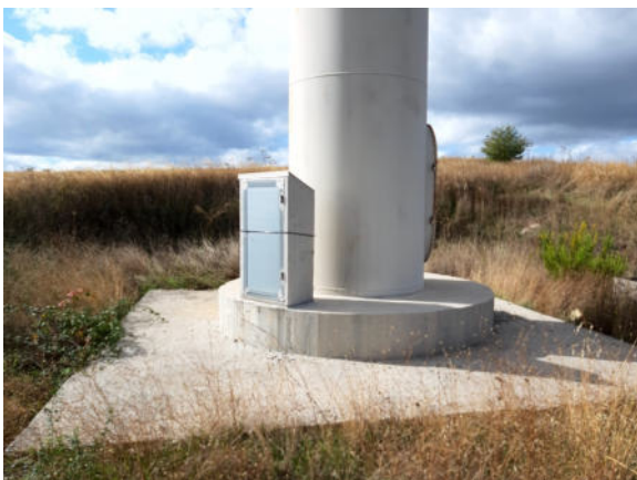
Vista esterna prospetti
