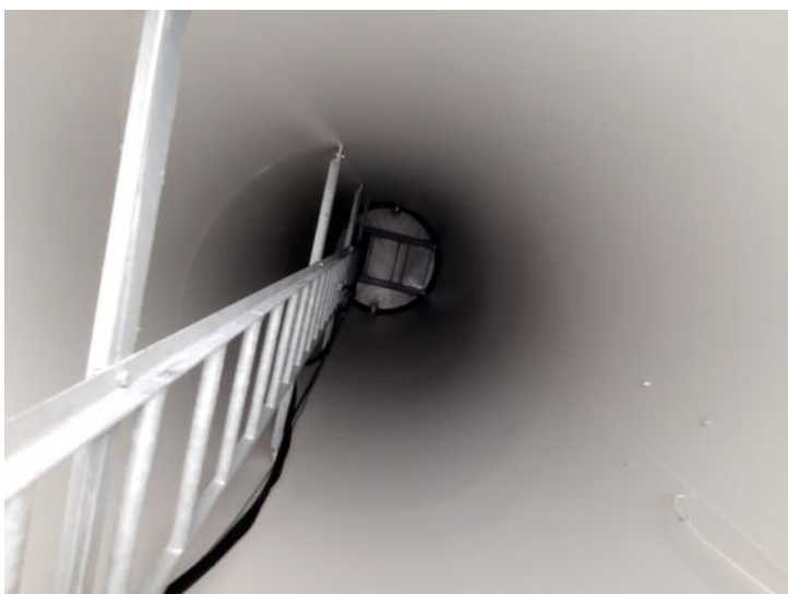
Foto n. 16 – Vista pala eolica – interno colonna
