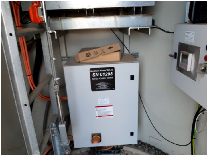
Foto n. 19 – Vista pala eolica – componenti interni
