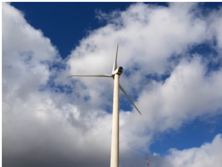
Foto n. 8 – Vista pala eolica
