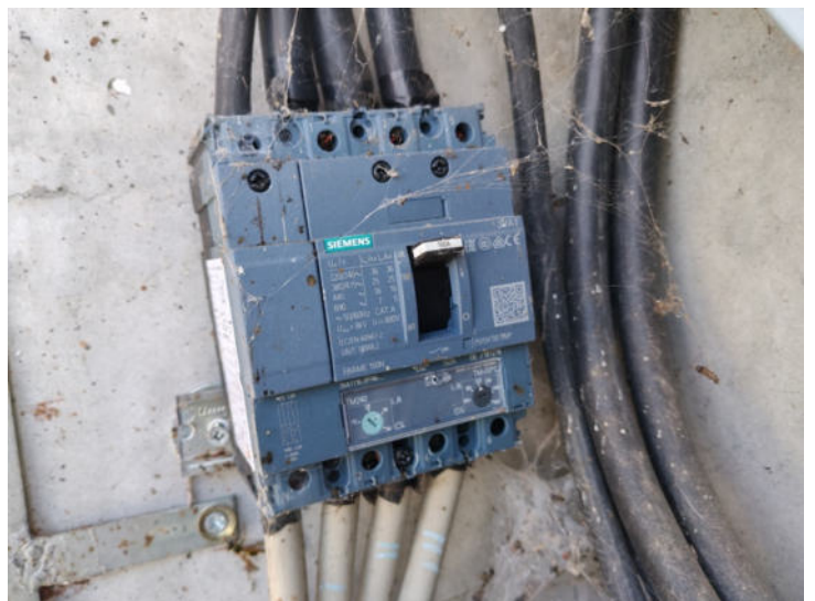
Foto n. 30 – Vista pala eolica – vano contatore
