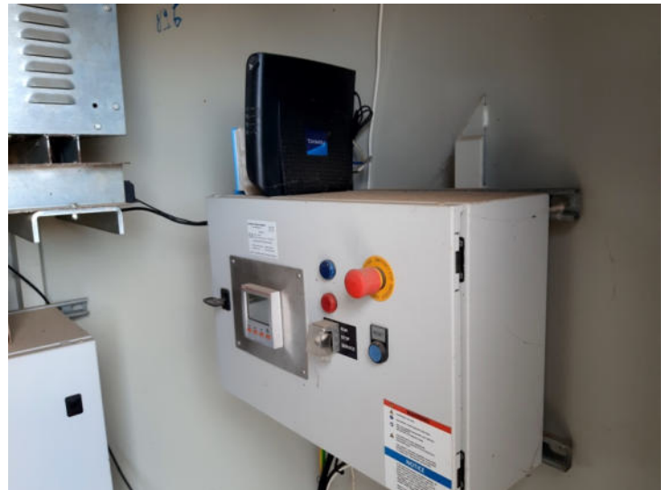
Foto n. 22 – Vista pala eolica – componenti interni
