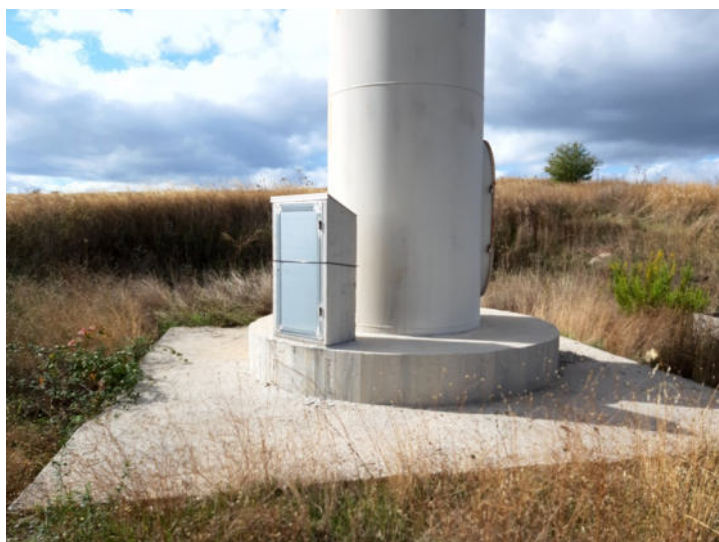
Foto n. 10 – Vista pala eolica - basamento
