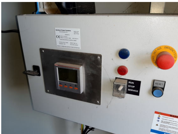
Foto n. 23 – Vista pala eolica – componenti interni
