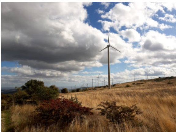
Vista esterna prospetti
