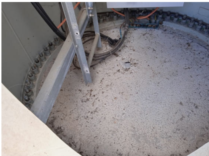
Foto n. 17 – Vista pala eolica – attacco al basamento
