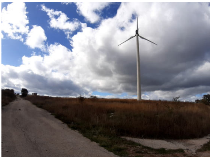
Foto n. 7 – Vista pala eolica
