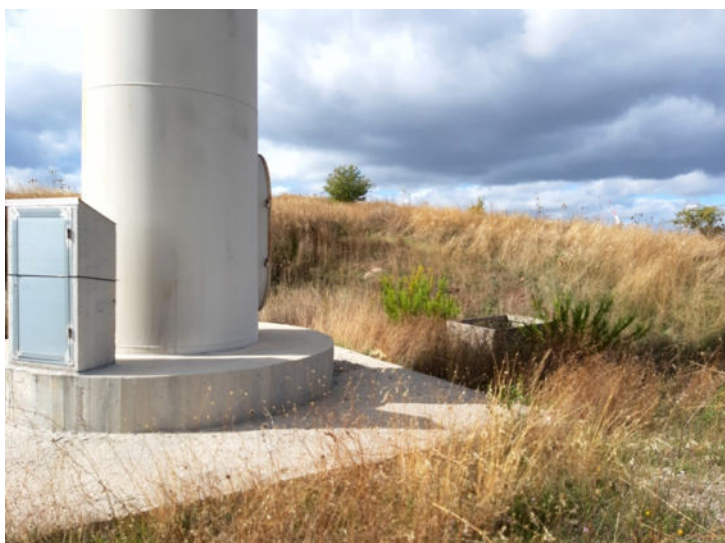
Foto n. 11 – Vista pala eolica - basamento
