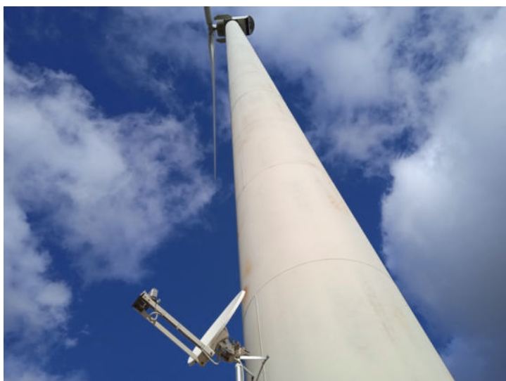
Foto n. 9 – Vista pala eolica
