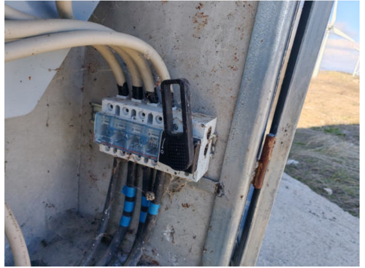
Foto n. 32 – Vista pala eolica – vano contatore
