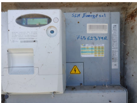
Vista esterna prospetti
