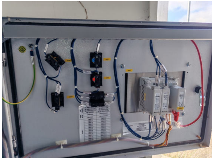
Foto n. 26 – Vista pala eolica – componenti interni
