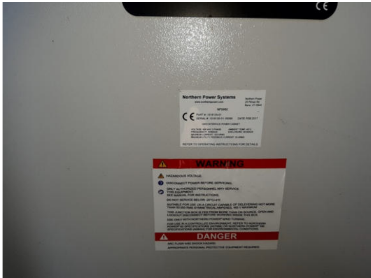
Foto n. 21 – Vista pala eolica – componenti interni
