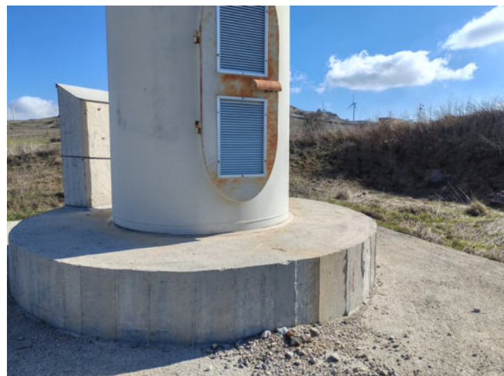
Foto n. 12 – Vista pala eolica - basamento
