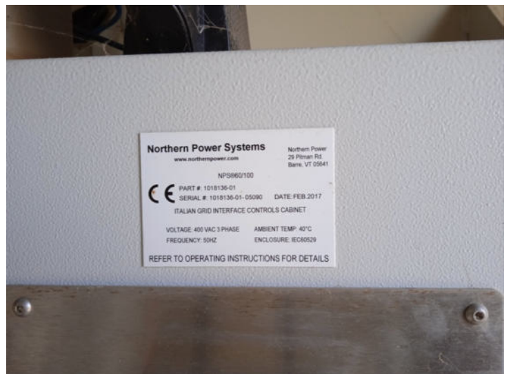
Foto n. 24 – Vista pala eolica – componenti interni
