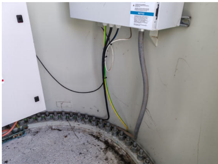
Foto n. 18 – Vista pala eolica – attacco al basamento
