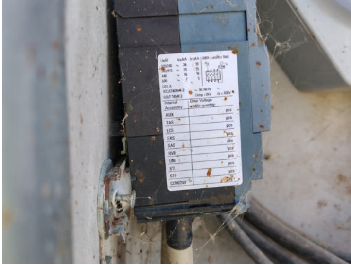
Foto n. 31 – Vista pala eolica – vano contatore
