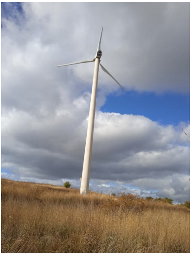
Foto n. 5 – Vista pala eolica
