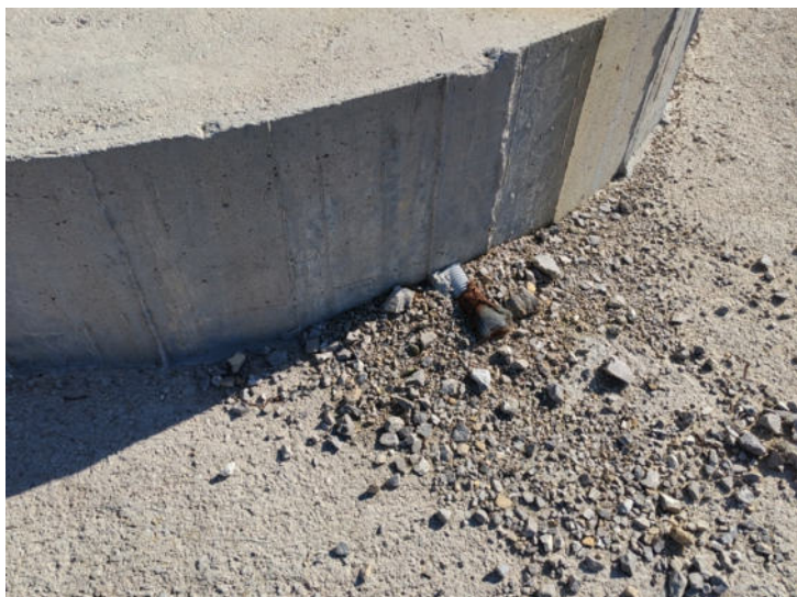
Foto n. 13 – Vista pala eolica - basamento
