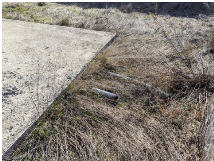
Foto n. 14 – Vista pala eolica - basamento
