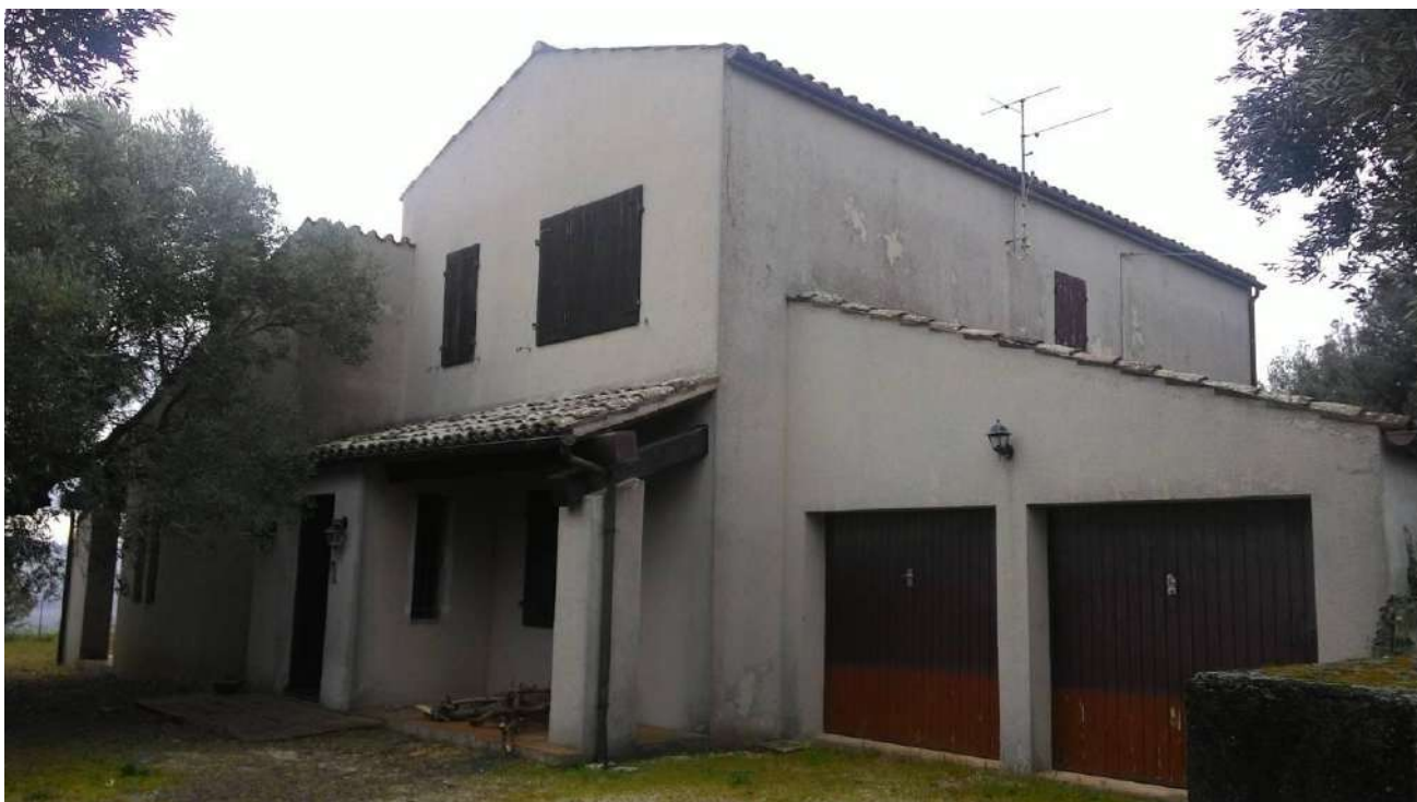
Foto 1: vista complessiva del fronte d'ingresso e garage;
