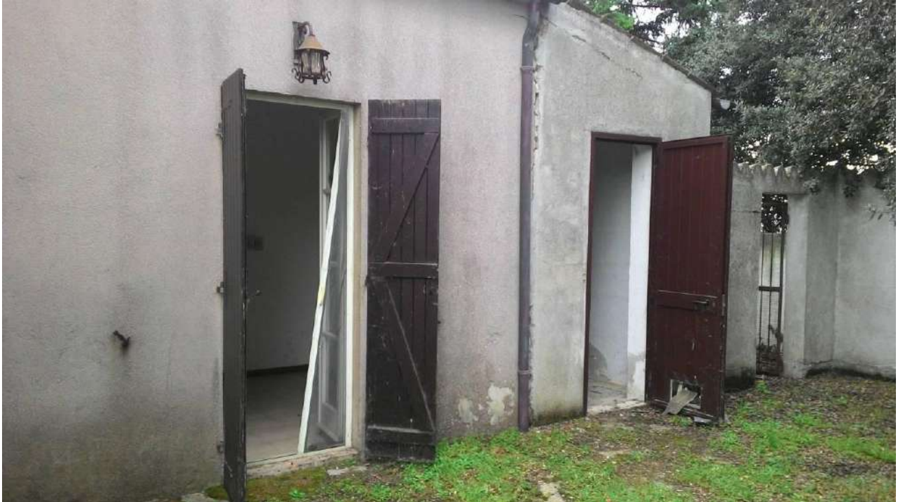
Foto 6: cortile interno con accesso centrale termica a sinistra dell'immagine;
