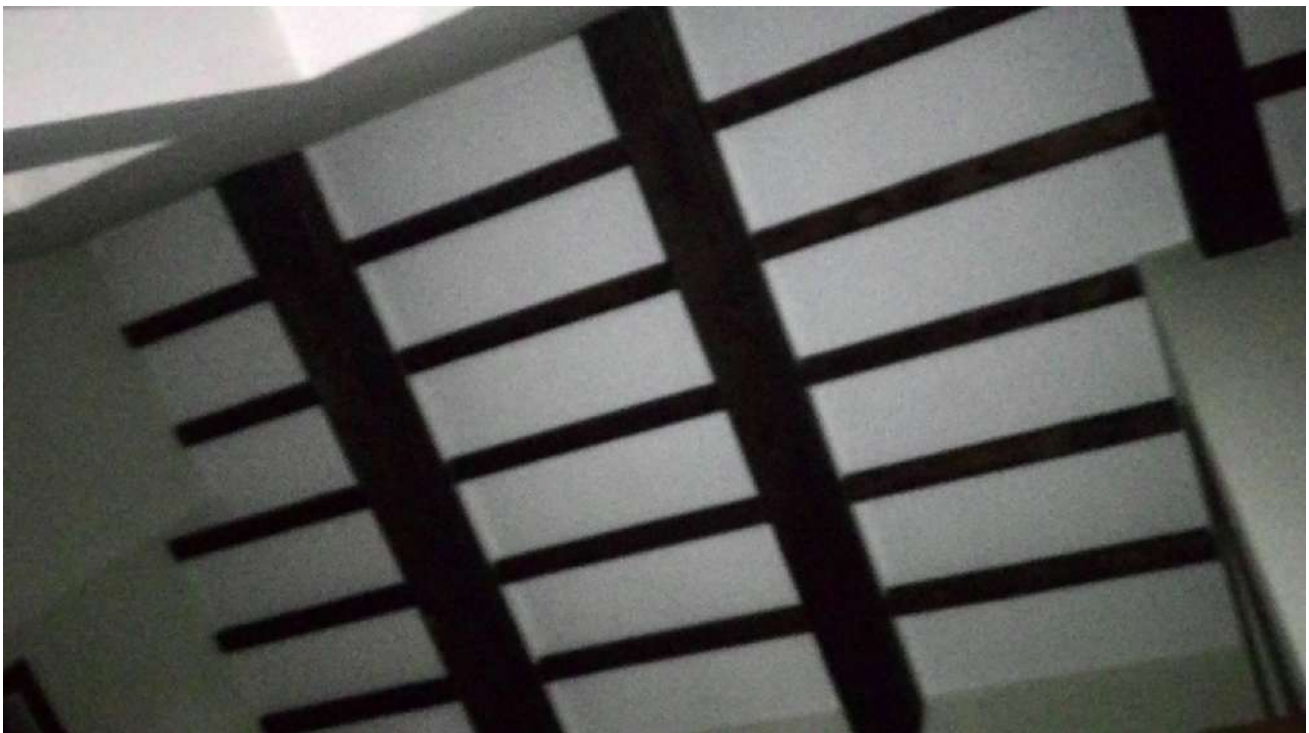
Foto 11: solaio copertura in legno;
