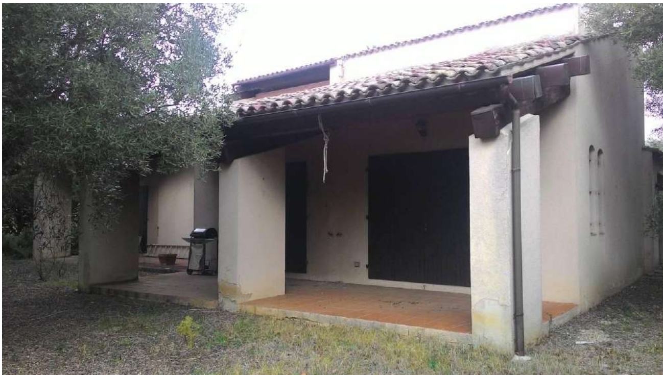
Foto 2: vista del portico lato sud;
