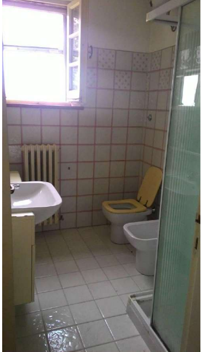
Foto 20: bagno piano terra
