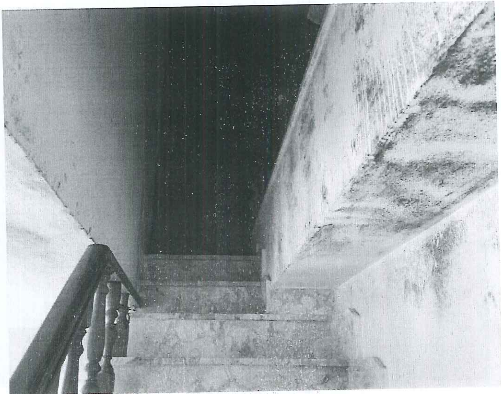
SCALA DI ACCESSO AL PIANO SEMINTERRATO
