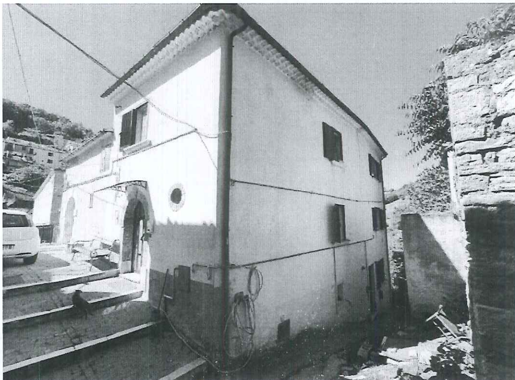
ANGOLO NORD EST FABBRICATO
