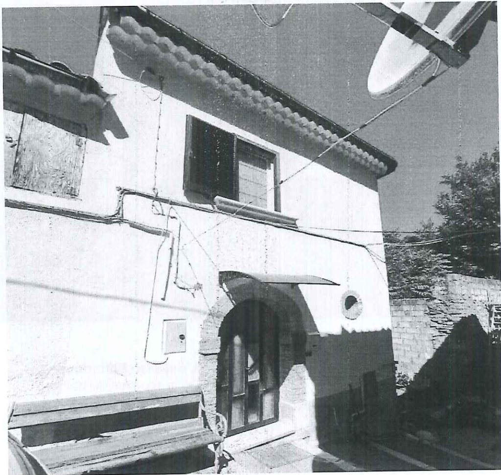
INGRESSO AL PIANO TERRA LATO EST
