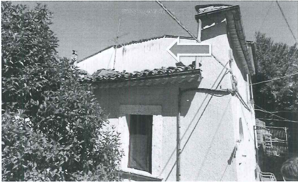
LATO SUD DEL FABBRICATO A CONFINE
