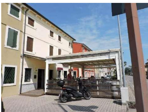
Foto 1 Fronte principale a est
