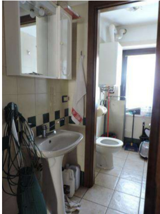
Foto 15 Vano igienico sanitario
