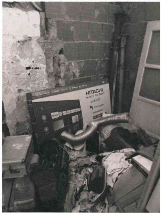
12) W.C. P.T. DA RISTRUTTURARE
