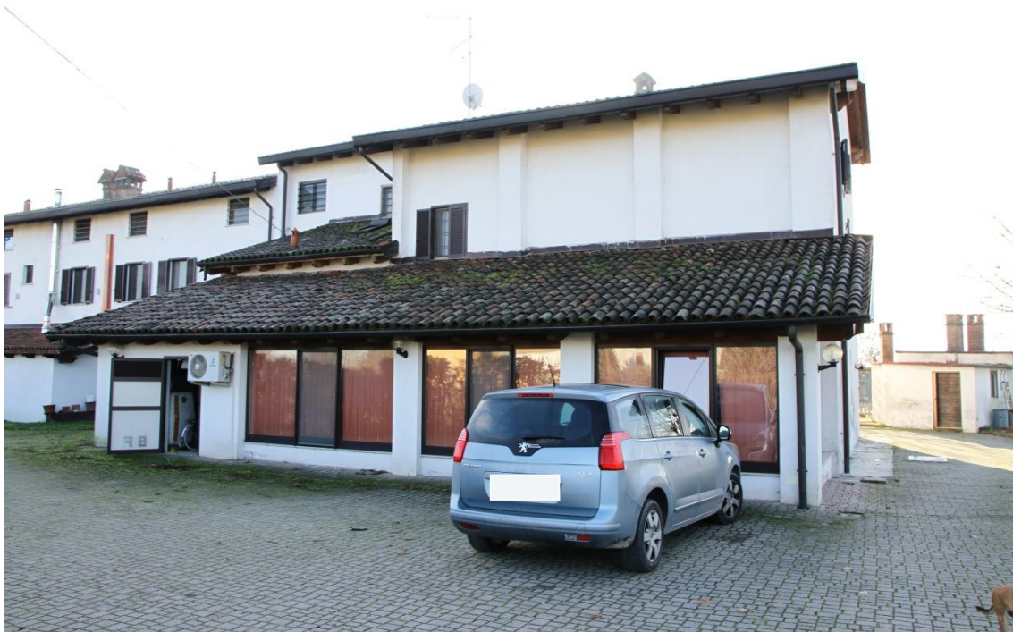
Foto 13: vista d'insieme facciata nord
