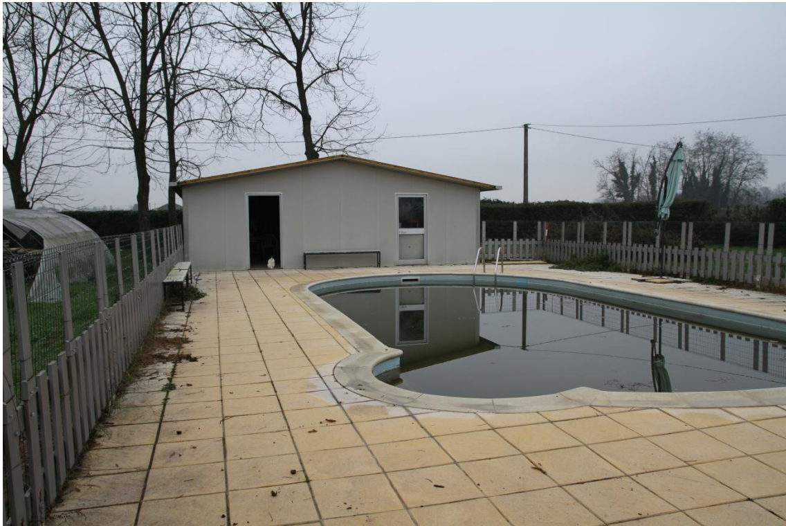
Foto 15: vista d'insieme basso fabbricato A e piscina interrata
