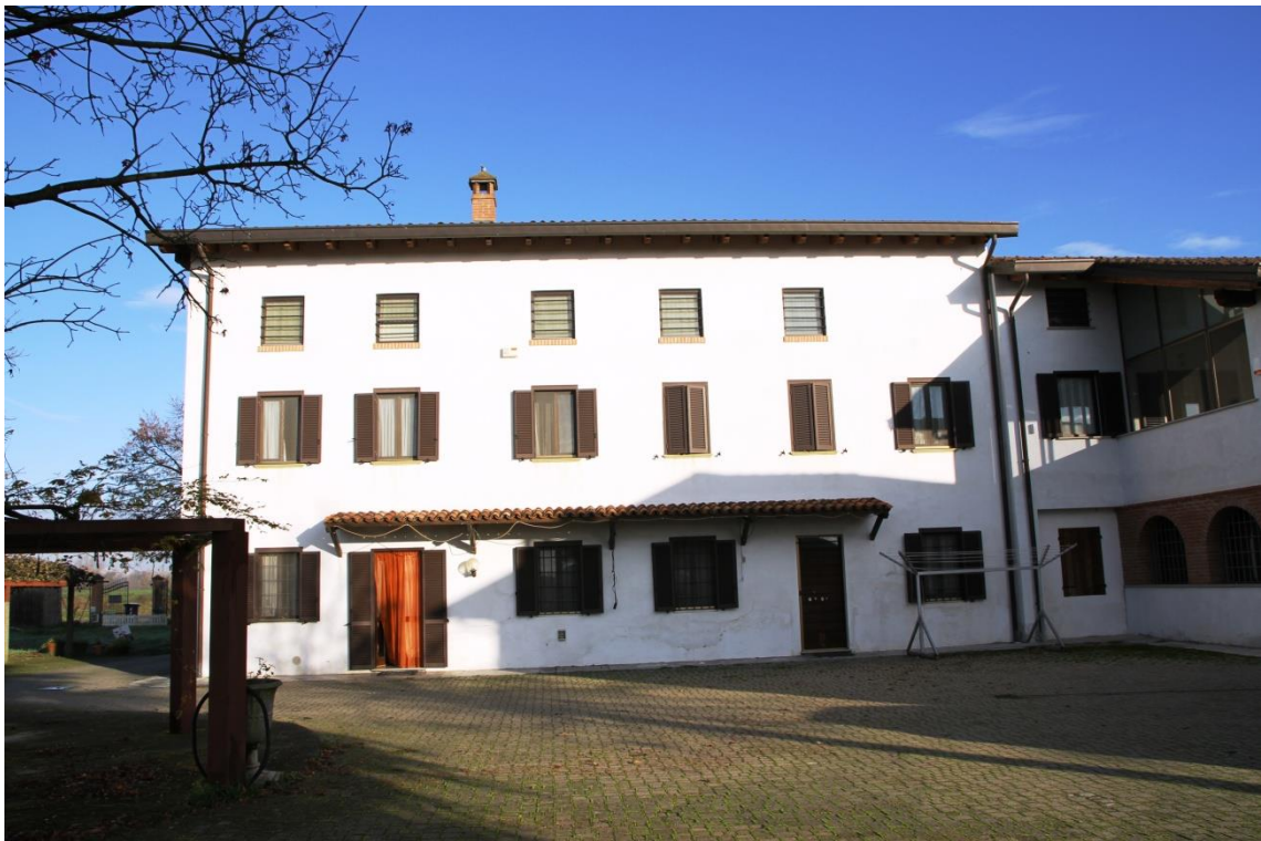
Foto 12: vista d'insieme facciata sud
