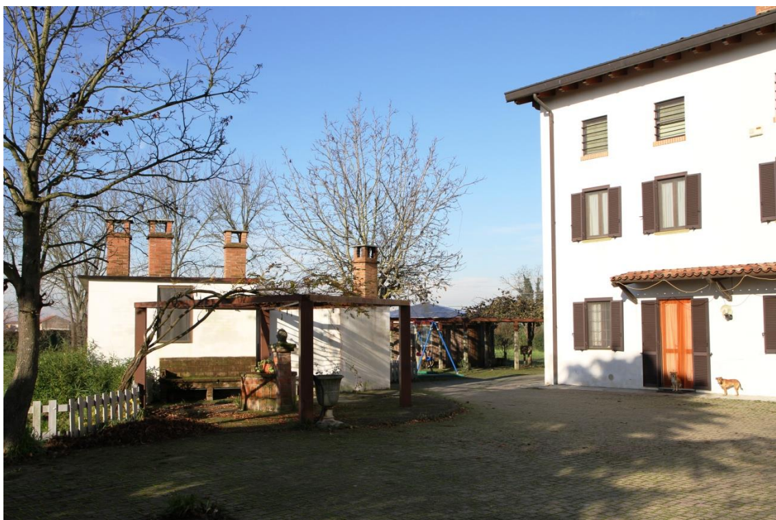
Foto 14: vista d'insieme basso fabbricato ex forno
