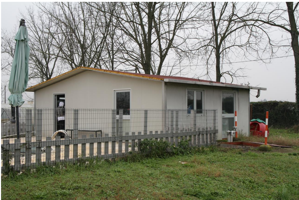
Foto 16: vista d'insieme basso fabbricato A
