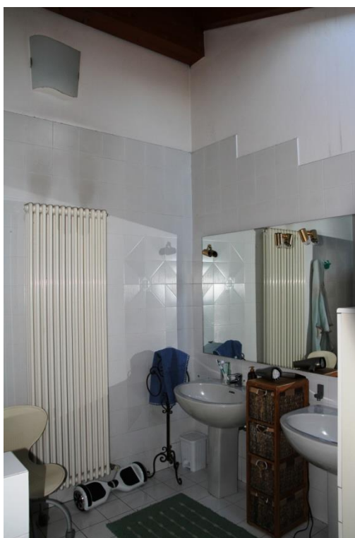
Foto 7: particolare interno bagno 1P
