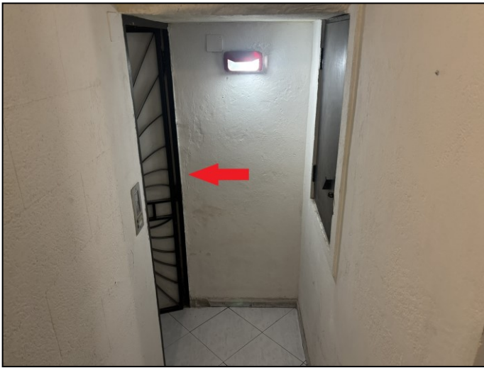
Foto 12 – Porta d'ingresso dal vano scala
