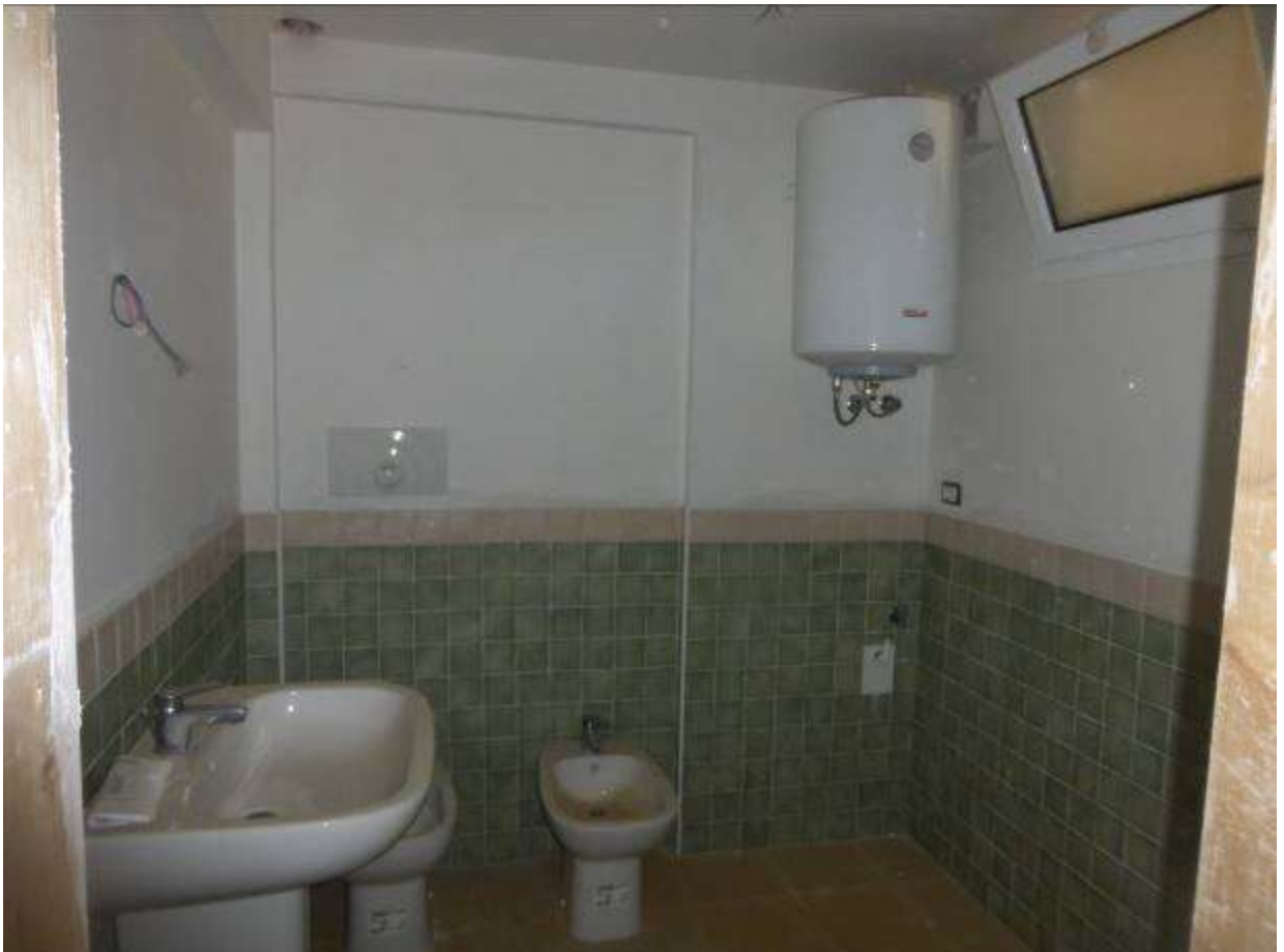
06) Dettaglio interno all'U.I. eseguita (Fg.12 p.IIa 1804 sub.27)-vano 5_bagnetto
