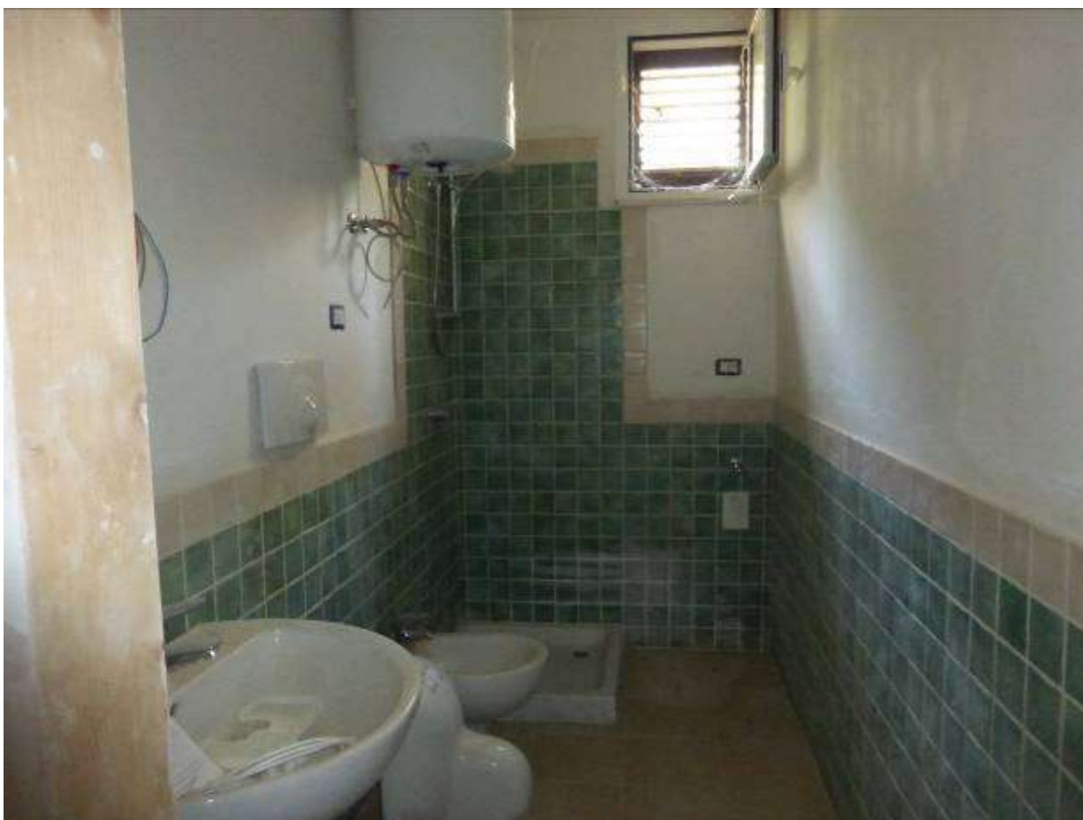
06) Dettaglio interno all'U.I. eseguita (Fg.12 p.Ila 1801 sub.13)-vano 5_bagnetto
