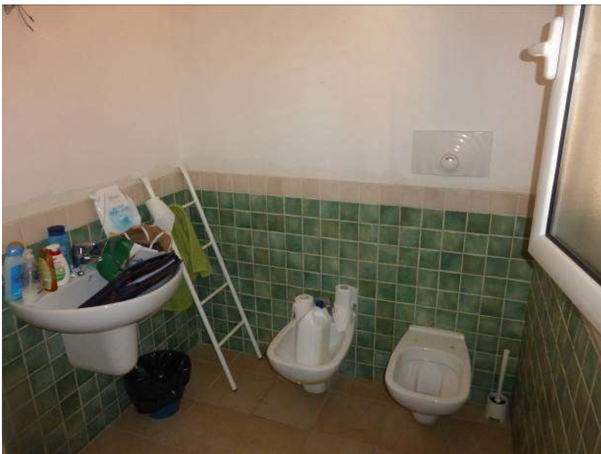
06) Dettaglio interno all'U.I. eseguita (Fg.12 p.IIa 1802 sub.17)-vano 5_bagnetto
