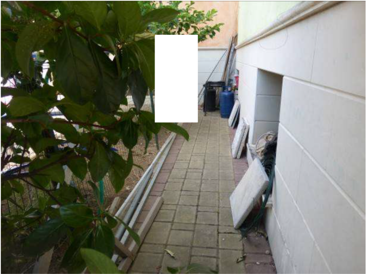
03) Dettaglio interno all'U.I. eseguita (Fg.12 p.Ila 1839/18) - vista verso interno
