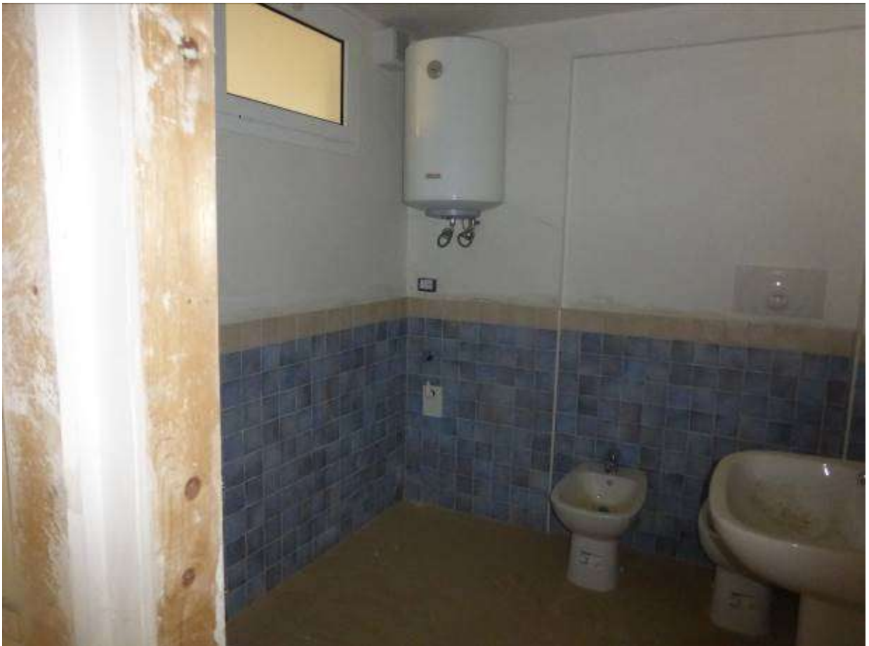
06) Dettaglio interno all'U.I. eseguita (Fg.12 p.Ila 1804 sub.28)-vano 5_bagnetto
