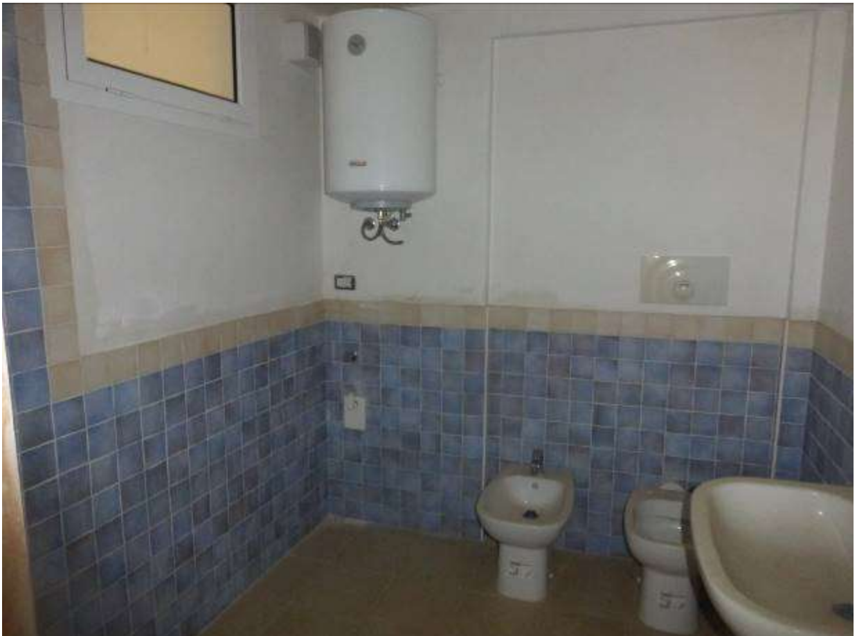
06) Dettaglio interno all'U.I. eseguita (Fg.12 p.Ila 1804 sub.26)-vano 5_bagnetto
