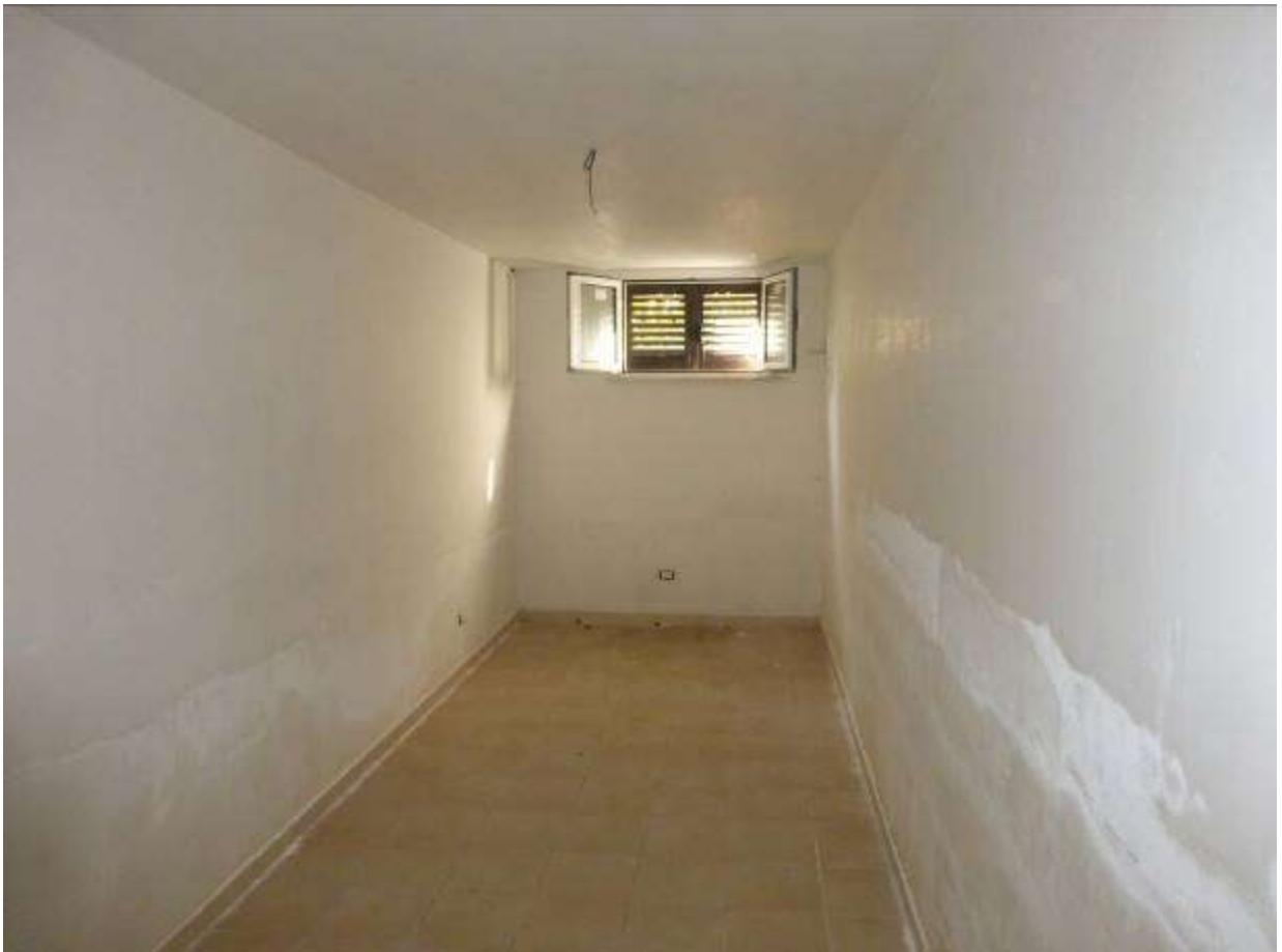
04) Dettaglio interno all'U.I. eseguita (Fg.12 p.IIa 1804 sub.30) – vano 3_camera
