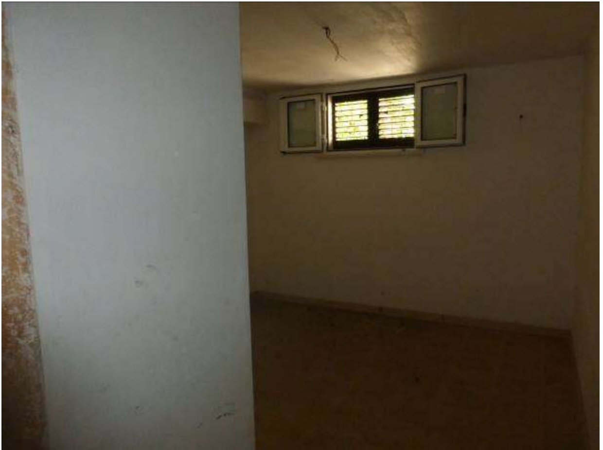
05) Dettaglio interno all'U.I. eseguita (Fg.12 p.IIa 1804 sub.29) - vano 4_camera
