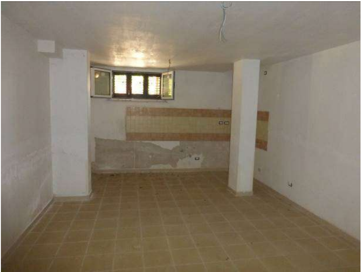
03) Dettaglio interno all'U.I. eseguita (Fg.12 p.Ila 1804 sub.27)- vano 1_ingresso
