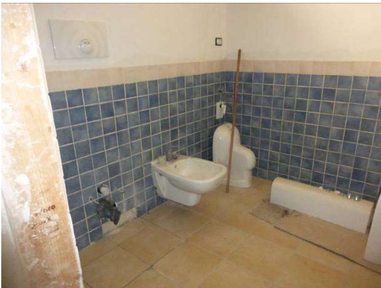
06) Dettaglio interno all'U.I. eseguita (Fg.12 p.IIa 1802 sub.18)-vano 5_bagnetto
