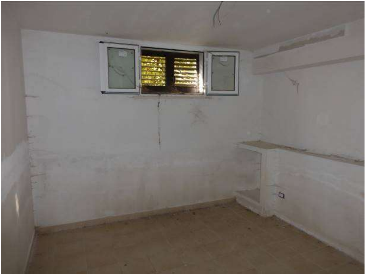
05) Dettaglio interno all'U.I. eseguita (Fg.12 p.IIa 1804 sub.30) - vano 4_camera
