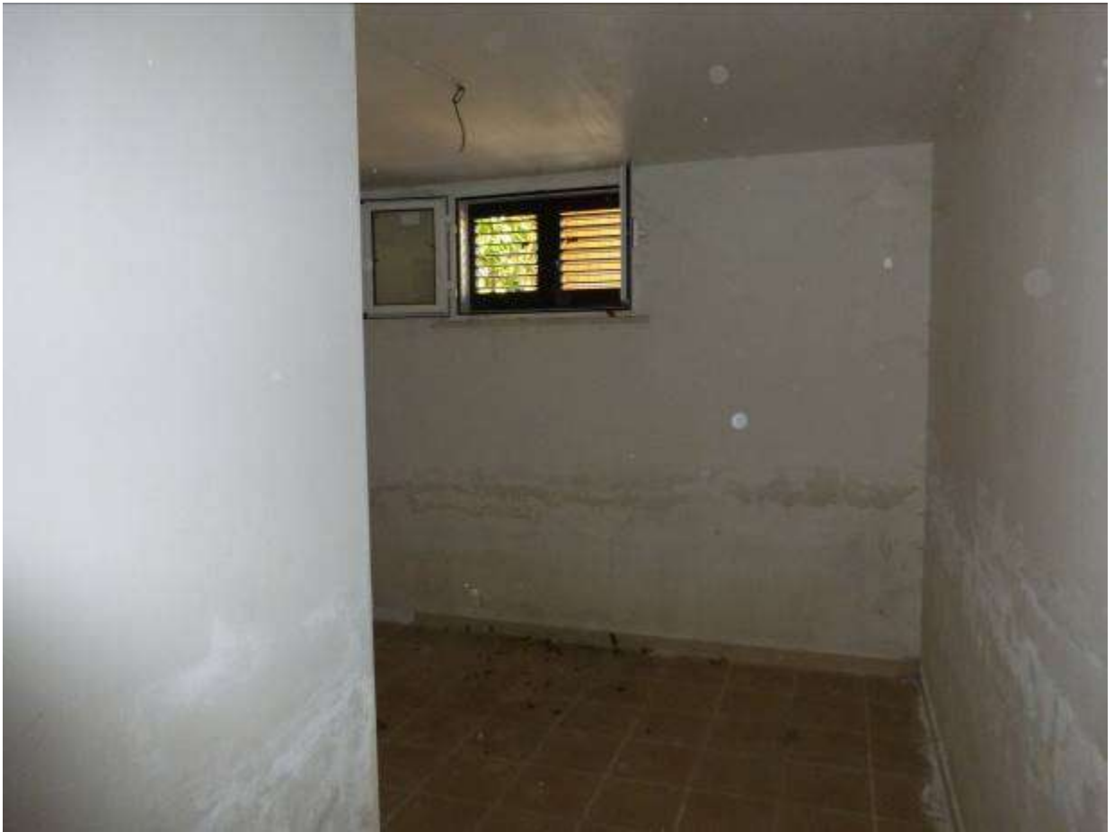
05) Dettaglio interno all'U.I. eseguita (Fg.12 p.IIa 1804 sub.27) - vano 4_camera
