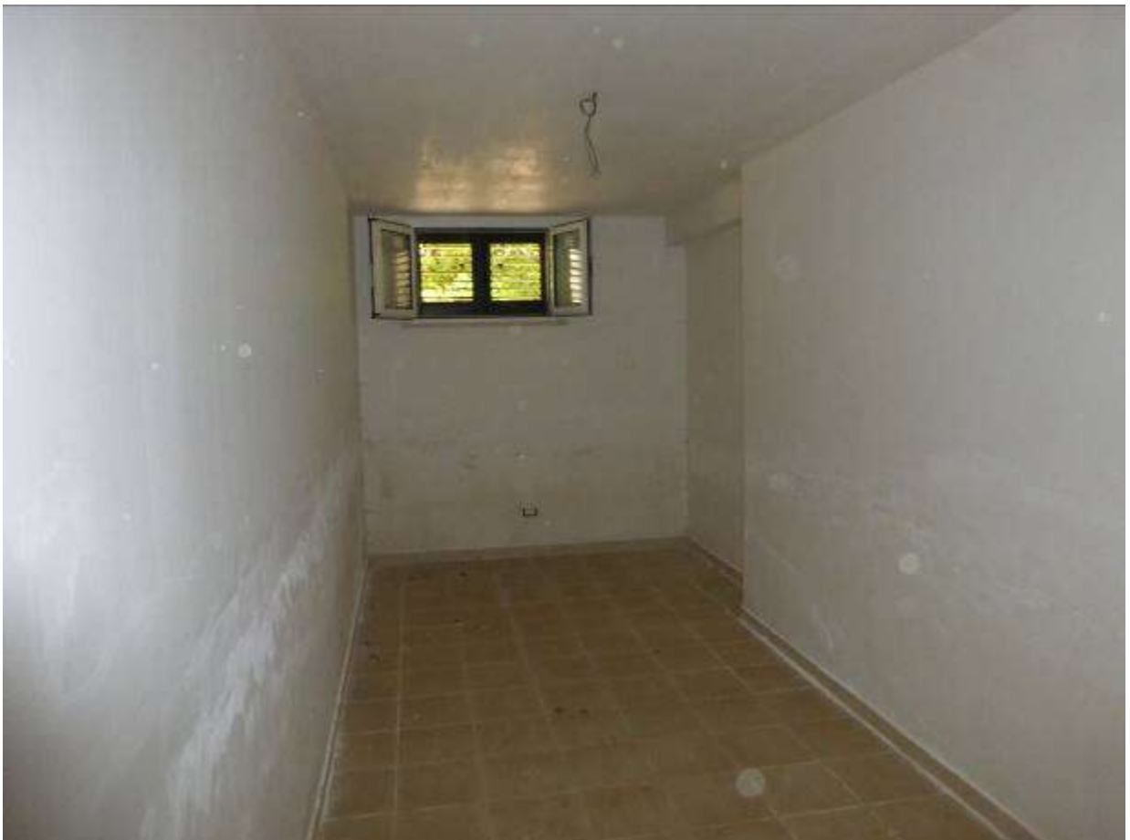
04) Dettaglio interno all'U.I. eseguita (Fg.12 p.Ila 1804 sub.27) - vano 3_camera
