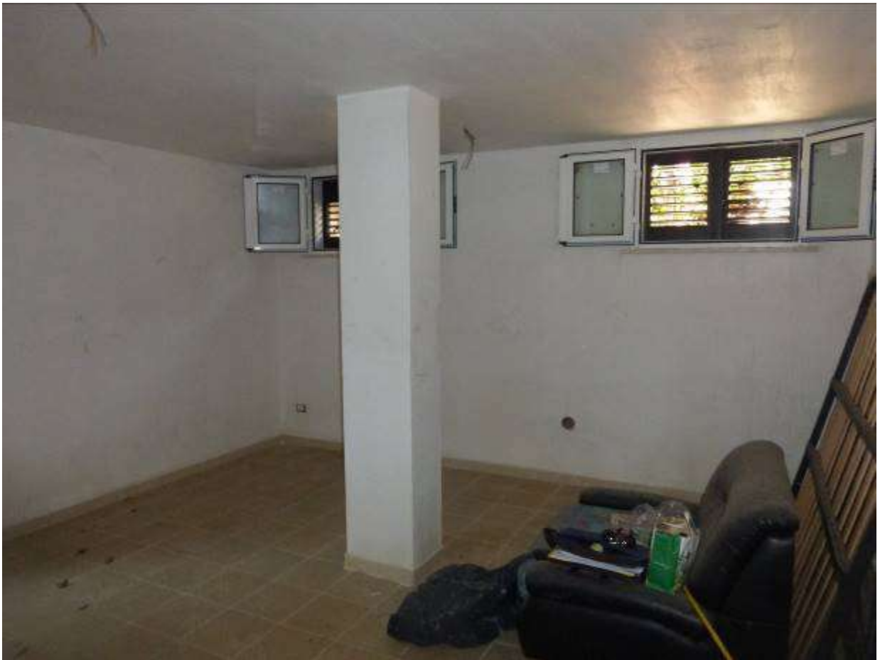
03) Dettaglio interno all'U.I. eseguita (Fg.12 p.Ila 1804 sub.26)- vano 1_ingresso
