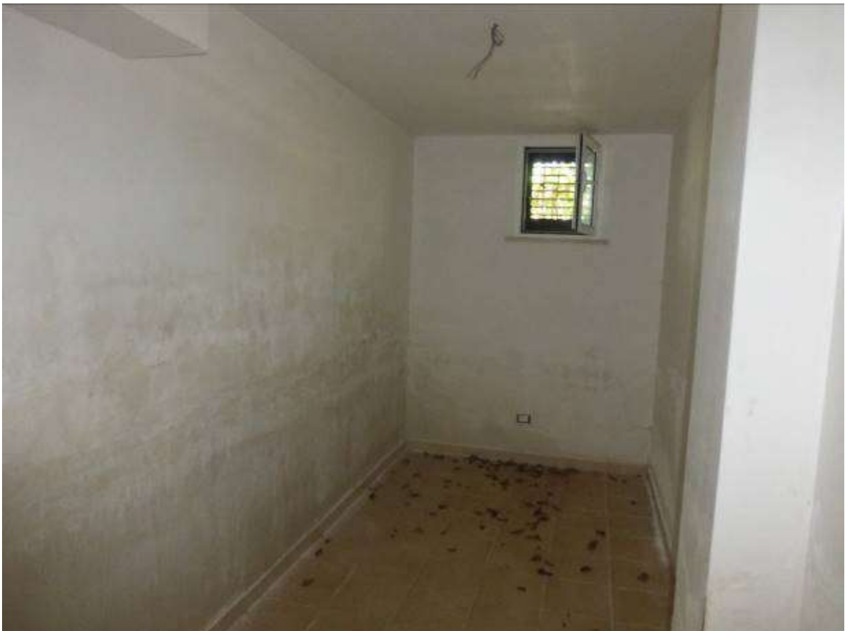
04) Dettaglio interno all'U.I. eseguita (Fg.12 p.IIa 1804 sub.1) - vano 3_camera
