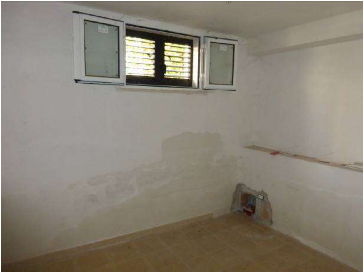
05) Dettaglio interno all'U.I. eseguita (Fg.12 p.Ila 1804 sub.28) - vano 4_camera
