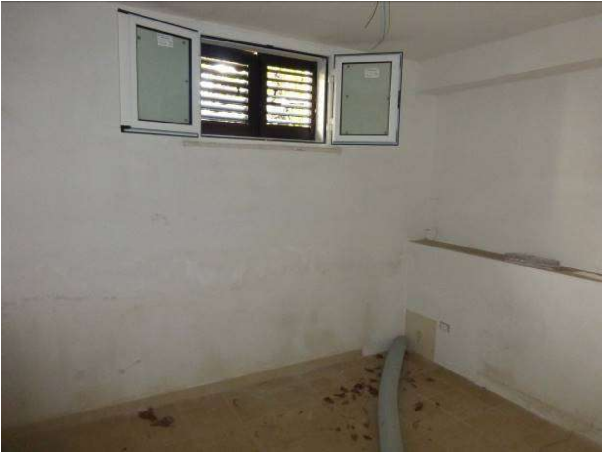
05) Dettaglio interno all'U.I. eseguita (Fg.12 p.Ila 1804 sub.26) - vano 4_camera
