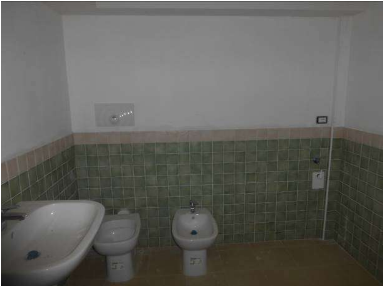
06) Dettaglio interno all'U.I. eseguita (Fg.12 p.IIa 1804 sub.29)-vano 5_bagnetto
