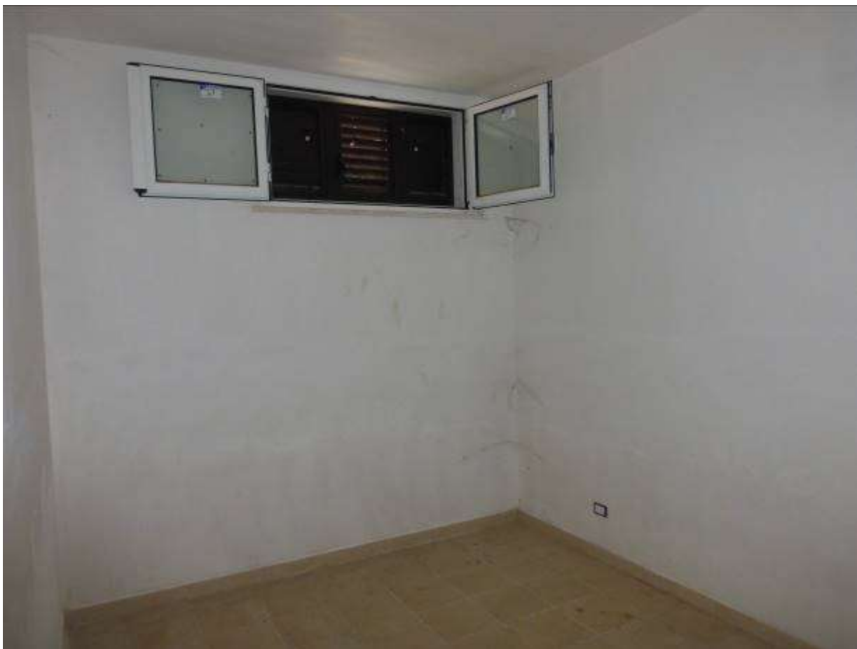
05) Dettaglio interno dell'U.I. eseguita (Fg.12 p.Ila 1801 sub.13)-vano 4_camera
