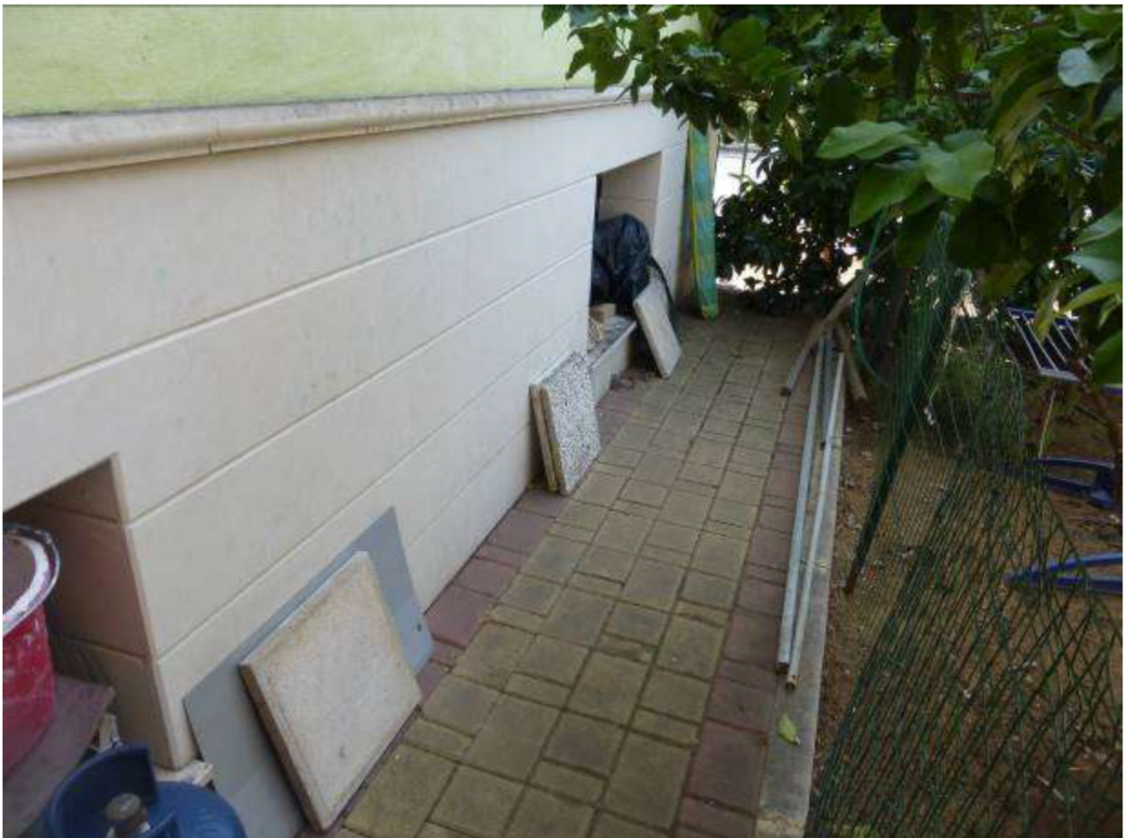
04) Dettaglio interno all'U.I. eseguita (Fg.12 p.Ila 1839/18) - vista verso esterno
