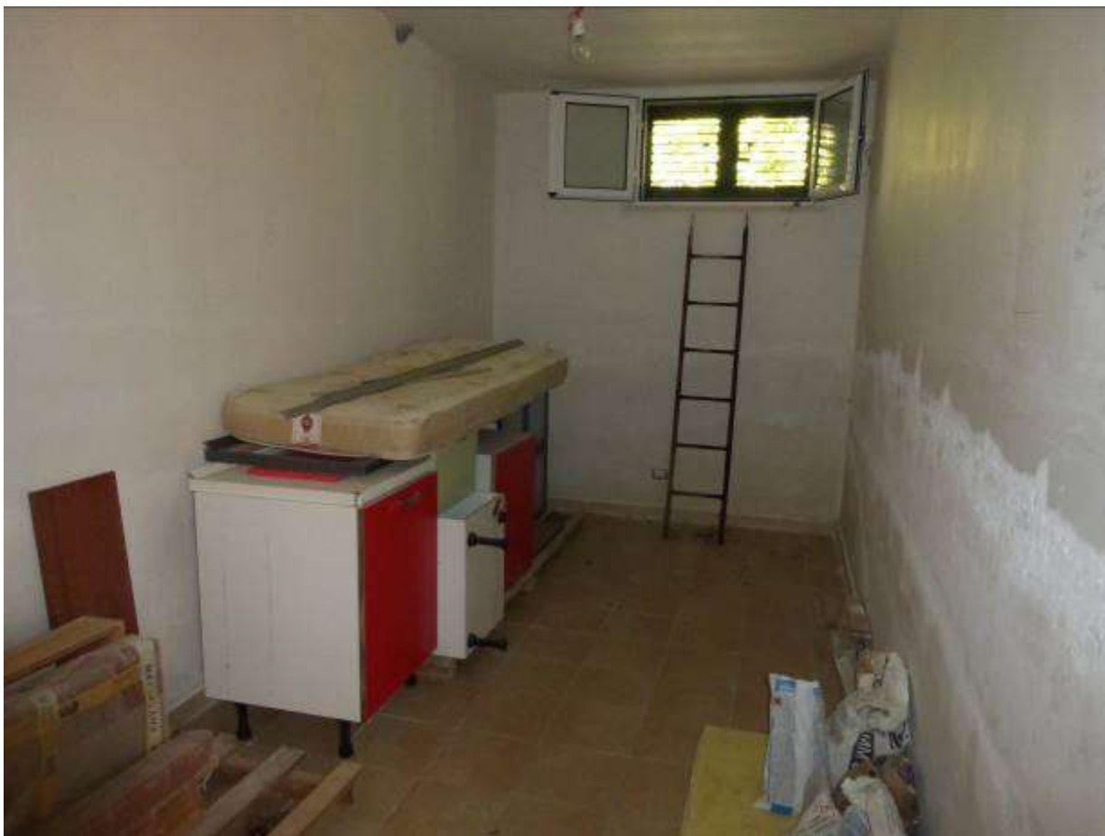
05) Dettaglio interno dell'U.I. eseguita (Fg.12 p.IIa 1802 sub.18)-vano 3_camera
