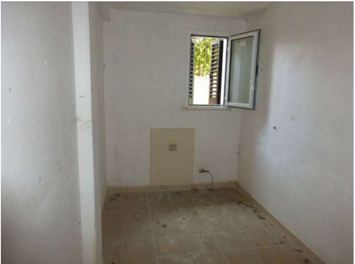
04) Dettaglio interno all'U.I. eseguita (Fg.12 p.Ila 1804 sub.26) - vano 3_camera
