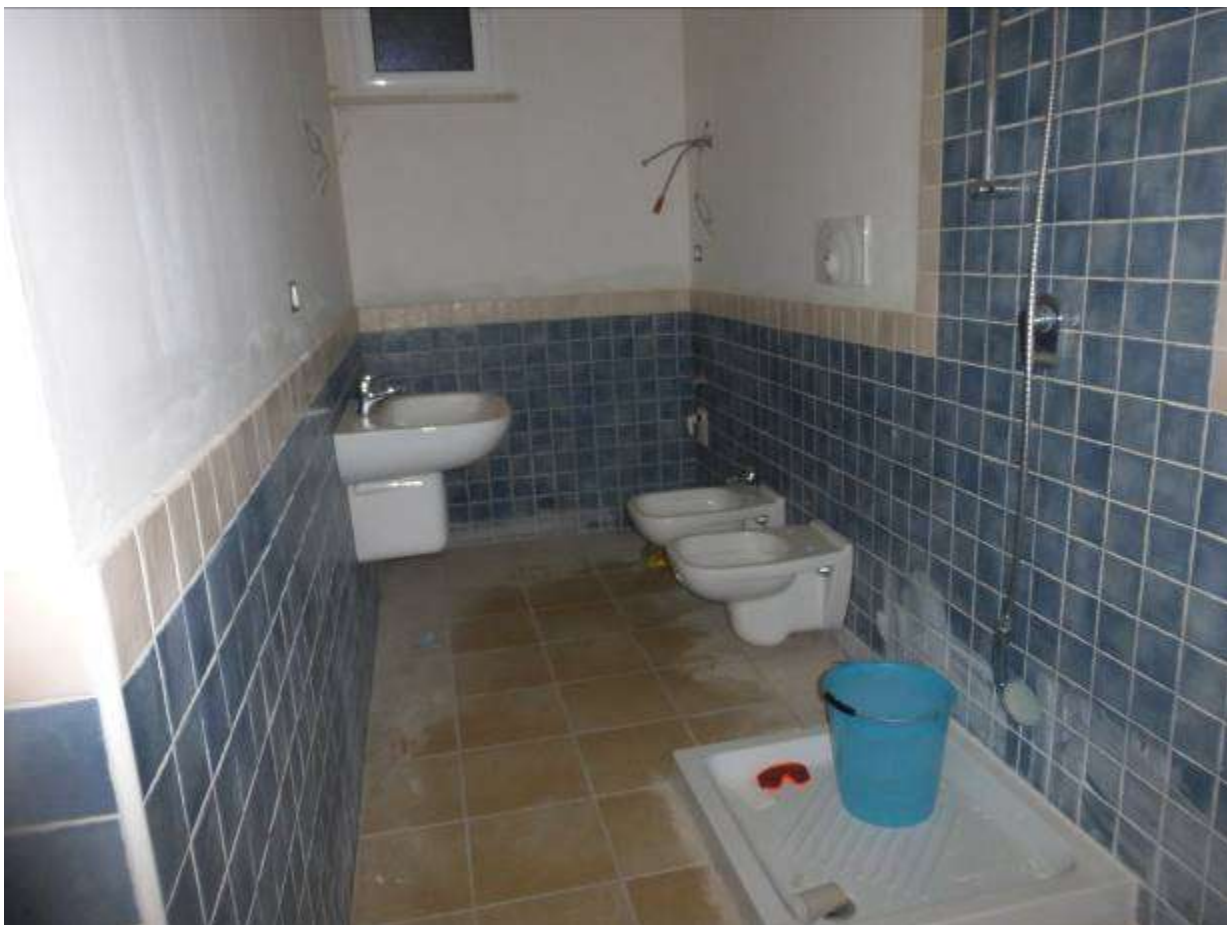
06) Dettaglio interno all'U.I. eseguita (Fg.12 p.IIa 1802 sub.5) - vano 4_bagnetto
