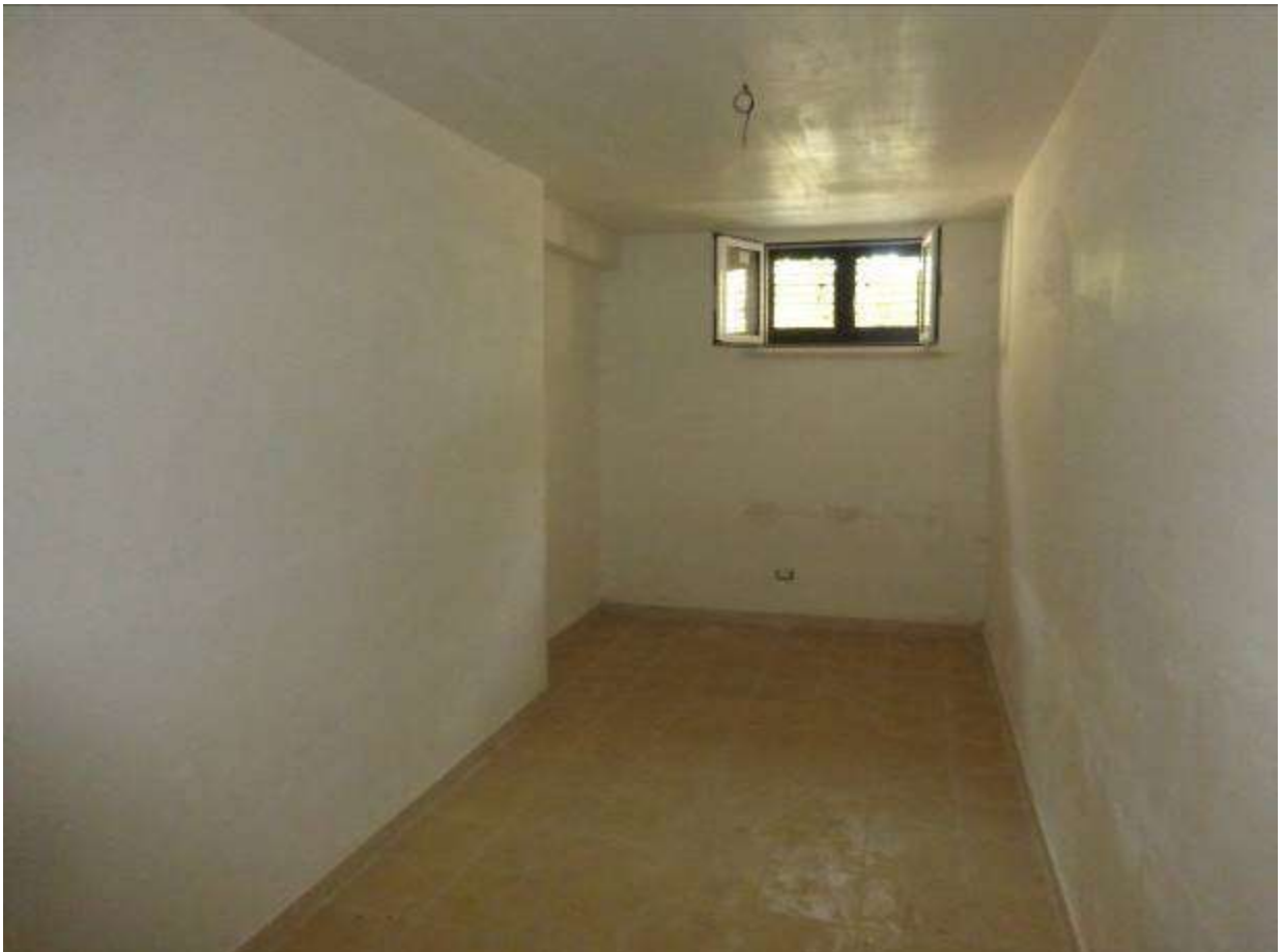
04) Dettaglio interno all'U.I. eseguita (Fg.12 p.IIa 1804 sub.28) - vano 3_camera
