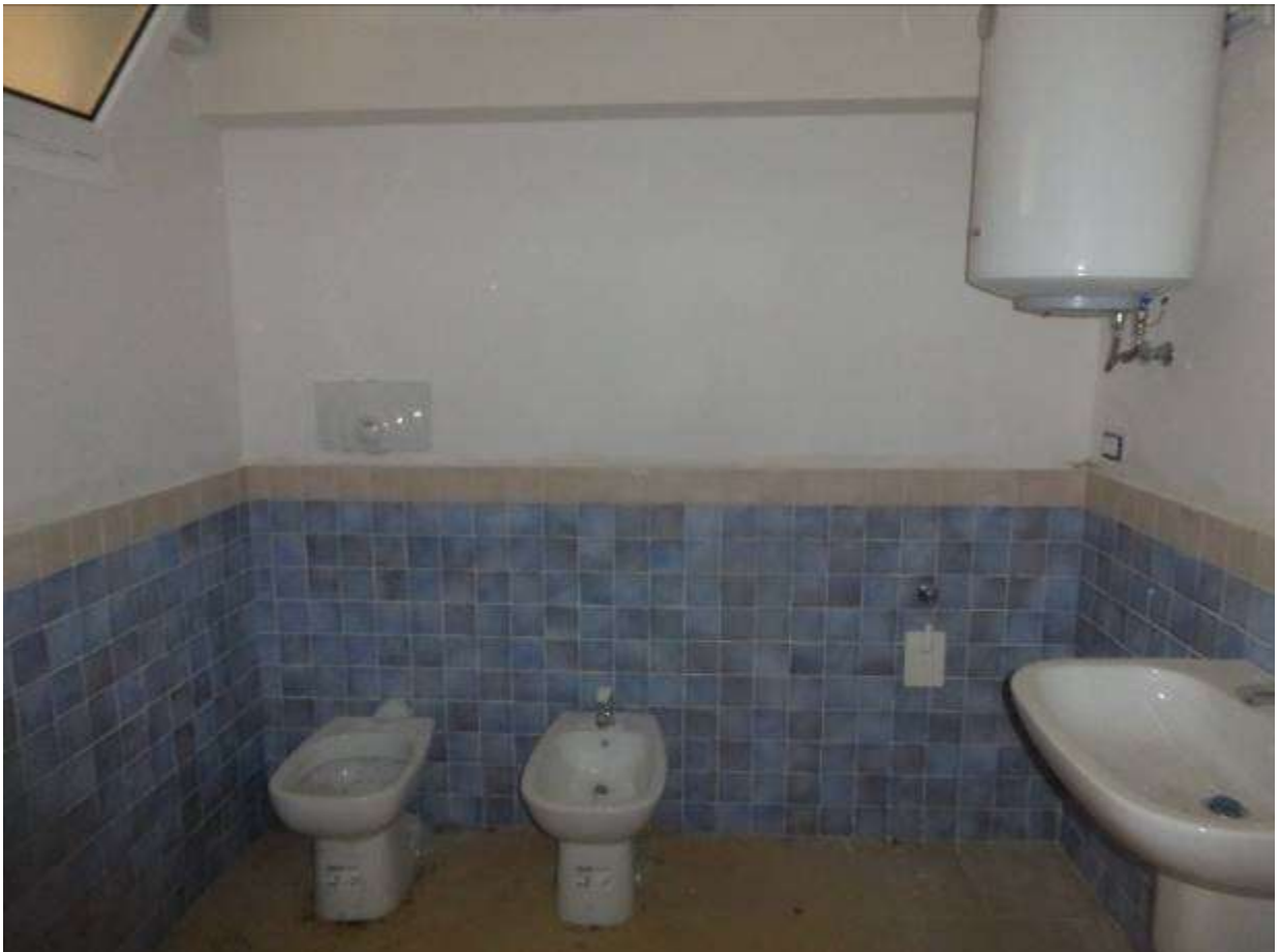
06) Dettaglio interno all'U.I. eseguita (Fg.12 p.IIa 1804 sub.30)-vano 5_bagnetto
