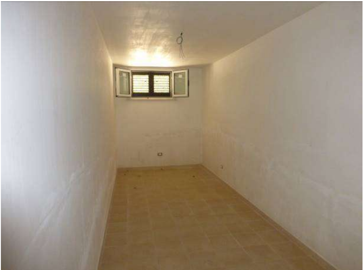
04) Dettaglio interno all'U.I. eseguita (Fg.12 p.IIa 1804 sub.29) – vano 3_camera
