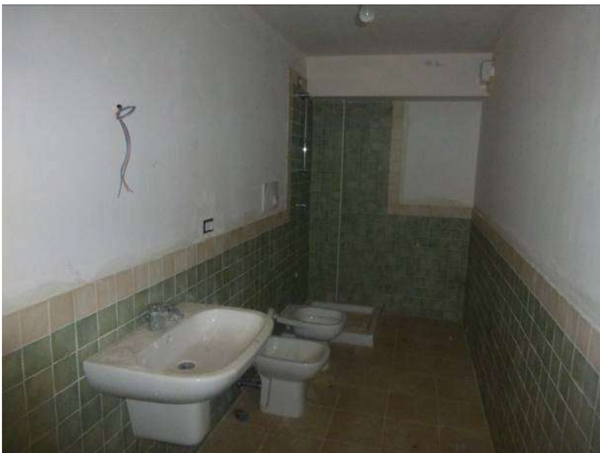
06) Dettaglio interno all'U.I. eseguita (Fg.12 p.Ila 1804 sub.1) - vano 5_bagnetto
