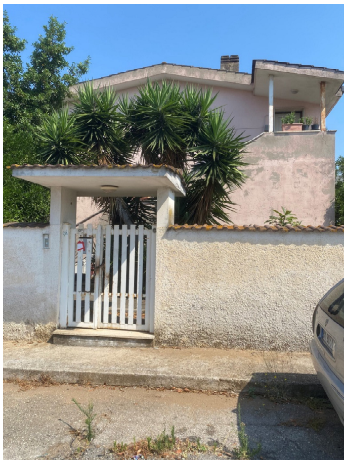
Accesso pedonale alla corte comune all'intero fabbricato
