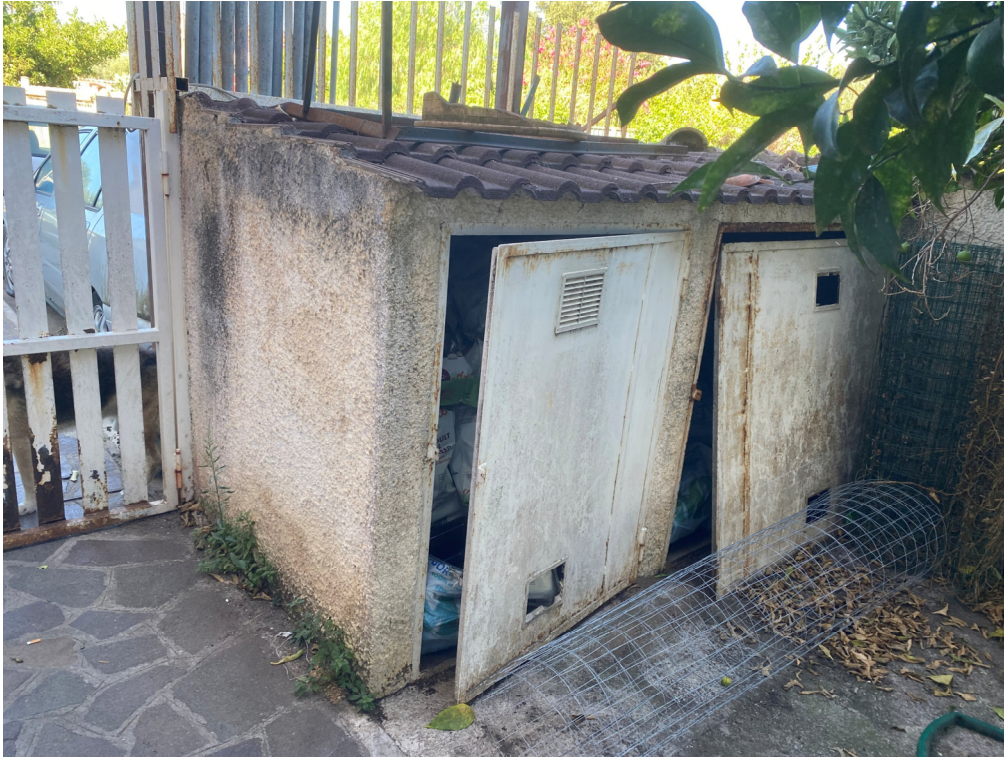
Ripostiglio (da demolire) – delimitazione corte
