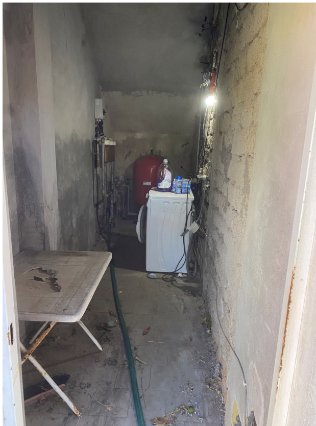
Cantina posta al piano terra (sottoscala)
