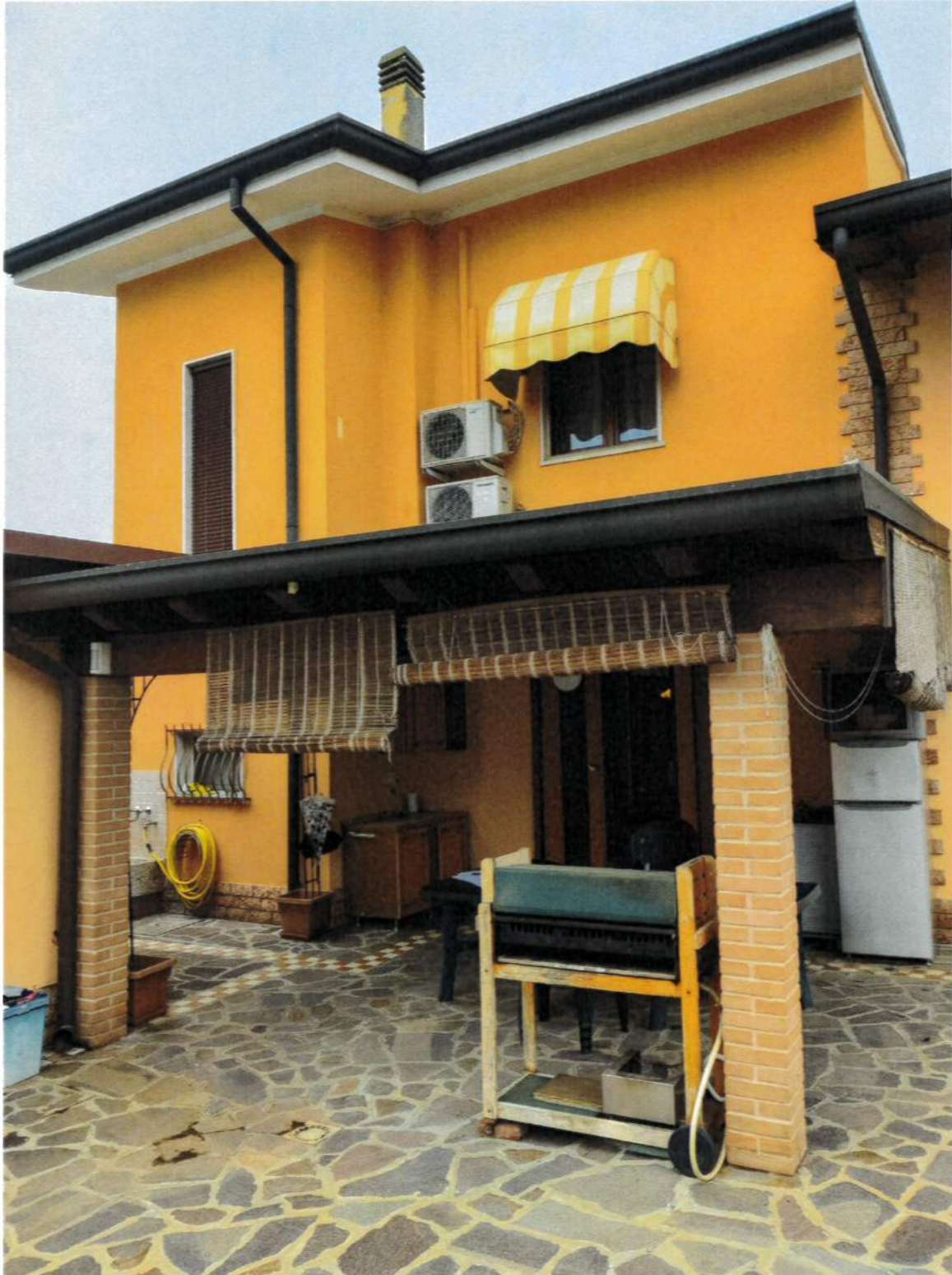
Fotografia 09 – Abitazione 32/5 – portico abusivo
