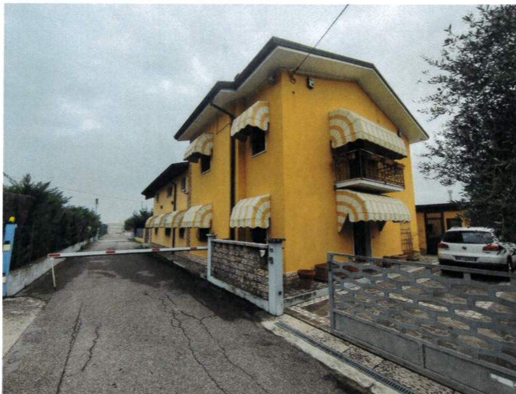
Fotografia 01 – Vista esterna del complesso da Via Cesure
