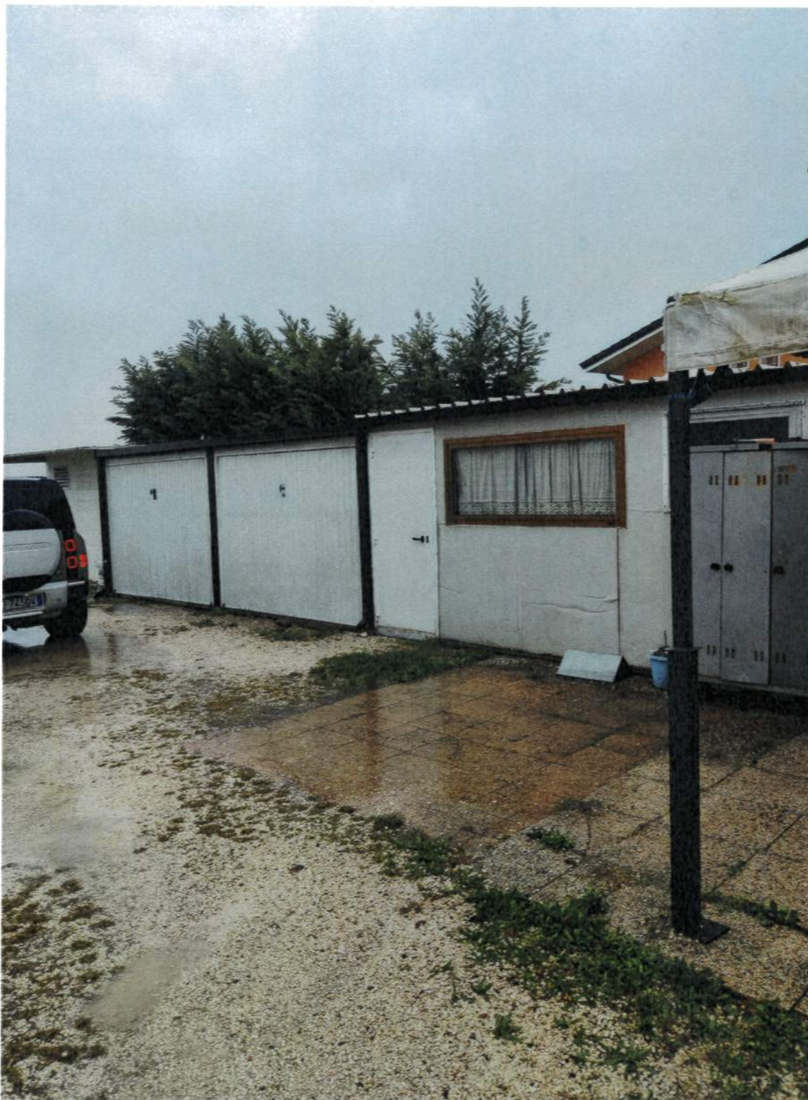
Fotografia 01 – Autorimessa esterna con superfetazioni da demolire
