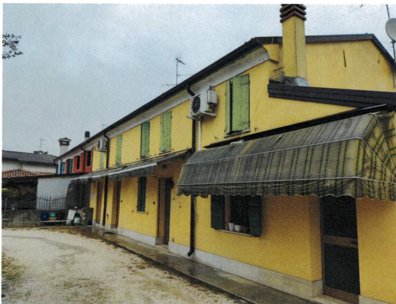
Fotografia 02 – Vista esterna del complesso immobiliare
