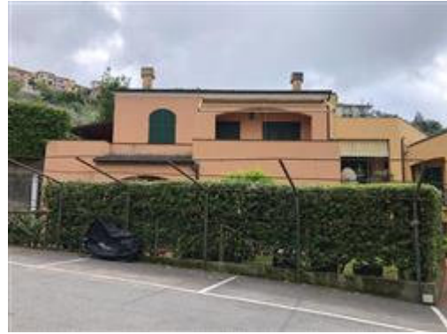
fabbricato l'Ulivo via Ravezza civ. 74 viste esterne
