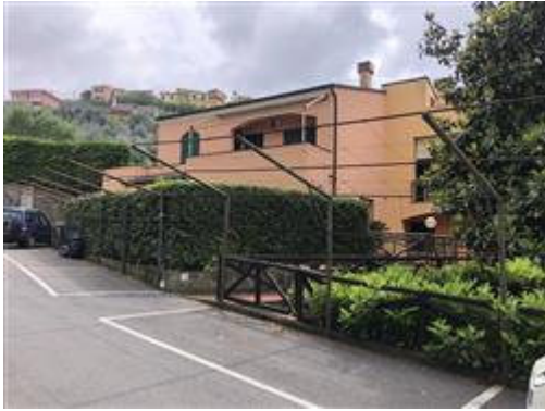
fabbricato l'Ulivo via Ravezza civ. 74 viste esterne
