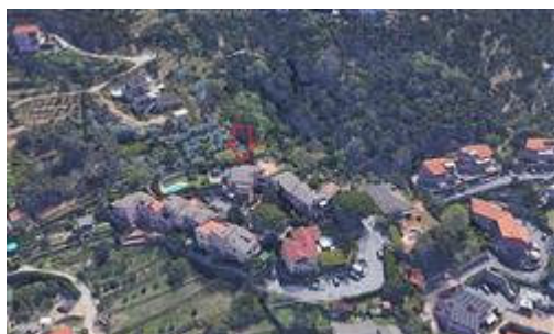
Fabbricato civ. 74 vista volo d'uccello
