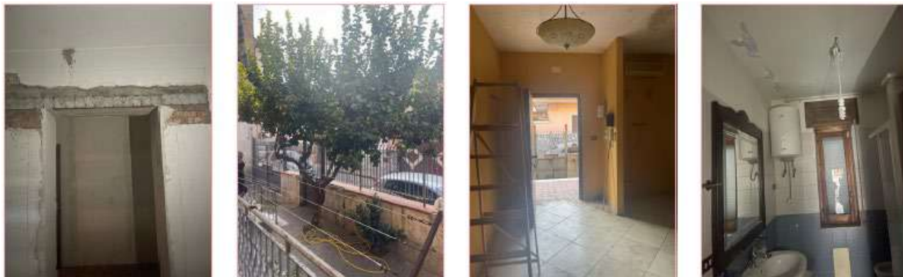
Figura 6: Piano Rialzato – Interno Appartamento 1
