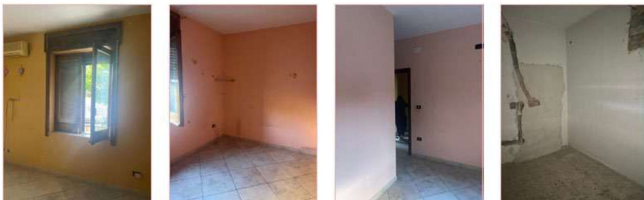
Figura 7: Piano Rialzato – Interno Appartamento 2
