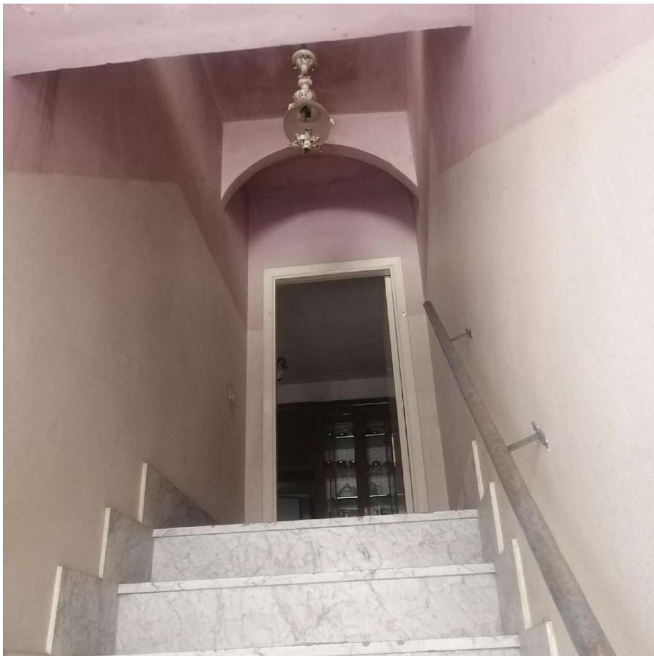
RAMPA DI ACCESSO AL PIANO PRIMO
