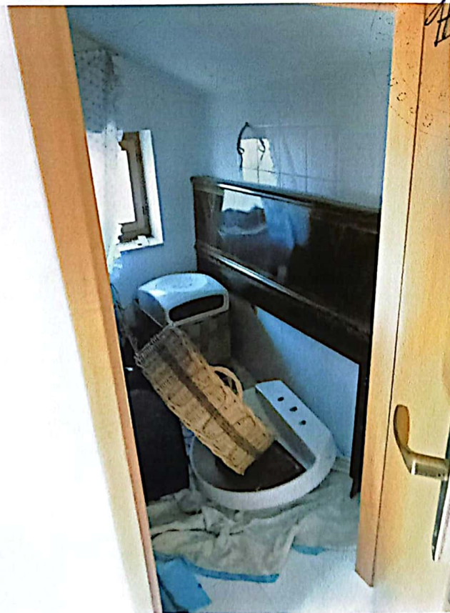
BAGNO - "LOCALE DEPOSITO" (SOTTOTETTO)
